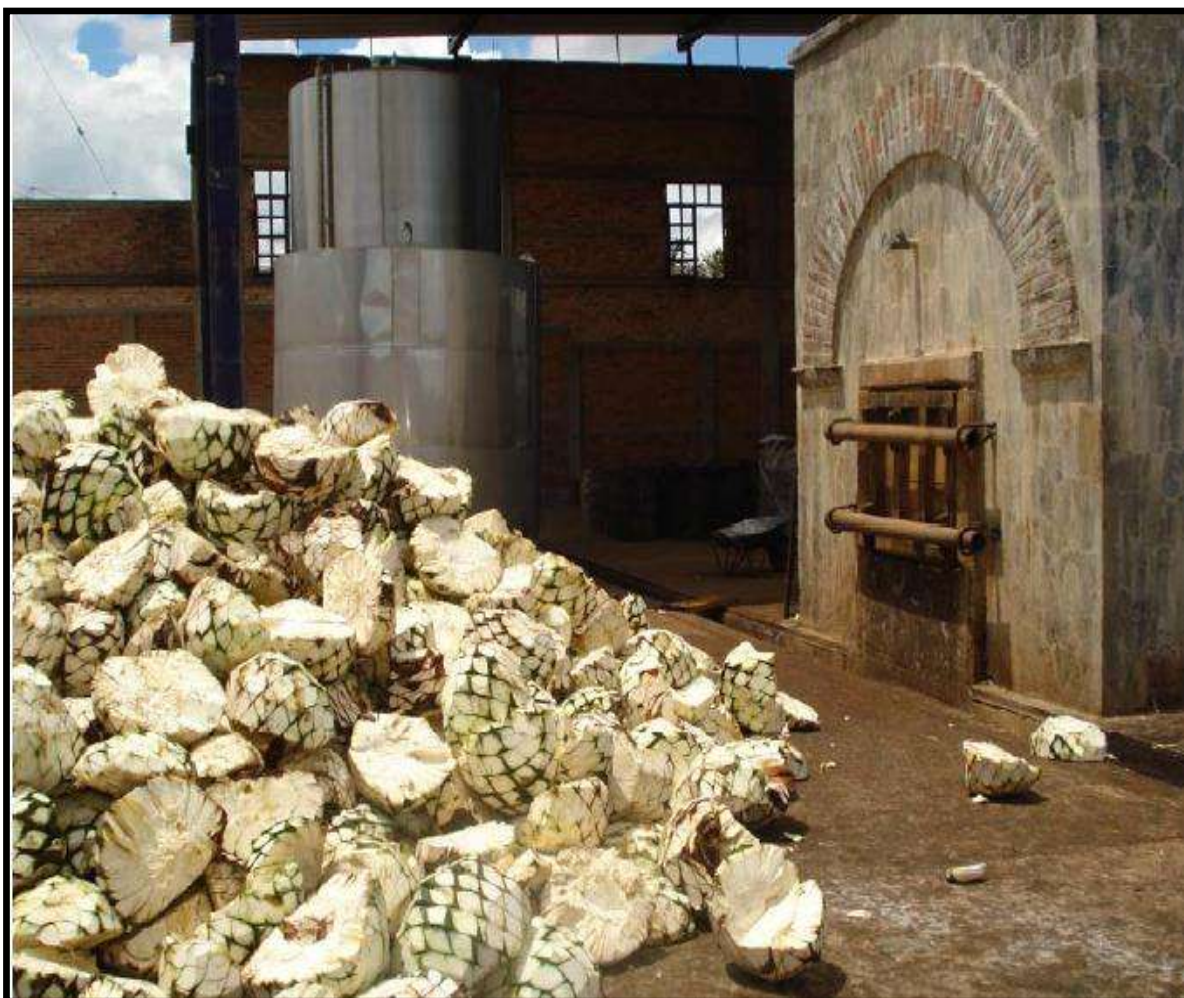
Figura 2. Horno de mampostería.
