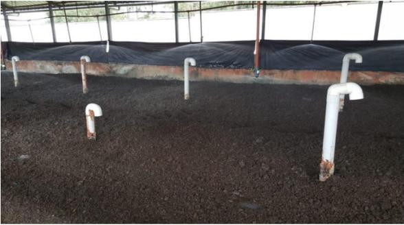
Figura 3.1. Aspersores de aguas residuales y aireadores del biofiltro (Ramírez, 2021).
