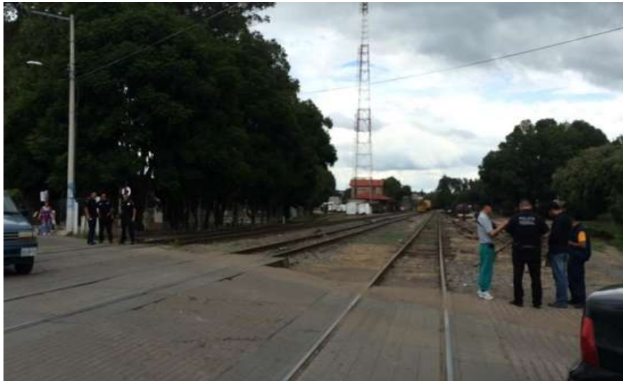
Vías del tren de Maravatío Michoacán
