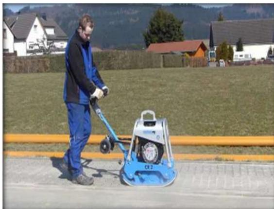
Ilustración 29 Vibrado de Adoquines. Fuente: <https://i.ytimg.com/vi/l3FGahMzxFk/maxresdefault.jpg>
