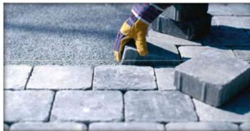
Ilustración 24 Colocación de Adoquines. Fuente: <https://www.breinco.com/breincosmartblog/wp-content/uploads/2018/04/como-colocar-un-pavimento-de-adoquines-breinco-opt-710x347.jpg>
