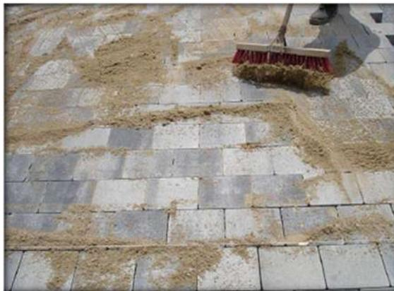
Ilustración 28 Rejuntado de Adoquines. Fuente: <https://www.breincosmartblog/wp-content/uploads/2018/03/relleno-de-juntas-con-arena-opt.jpg>
