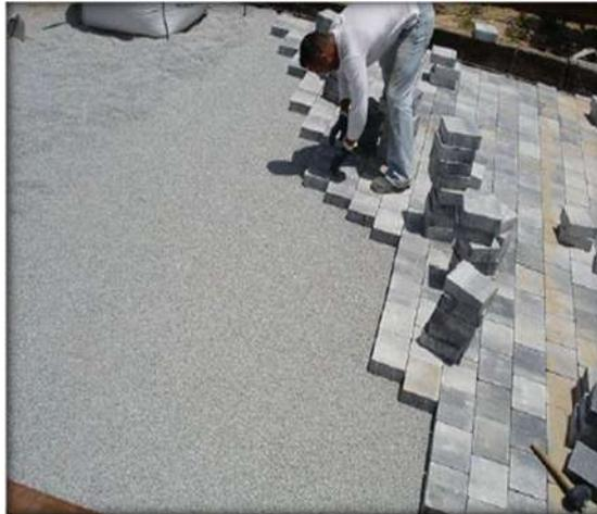
Ilustración 27 Colocación de Adoquines. Fuente: <https://www.breincosmartblog/wp-content/uploads/2018/03/colocacion-de-adoquines-opt.jpg>
