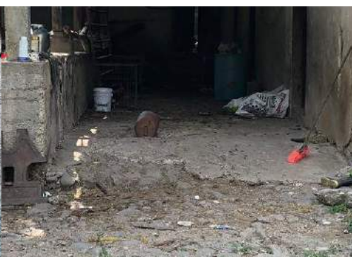
ILUSTRACIÓN 63:IMAGEN DE EMPEDRADO CON FIRME DE CONCRETO POR MRLL CASCO DE EX HACIENDA SANTA MARIA.
