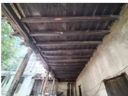
ILUSTRACIÓN 2. ENTREPISO VIGUERÍA POR MRILL & DCM
