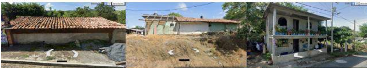
Casa de adobe con integración de materiales contemporáneos
