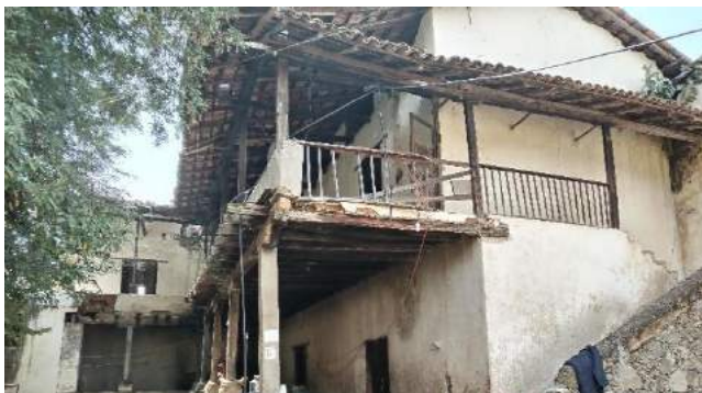
ILUSTRACIÓN 11:: FACHADA NORTE DEL CASCO DE HACIENDA SANTA MARÍA. FOTOGRAFÍA TOMADA POR MRLL&DCM
