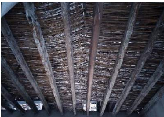
ILUSTRACIÓN 88: SISTEMA CONSTRUCTIVO CON CARRIZO, TÉCNICA MUY COMÚN PARA EVITAR LOS RAYOS SOLARES
