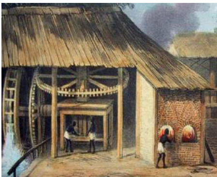
ILUSTRACIÓN 8:: ESQUEMA DEL TRAPICHE HIDRÁULICO, ESTRUCTURA DE LA NORIA QUE SOSTENÍA EL TRAPICHE EN LA EX HACIENDA DE SANTA MARÍA Y MAQUINARIA ORIGINAL TRAPICHE
