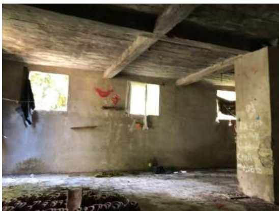
ILUSTRACIÓN 72:IMAGEN DE AMPLIACIÓN, SISTEMA CONSTRUCTIVO CONCRETO ARMADO IMAGEN INTERNA POR MRL CASCO DE EX HACIENDA SANTA MARIA.
