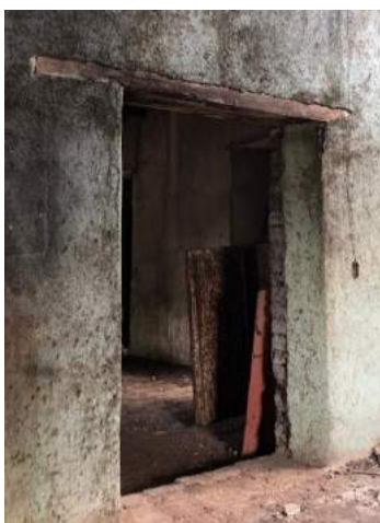
ILUSTRACIÓN 74:IMAGEN DE VANO CON DINTEL DE MADERA MRLL CASCO DE EX HACIENDA SANTA MARIA
