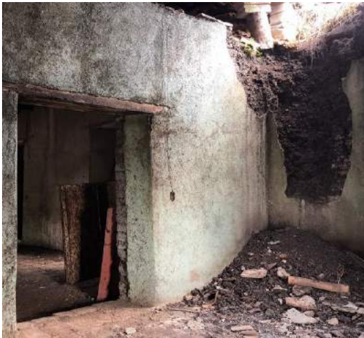
ILUSTRACIÓN 66:IMAGEN MURO DE ADOBE Y VANO CON DINTEL DE MADERA POR MRL CASCO DE EX HACIENDA SANTA MARIA.
