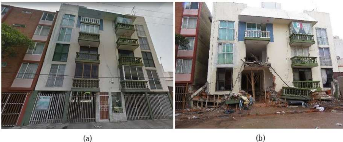
Figura II-21 Edificio residencial con primer piso débil ubicado en Balsas 18, Miravalle. (a) antes del 19 de septiembre de 2017; (b) después del 19 de septiembre de 2017. Obtenido de (Galvis, 2017)
