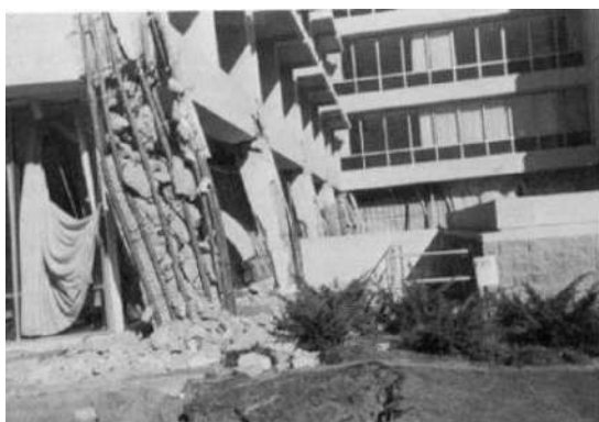
Figura III-2 Daños en hospital Olive View durante el sismo de San Fernando en 1971. Obtenido de (Jiménez, 2004)
