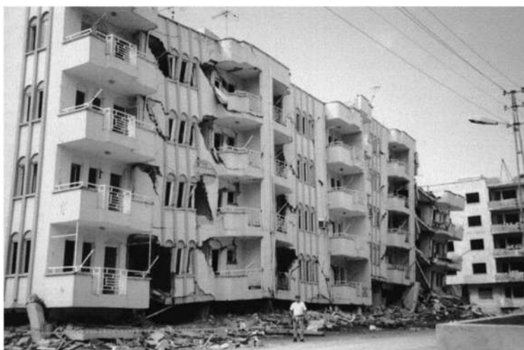
Figura II-16 Colapso de edificio de departamentos con planta baja débil en la ciudad de Ceyhan, Turquía por el sismo de 1998. Obtenido de (Adalier, 2001)
