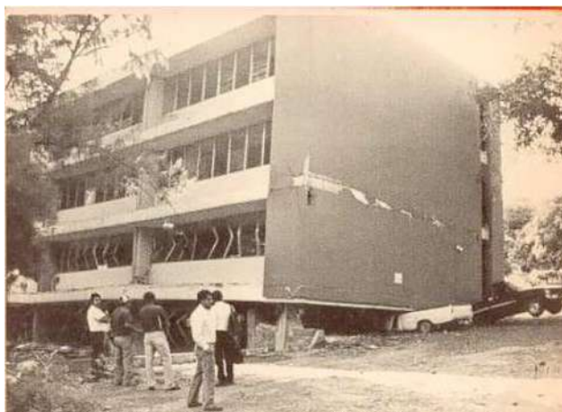
Figura III-1 Colapso de planta baja de edificio durante el sismo de El Salvador de 1986. Obtenido de (Jiménez, 2004)
