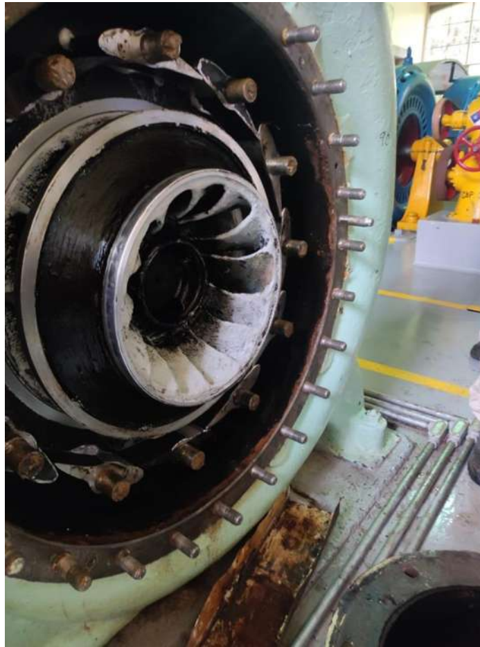
Figura. 3.5 Turbina hidráulica tipo Francis
