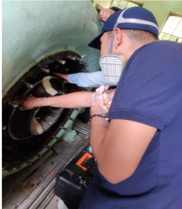
A) Colocación de la pasta en el álabe del rodete.
