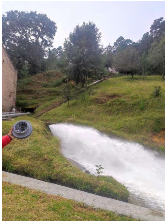
Figura. 3.4. Imagen que ilustra el momento en el que se está vaciando la tubería.
