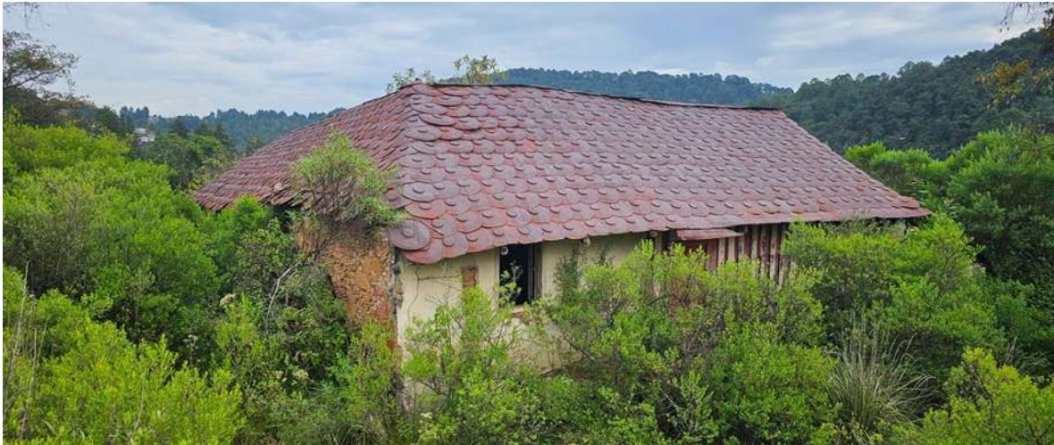
Fig. 65 Vivienda abandonada en territorios cercanos a la cabecera de Tlalpujahua. Toda su cubierta fue hecha con el reciclaje de los tapones de los tambos de cianuro usados en la industria minera. Fotografía: Adrián Solís. Diciembre 2023.
