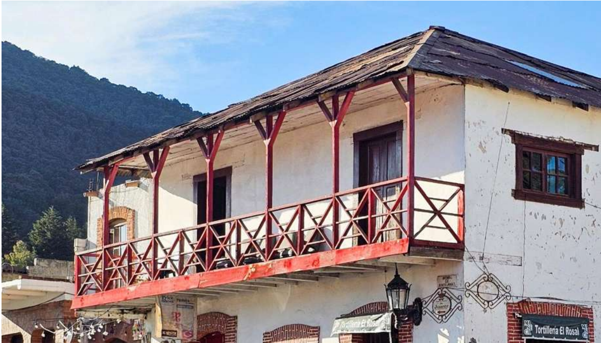
Fig. 98 Balcón corrido de madera en El Oro. Fotografía: Adrián Solís. Diciembre 2023.
