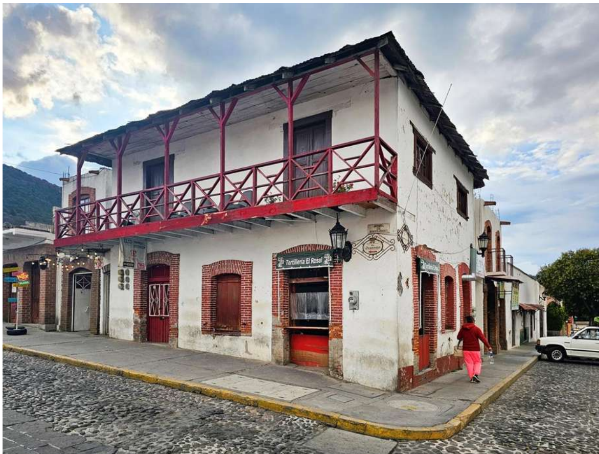
Fig. 117 Edificio dentro de la Zona de Monumentos Históricos, que se considera importante por valor formal, dentro del que están características de la arquitectura inglesa, y que no fue catalogado como Monumento. Fotografía: Adrián Solís. Marzo 2024.
