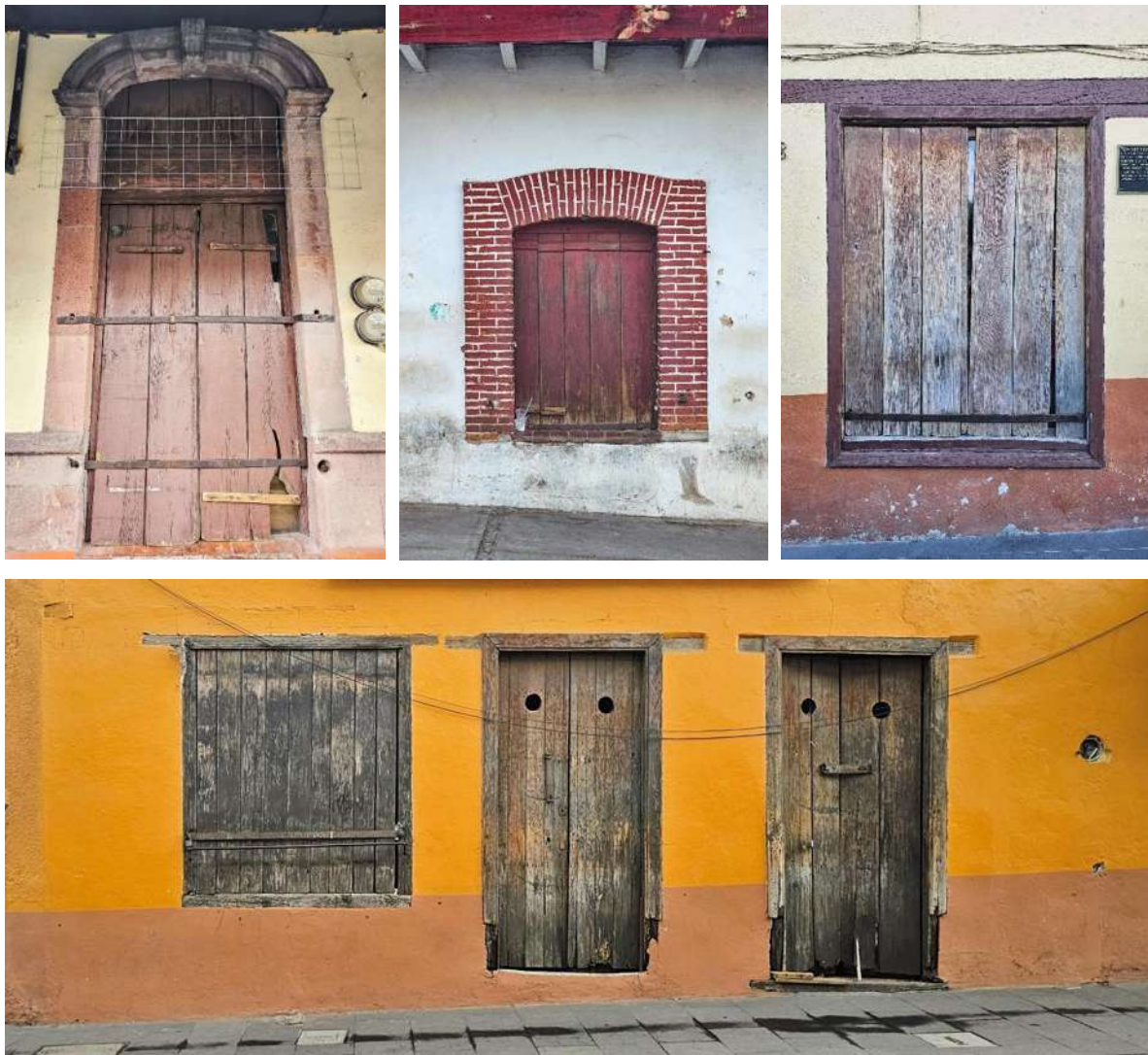
Fig. 89 Sistema de tabloncillos para cerrar y proteger las ventanas o vitrinas de los locales comerciales en las viviendas. Fotografías: Adrián Solís. Julio 2023 y marzo 2024.
