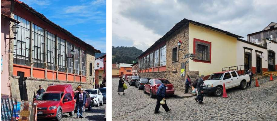
Fig. 67 Edificio en calle Rayón número 4, esquina con 5 de mayo. Fotografías: Adrián Solís. Diciembre 2023.
