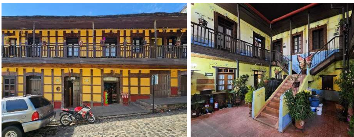
Fig. 66 Edificio en calle Ocampo números 9 y 11. Fotografía: Adrián Solís. Diciembre 2023.
