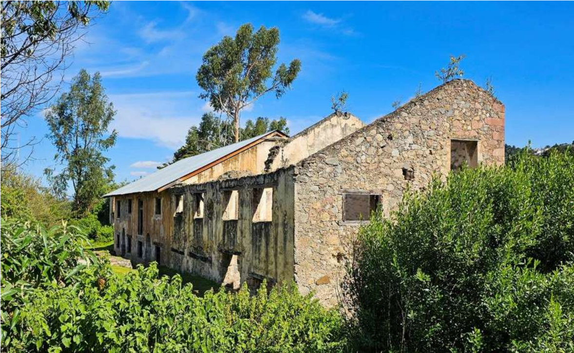
Fig. 86 Vista de la fachada que da al interior de la propiedad de la Hacienda Vieja. Fotografía: Adrián Solís. Diciembre 2023.
