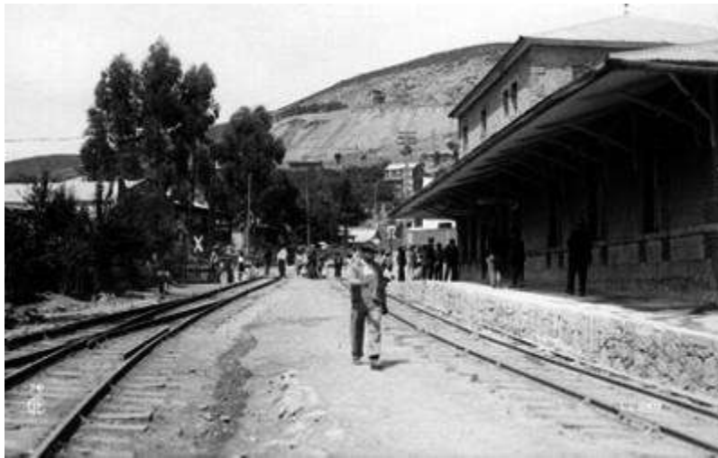
Fig. 14 Estación del tren en El Oro. Fuente: Mediateca INAH (fotografía de alrededor de 1907).
