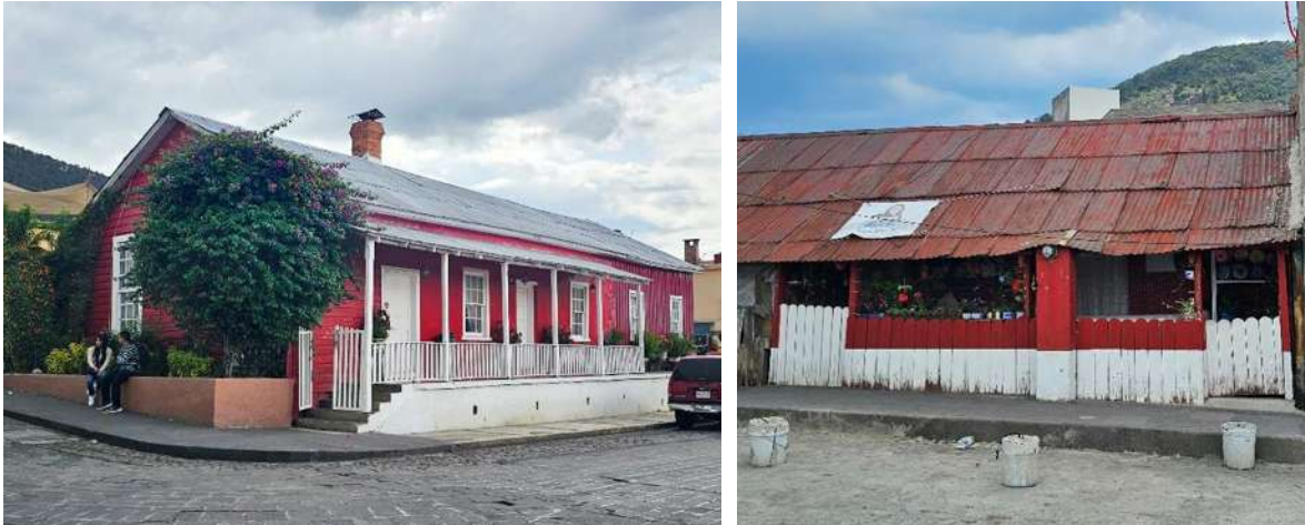
Fig. 93 Viviendas con predominio de uso de la madera. A la izquierda vivienda en cuadro principal con notable estilo inglés; a la derecha vivienda de los ferrocarrileros que se asentaron junto a las vías. Fotografías: Adrián Solís. Julio 2023.
