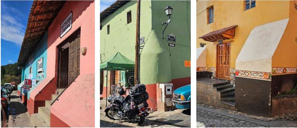
Fig. 61 Diferentes tipos de contrafuertes para contrarrestar los empujes por la pendiente del terreno. Fotografías: Adrián Solís. Diciembre 2023.
