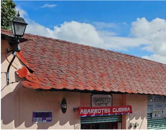
Fig. 63 Edificio con cubierta metálica producto del reciclaje de los tapones de los tambos de cianuro que se usaban en la industria minera. Fotografía: Adrián Solís. Diciembre 2023.
