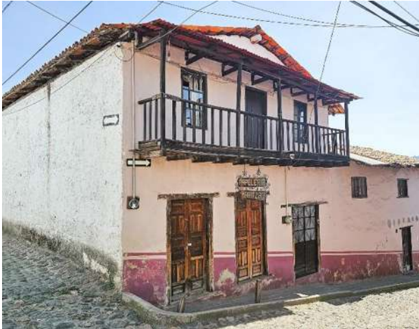
Fig. 57 Vivienda con vanos con dintel de madera y balcón corrido. Fotografía: Adrián Solís. Diciembre 2023.
