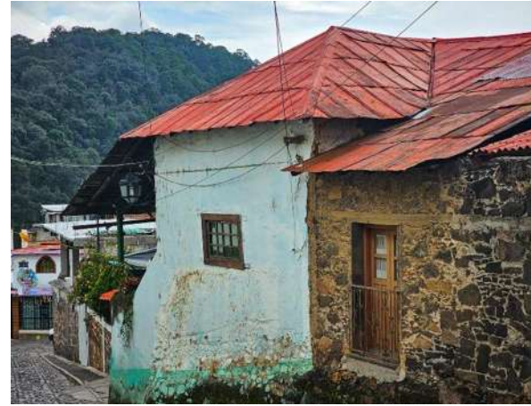
Fig. 64 Vivienda con cubierta de láminas metálicas. Fotografía: Adrián Solís. Diciembre 2023.
