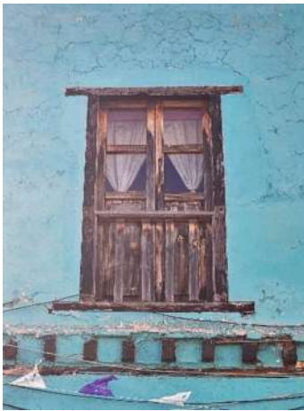
Fig. 51 Balcón de madera al mismo nivel del lecho exterior del muro. Fotografía: Adrián Solís. Marzo 2023.
