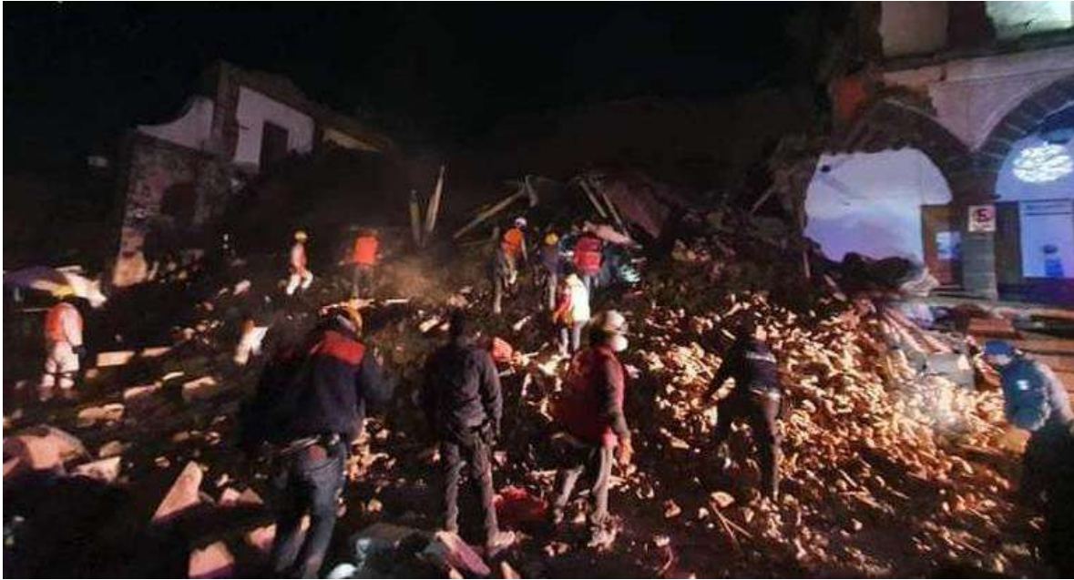
Fig. 163 Derrumbe, por causa de graves deterioros, de casa en el Portal Centenario, dejando dos muertos, en el 2021. Fotografía: Jorge Medina Montoya. Fuente: https://www.elsoldemorelia.com.mx/local/se-derrumba-casa-en-tlalpujahu-reportan-dos-fallecidos-7473098.html [16/02/2024]
