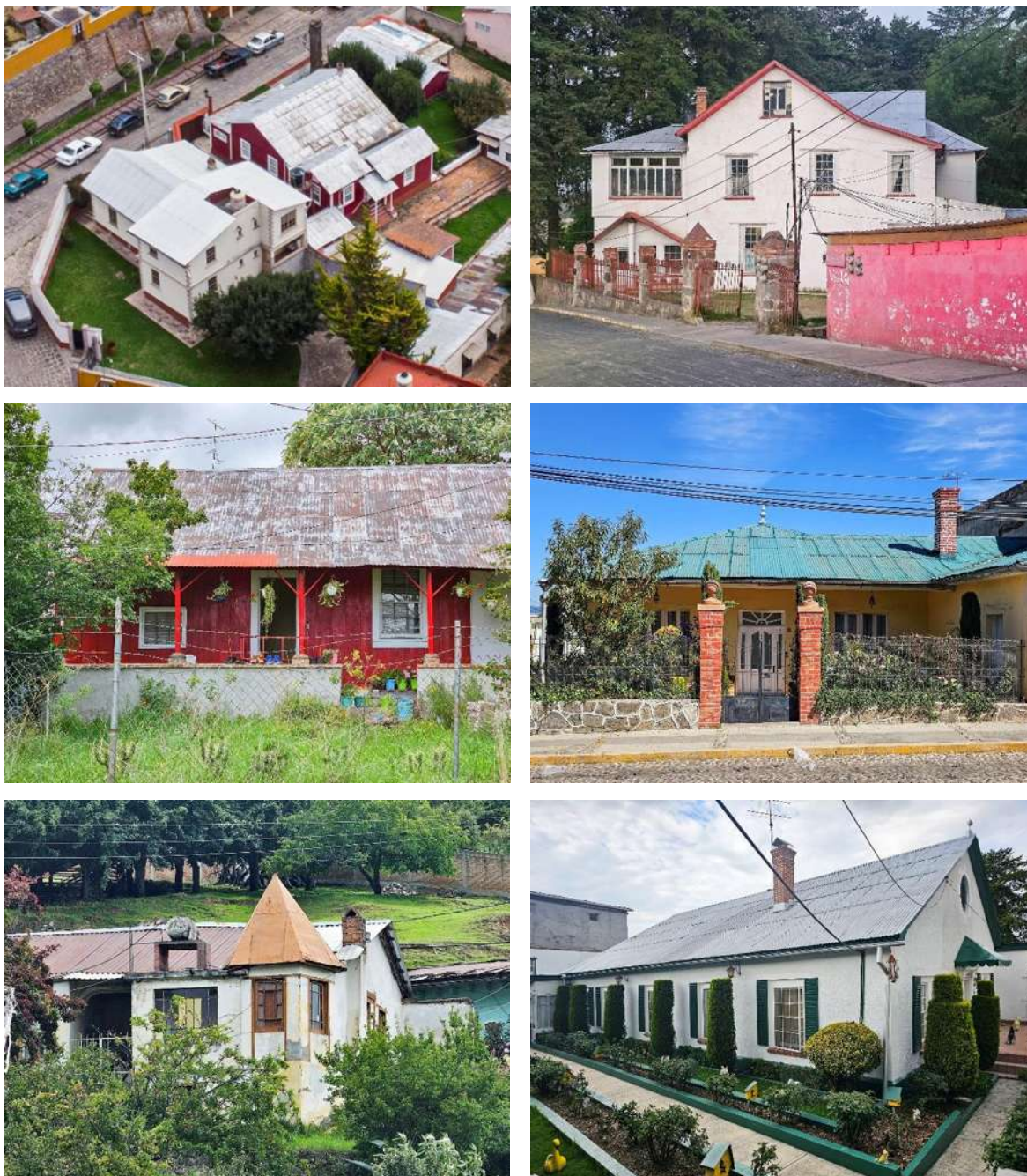
Fig. 100 Viviendas con estilo extranjero y características diversas entre ellas, a excepción de que en ninguna su fachada está sobre el paramento de la banqueta. Fotografía: Adrián Solís. Julio 2023.
