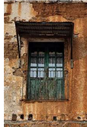
Fig. 56 Vano con alero de estructura de madera y cubierta metálica. Fotografía: Adrián Solís. Diciembre 2023.
