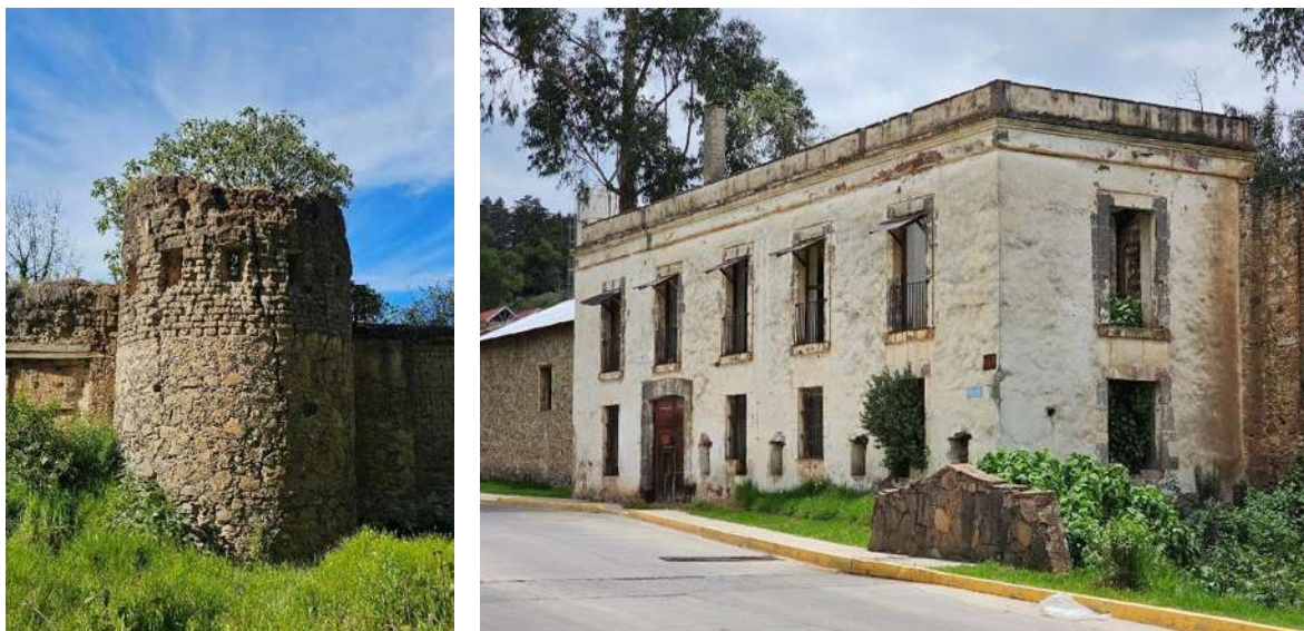
Fig. 87 Hacienda vieja. A la izquierda un torreón defensivo y a la derecha el volumen principal de la fachada. Fotografías: Adrián Solís. Diciembre 2023.
