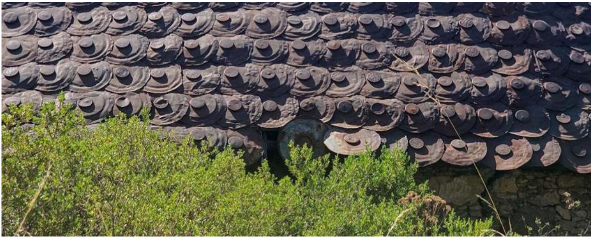
Fig. 171 Techo de vivienda en el municipio de Tlalpujahua, realizado con el reciclaje de los tapones de tanques de cianuro utilizados en el beneficio del metal. Fotografía: Adrián Solís. Marzo 2024.
