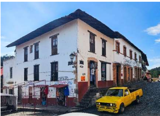
Fig. 49 Vivienda que muestra dos niveles en una fachada y tres en la otra. Fotografía: Adrián Solís. Diciembre 2023.
