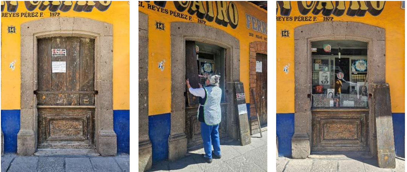
Fig. 48 Sistema tradicional a base de tabloncillos y piezas metálicas para proteger las ventanas de las vitrinas o aparadores de los locales comerciales. Fotografías: Adrián Solís. Marzo 2024.
