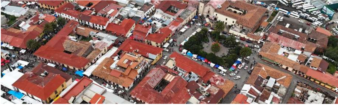
Fig. 62 Cubiertas de las edificaciones en Tlalpujahua, donde se puede apreciar el empleo en su mayoría de cubiertas metálicas pero también de teja de barro. Fotografía: Adrián Solís. Diciembre 2023.
