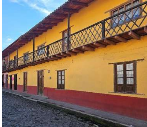
Fig. 55 Vivienda con balcón corrido a todo lo ancho de la propiedad, utilizando un diseño de entramado que forma rombos. Fotografía: Adrián Solís. Diciembre 2023.
