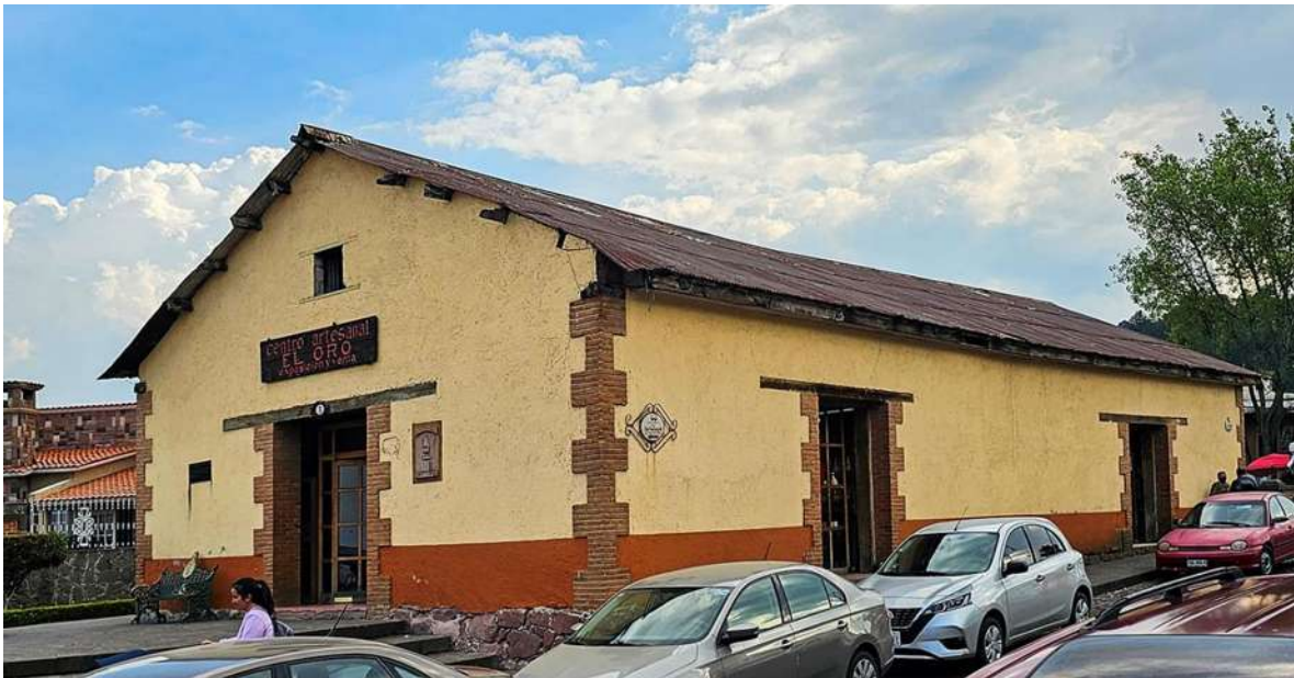
Fig. 80 Antigua bodega de la estación del tren. Ahora es el Centro Artesanal de El Oro. Fotografía: Adrián Solís. Octubre 2023.
