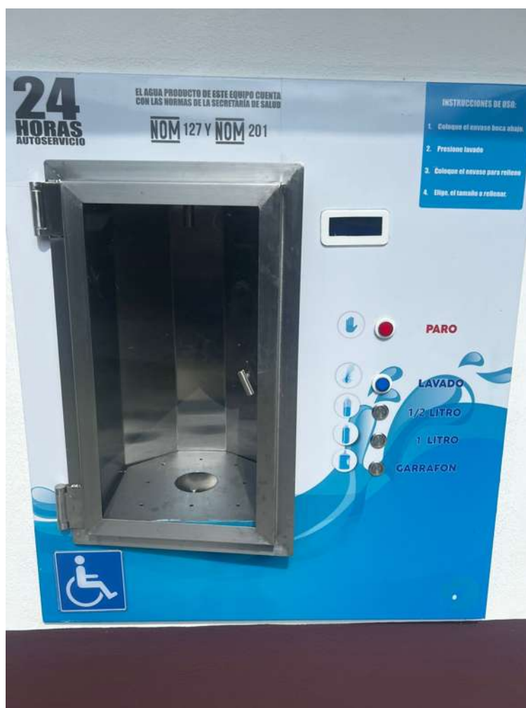
Figura 11. Compartimento despachador de agua en planta purificadora de agua instalada en el TecNM campus Morelia
