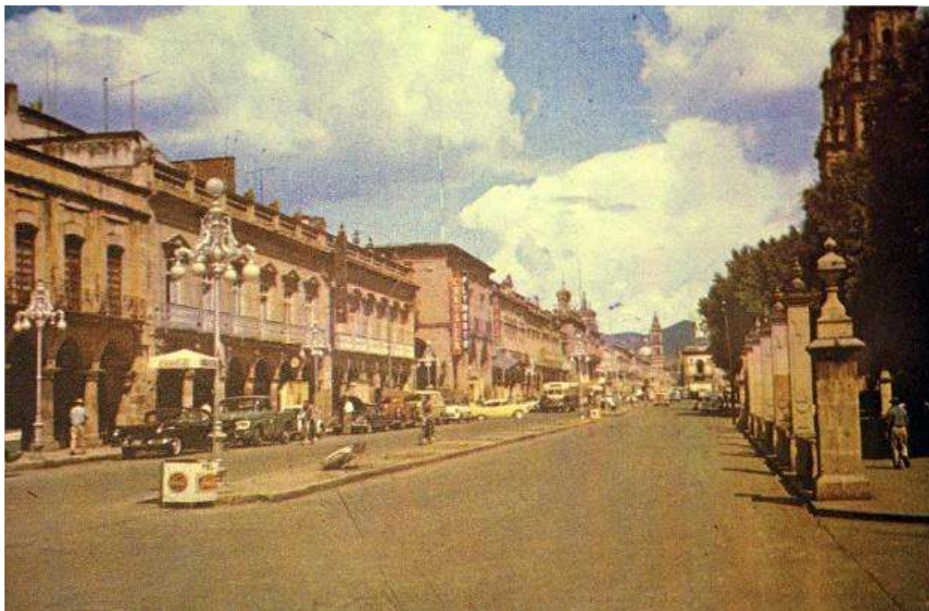
Fig. 76. Aspecto resultante del camellón, después del retiro de sus palmas. Fuente: Subido por Ricardo Espejel Cruz, “Otra vista de la Av. Madero Poniente, con camellones pero ya sin palmeras”, en Michoacán histórico [sitio web], s/f.
