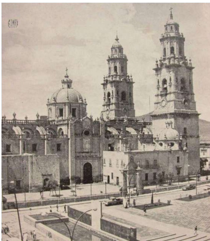
Fig. 79. Fotografía con vista hacia el lado sur de la explanada concretada. Fuente: Subido por Víctor Álvarez, “Plaza Ocampo 1970”, en Pinterest [sitio web], s/f.
