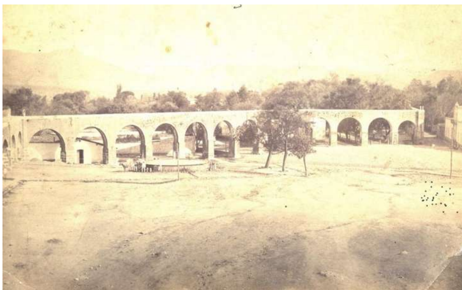
Figura 17. Fotografía de la plaza de Las Ánimas, que puede proporcionar una idea sobre cómo eran estas plazas virreinales antes de ser transformadas en espacios ajardinados. Fuente: Archivo Fotográfico del Instituto de Investigaciones Históricas de la UMSNH, Catálogo Jesús Tapia García, Fotos, núm. 83, s/f.
