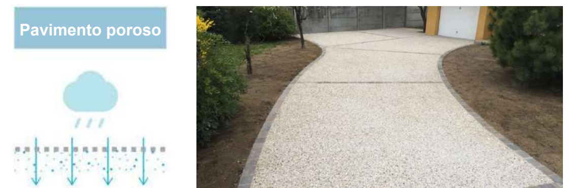
(Fig 4.75) .Pavimentos porosos . Fuente: Elaboración propia
