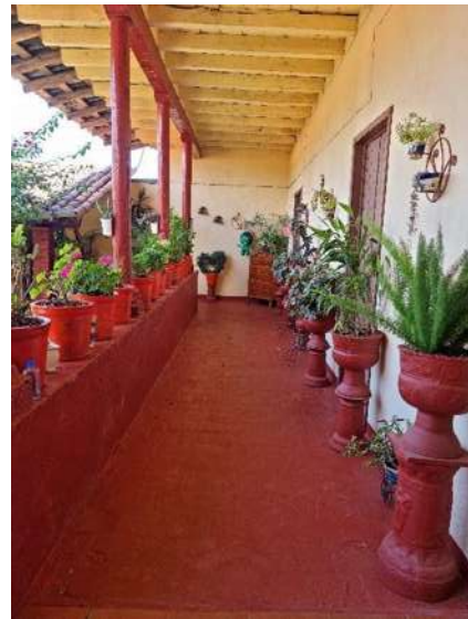
Ilustración 167 Apoyos verticales de madera en casa con características tradicionales Corredor Casa Trejo. RILM
