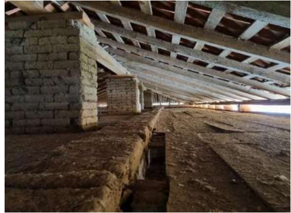
Ilustración 175 Cubierta a dos aguas interior. HMVG
