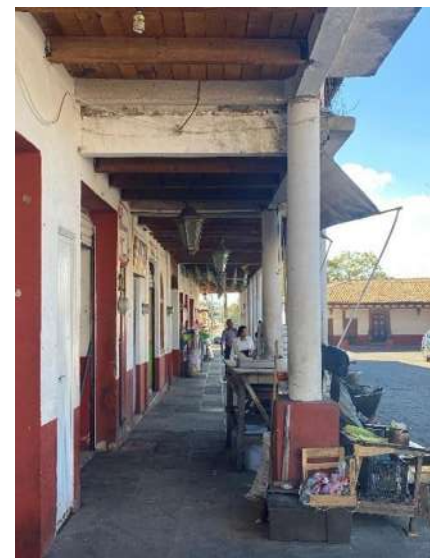
Ilustración 171 Apoyos verticales de concreto en Portal Guerrero. RILM
