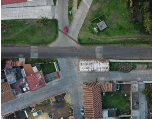
Ilustración 83 Intersección vial 2. HMVG
