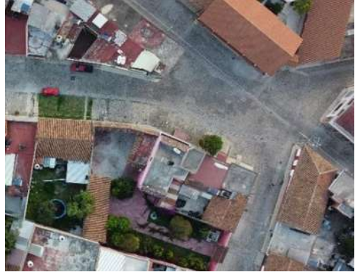
Ilustración 84 Intersección vial 1. HMVG.
