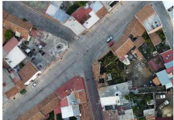
Ilustración 86 Intersección vial 4. HMVG
