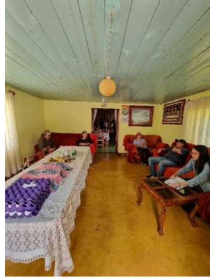
Ilustración 179 Cielo raso en sala. HMVG.
