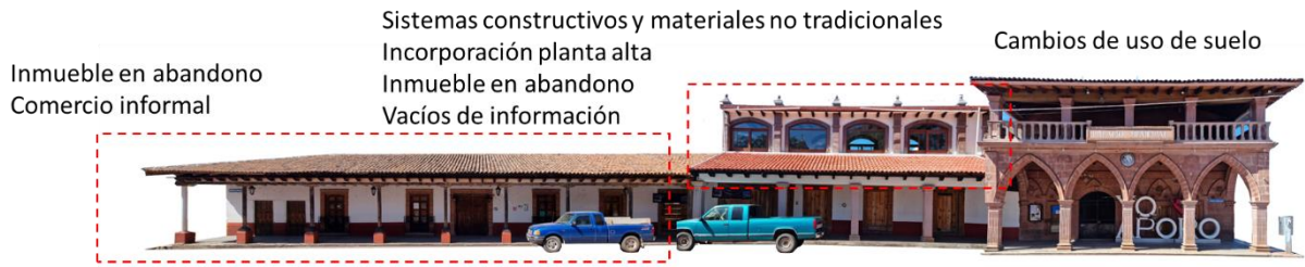
Ilustración 180 Alteraciones y deterioros Portal Hidalgo. RILM
