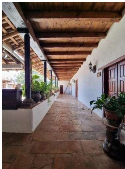
Ilustración 170 Apoyos verticales de madera en casa con características tradicionales Corredor Casa Rayita. RILM
