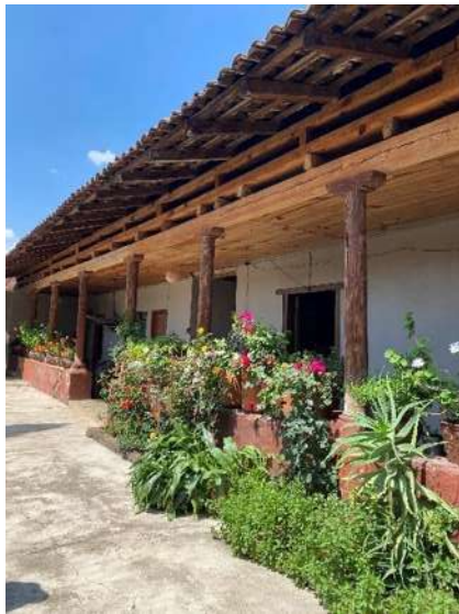
Ilustración 166 Apoyos verticales de madera en casa con características tradicionales corredor Casa Mendiola. RILM
