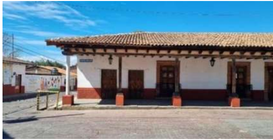
Ilustración 24 Portal Hidalgo Inmueble 1 2023. RILM.
