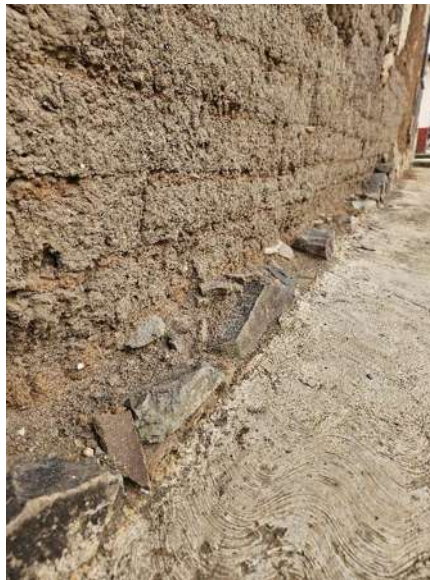
Ilustración 165 Cimentación inmueble ubicado en Áporo. RILM.
