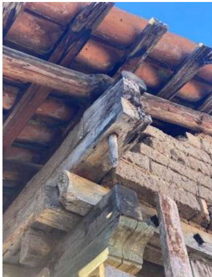
Ilustración 176 Unión gualdra y viga de arrastre con clavija. RILM.
