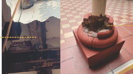
Liberación de tramo oxidado en columna metálica con integración de pieza nueva
