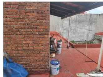
Ladrillo de 6x9x20cm colocado a soga y columnas metálicas con zócalo de ladrillo y concreto
