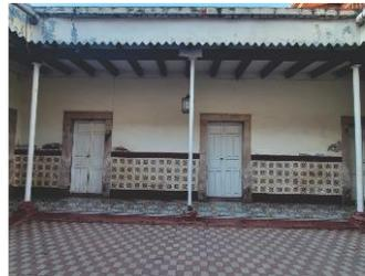
Columnas metálicas con zócalo de ladrillo y concreto.
