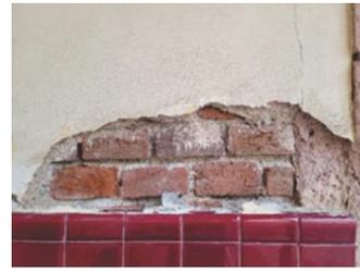
Ladrillo de 7x14x28cm colocado a tizón en muro de carga.
