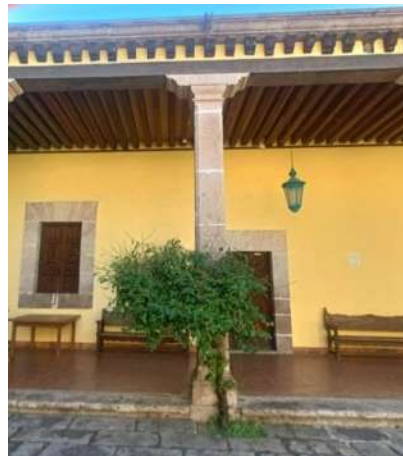
Ilustración 148 Cubiertas del inmueble. fotografía propia.
