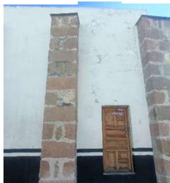
Ilustración 176 carpintería, fotografía propia.
