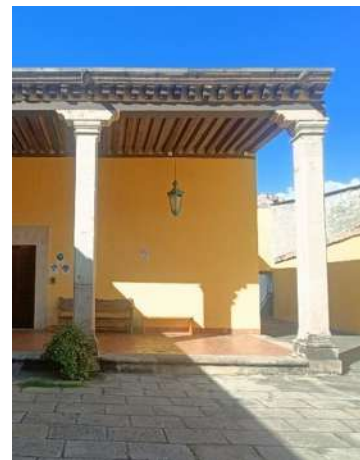
Ilustración 153 Apoyos corridos y aislados. fotografía propia.
