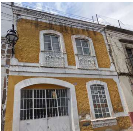
Ilustración 110 Sistema constructivo, arcos rebajados, URL: https://www.google.com/maps/@19.7048063,-101.1950232 .
