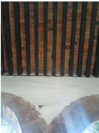
Ilustración 147 Cubiertas del inmueble. fotografía propia.
