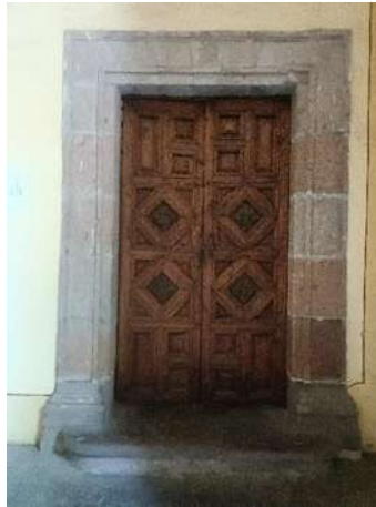
Ilustración 180 carpintería, fotografía propia.
