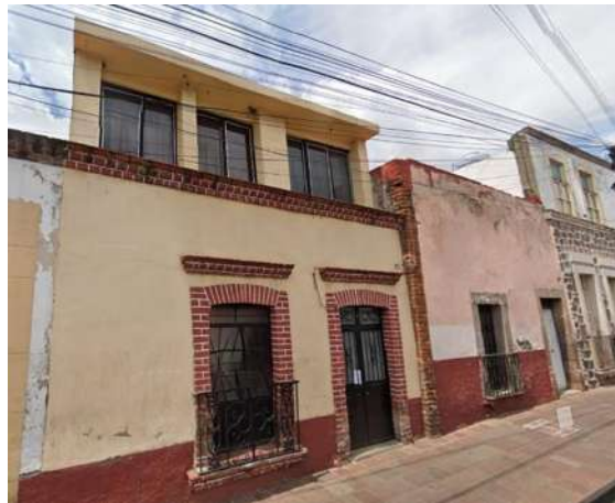
Ilustración 109 Sistema constructivo, arcos rebajados, URL: https://www.google.com/maps/@19.7048063,-101.1950232
