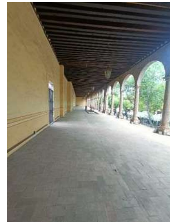
Ilustración 149 Cubiertas y entrepisos del inmueble. fotografía propia.
