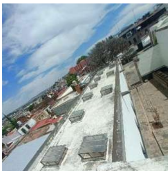
Ilustración 151 Cubiertas del inmueble. fotografía propia.
