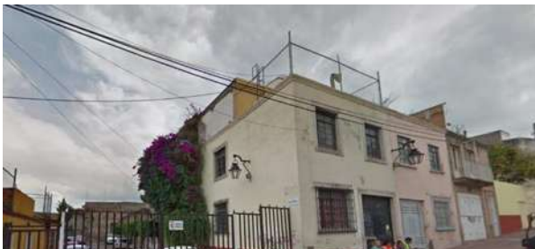
Ilustración 105 Tipología arquitectónica al poniente del inmueble, calle cerrada privada, sobre calle Miguel Bernal Jiménez. URL: https://www.google.com/maps/@19.7048063,-101.1950232 .
