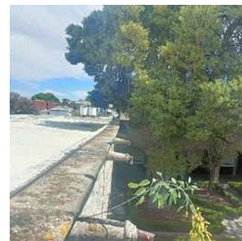
Ilustración 152 Cubiertas del inmueble. fotografía propia
