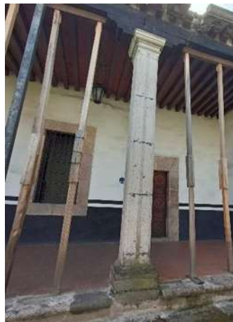
Ilustración 155 Apoyos corridos y aislados. fotografía propia.
