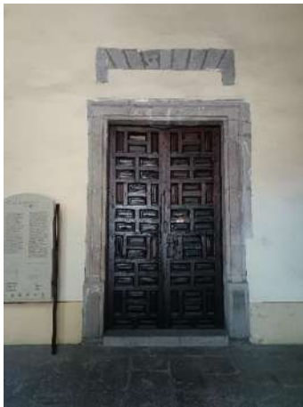
Ilustración 178 carpintería, fotografía propia.
