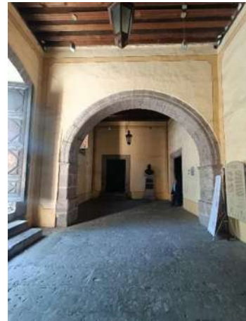
Ilustración 157 Cerramientos. fotografía propia.
