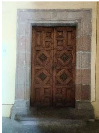
Ilustración 156 Cerramientos. fotografía propia.
