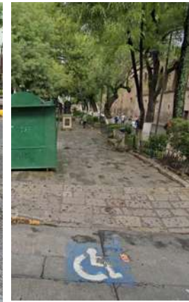
Ilustración 99 Única rampa en el jardín de las Rosas. fotografía propia
