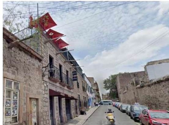
Ilustración 108 Tipología arquitectónica al oriente del inmueble, sobre calle Eduardo Ruiz, URL: https://www.google.com/maps/@19.7048063,-101.1950232 .
