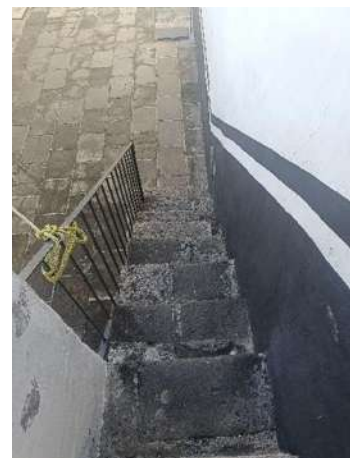
Ilustración 186 Herrería, fotografía propia.
