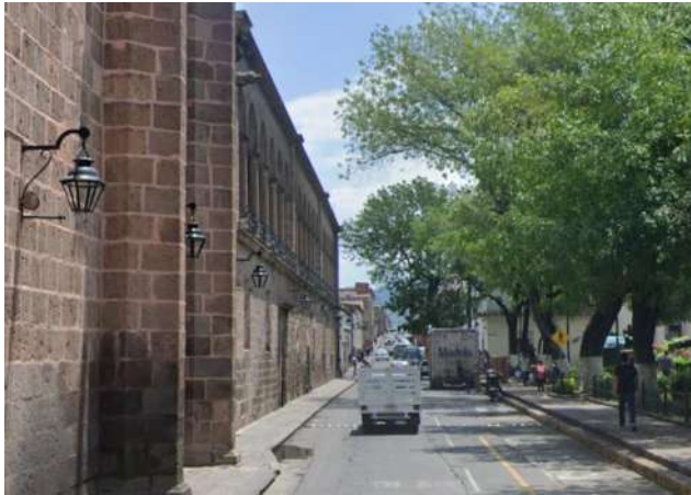
Ilustración 102 Luminarias empotradas en muros, alumbrado público, URL: https://www.google.com/maps/@19.7048063,-101.1950232 .
