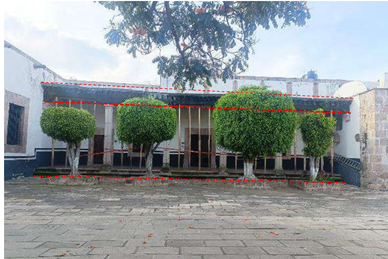
Ilustración 54 fotografía propia vista general del espacio deteriorado.
