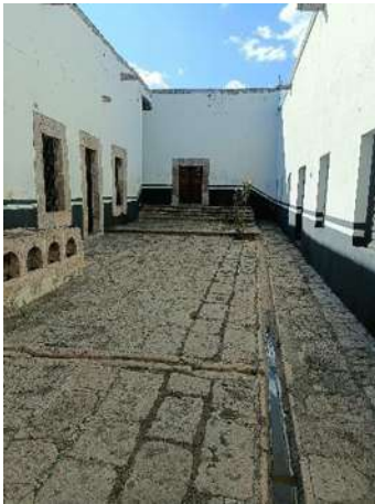
Ilustración 158 Cerramientos. fotografía propia.
