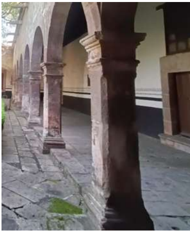
Ilustración 154 Apoyos corridos y aislados. fotografía propia.
