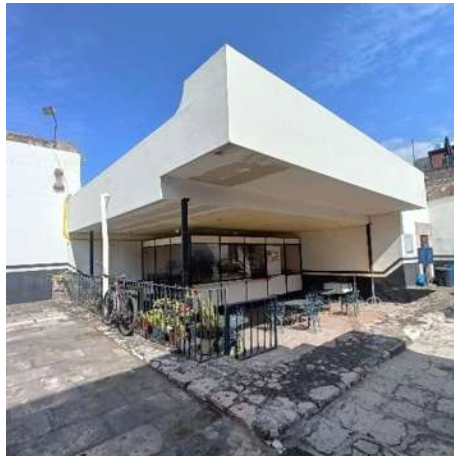
Ilustración 168 Instalaciones, fotografía propia.
