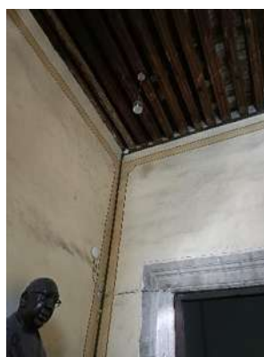
Ilustración 175 Cables visibles, fotografía propia.
