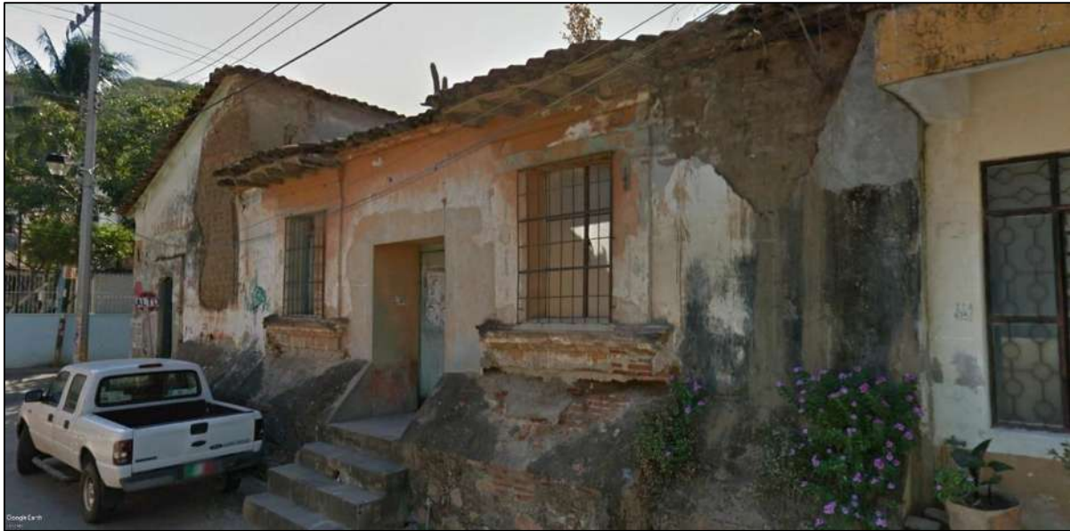
Figura 2-13. Vivienda de adobe tipo casona, con planta en «L». Fuente: Google Earth, 2022.
