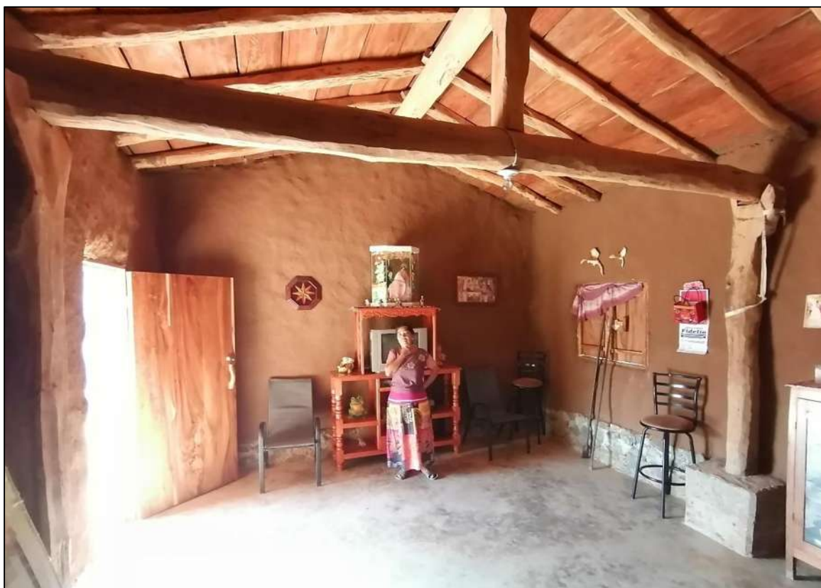
Figura 4-6. Interior de vivienda de bajareque reforzado por ONG Cooperación Comunitaria en la localidad de la Blanca. Fuente: fotografía del autor, 2022.
