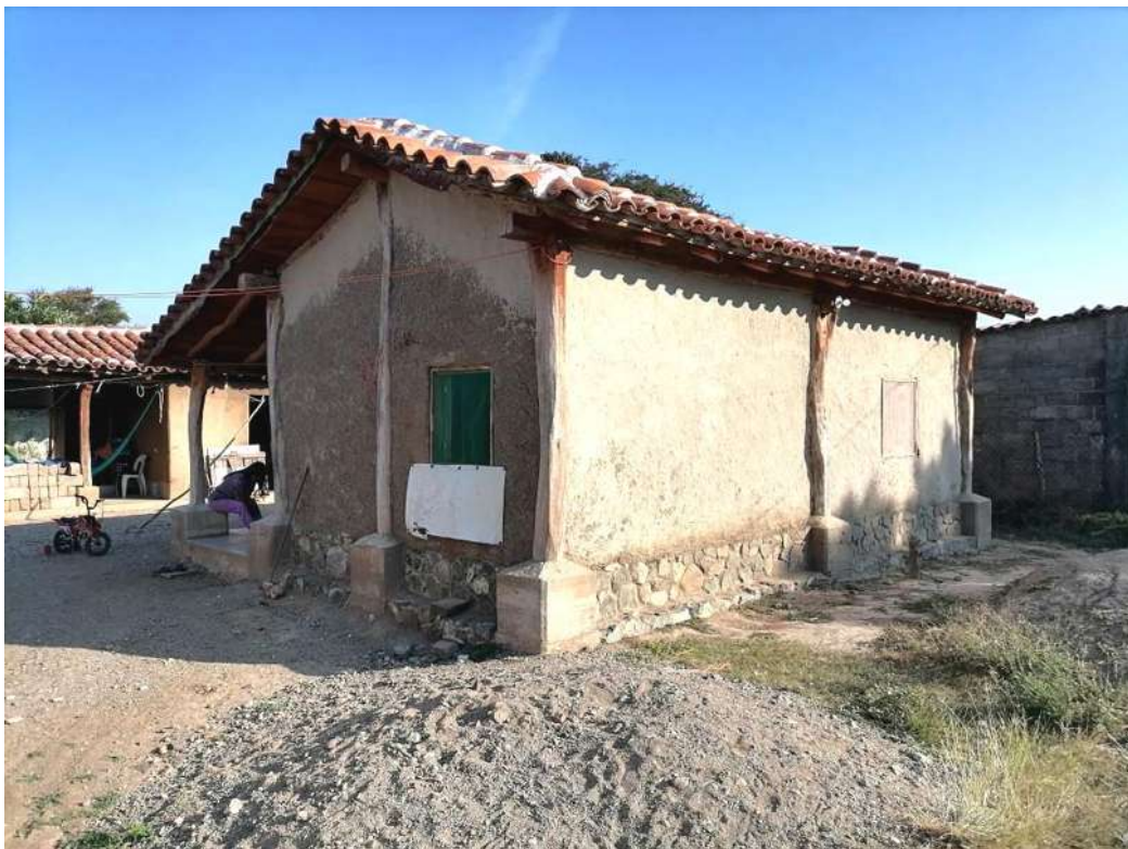
Figura 5-34. Vivienda reconstruida y reforzada de bajareque. Etapa 5, 01LAB-V09. Fuente: fotografía del autor, 2022.
