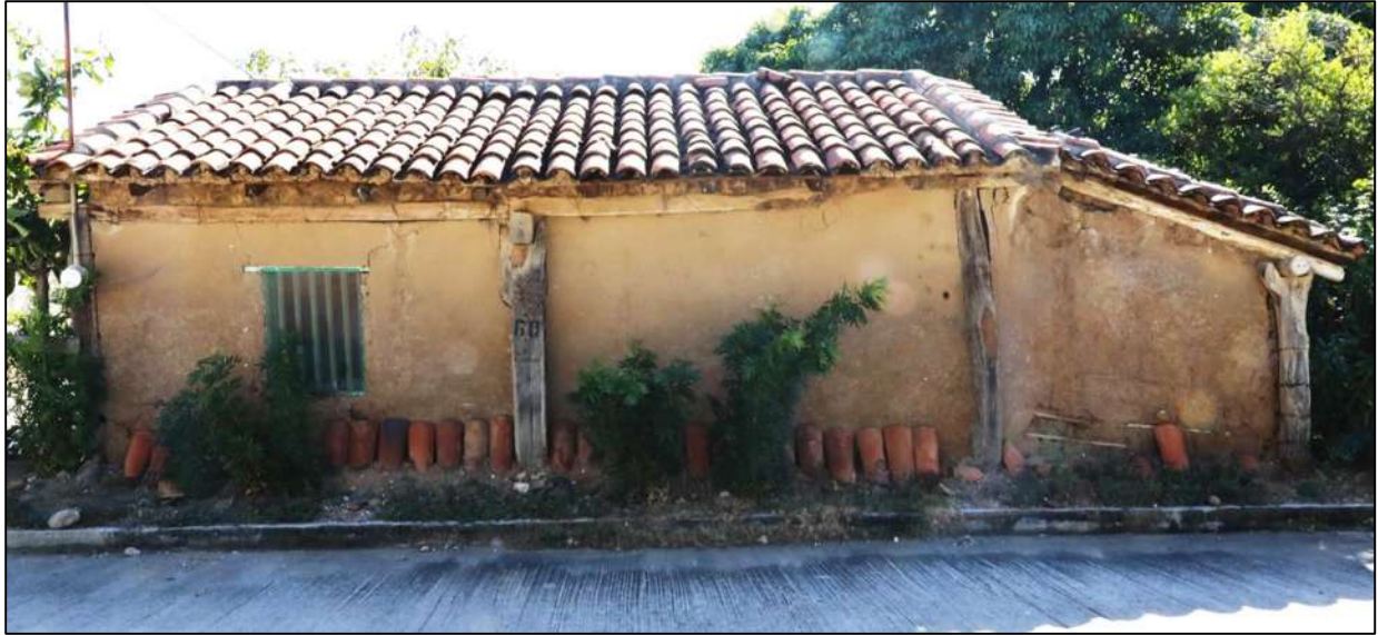
Figura 5-22. Vivienda de bajareque con teja como zócalo (sobre-cimiento). Fuente: fotografía del autor, 2022.
