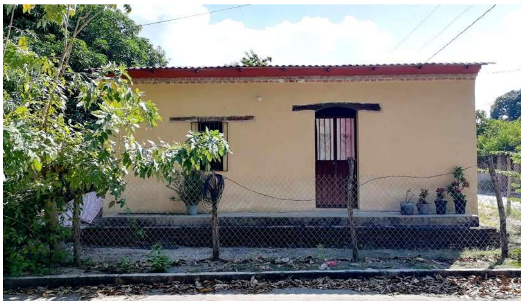
Figura 5-15. Vista poniente, desde la calle. Vivienda 02LAO-V04. Fuente: fotografía del autor, 2022.
