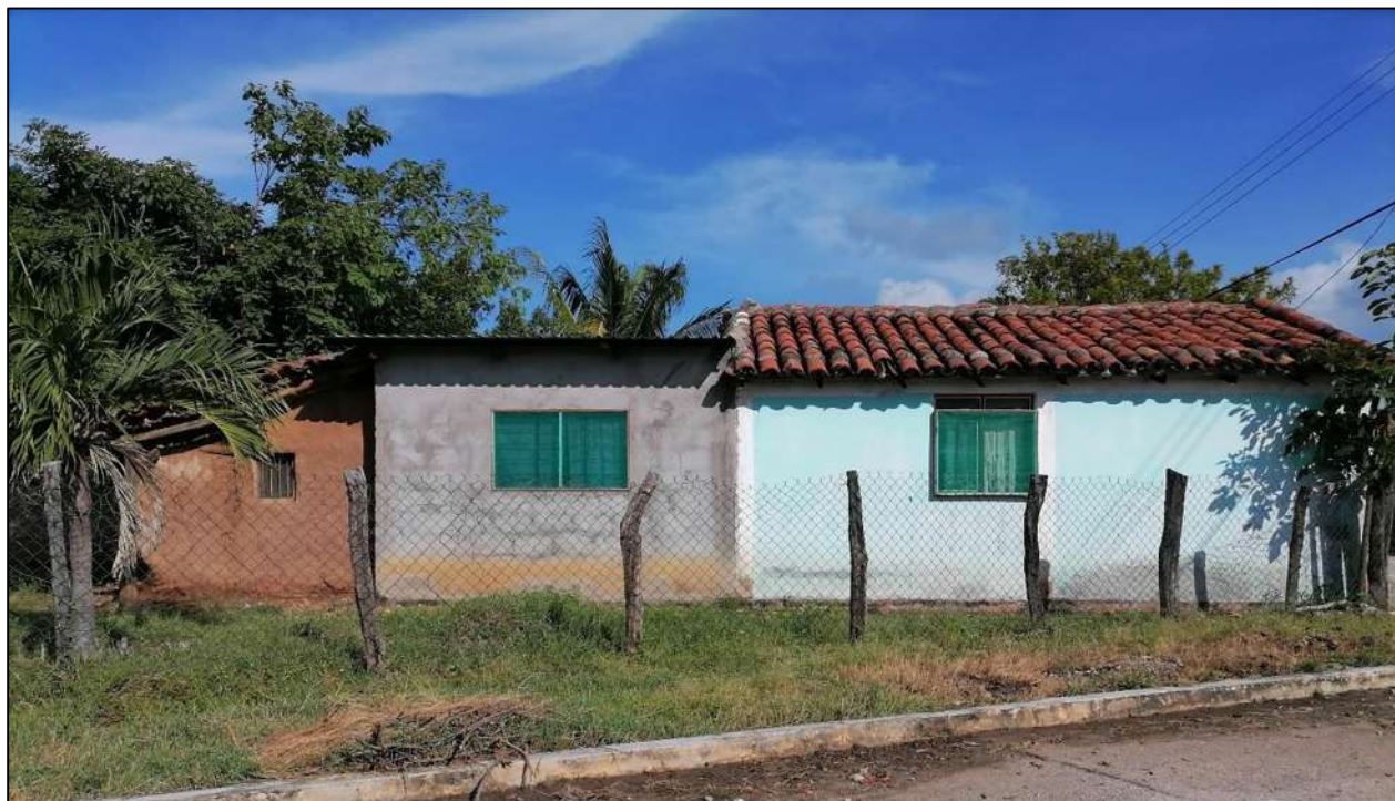
Figura 5-1. Vivienda con tres etapas constructivas de distintos sistemas constructivos en la localidad de La Blanca. Fuente: fotografía del autor, 2022.
