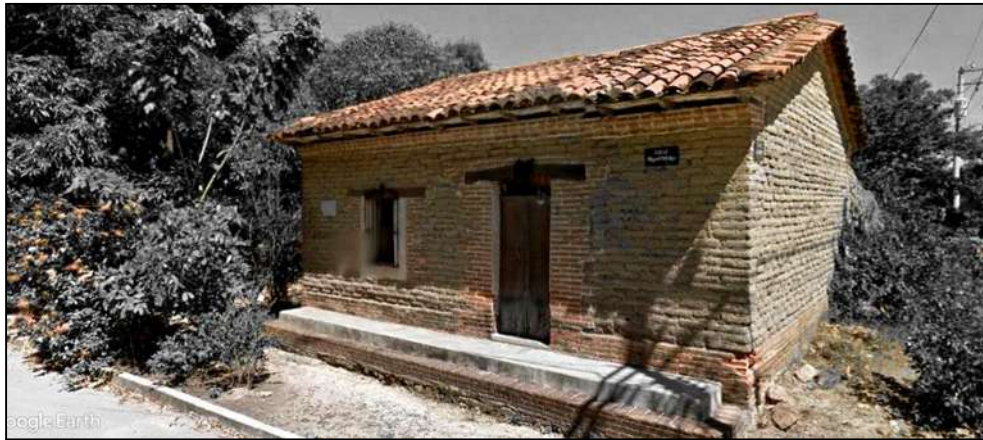
Figura 3-17. Ejemplo de la utilización de ladrillo, como elemento de coronación. Fuente: Google Earth, 2012, edición propia.
