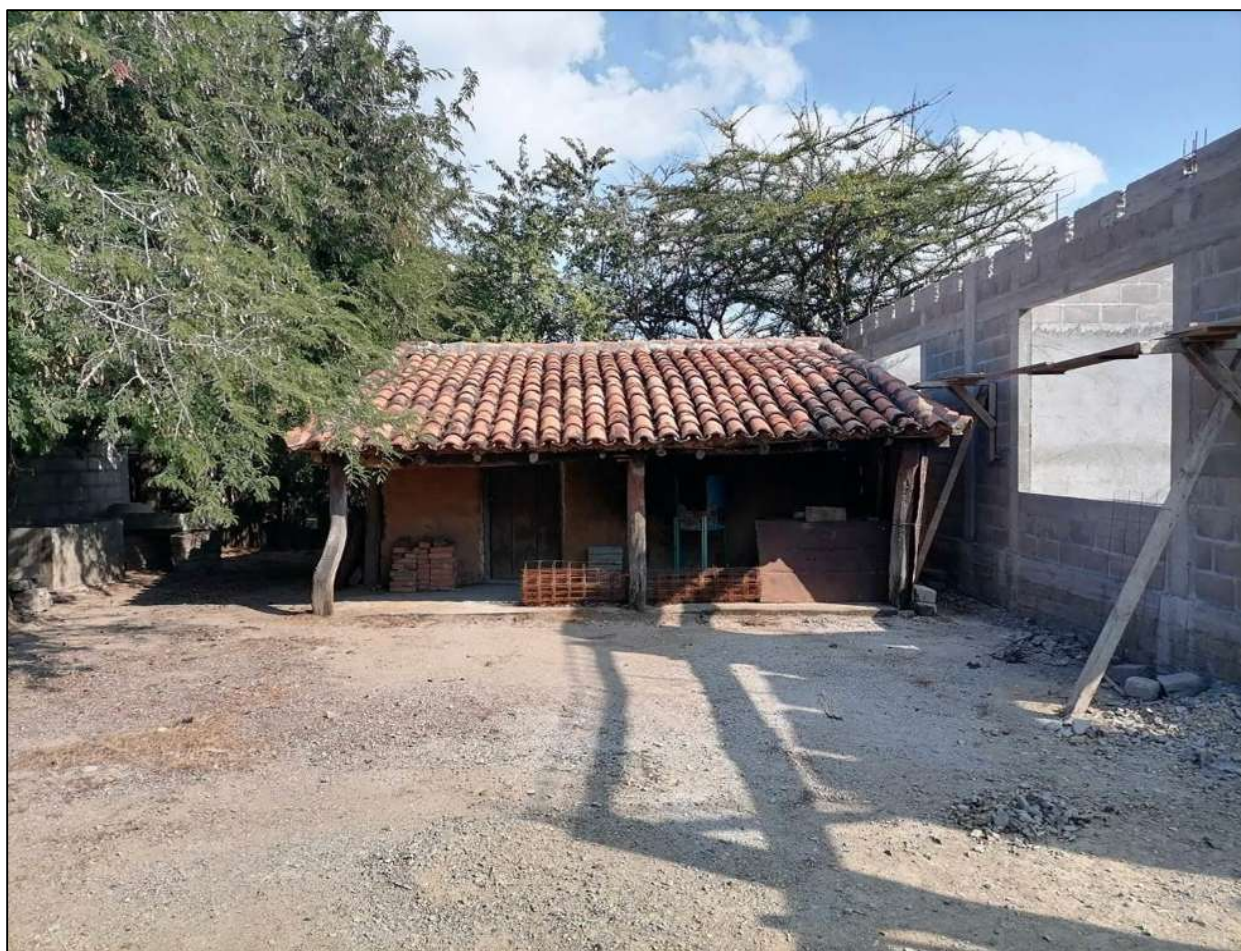
Figura 5-31. Etapa 2, vivienda 01LAB-V08. Fuente: fotografía del autor, 2022.
