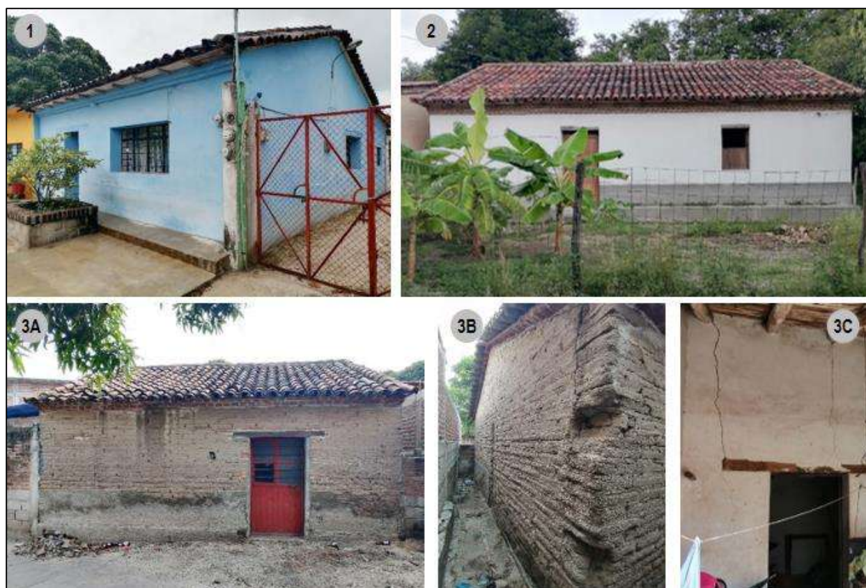
Figura 5-2. Escenarios de transformación de la vivienda de adobe. Fuente: fotografías del autor, 2022.
