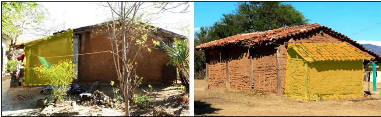
Figura 3-14. Ampliaciones en la vivienda de bajareque que contribuyen a mantener el centro de gravedad al inferior del edificio (en amarillo). Fuente: elaboración propia. Fotografías del autor, 2022.
