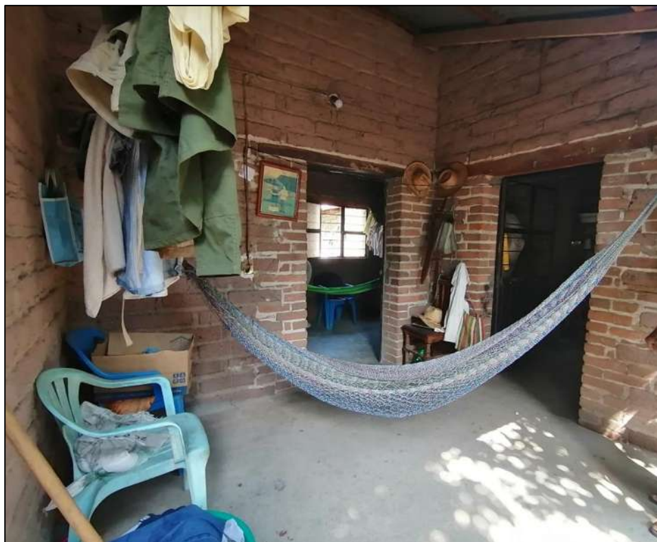
Figura 3-21. Refuerzo de ladrillo, en puertas de vivienda de adobe de Santiago Laollaga. Fuente: fotografía del autor, 2022.
