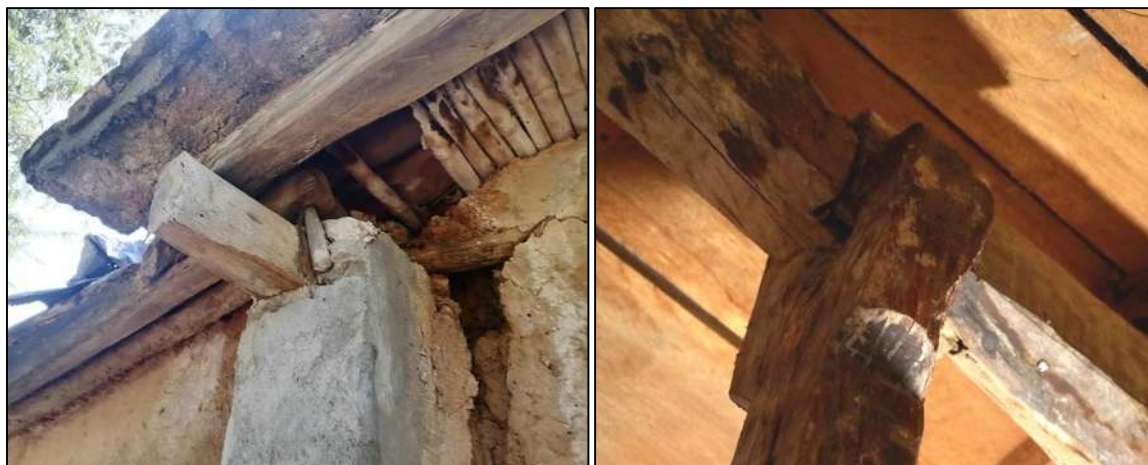
Figura 3-19. Uniones de elementos estructurales. Izquierda: clavija insertada en morillo, a modo de tope. Derecha: unión entre soleras de la cumbrera, descansando sobre el puntal o caballito. Fuente: fotografías de Irving Sánchez, 2023.
