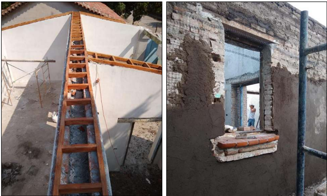
Figura 4-5. Izquierda: escalerilla de madera sobre muro de adobe. Derecha: malla plástica con recubrimiento de cal sobre. Fuente: fotografías del asistente técnico a cargo de la Obra, 2020.
