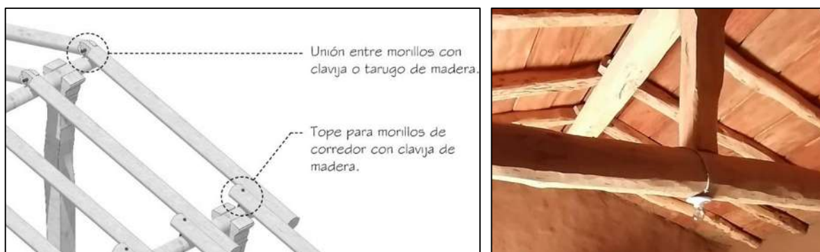
Figura 3-18. Uniones entre morillos. Fuente: elaboración propia. Fotografía del autor, 2022.
