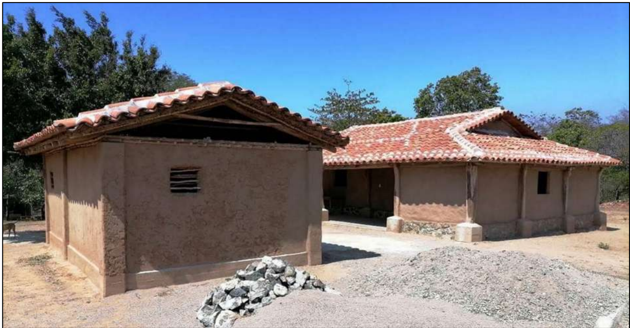
Figura 4-4. Vivienda reconstruida por la ONG Cooperación Comunitaria en la localidad La Blanca. Fuente: fotografía del autor, 2022.
