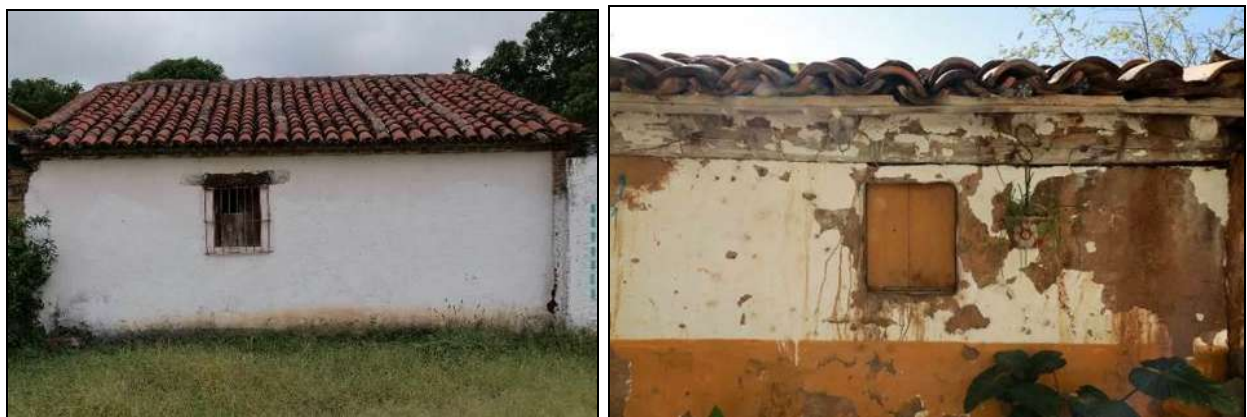
Figura 3-12. Ejemplo de ventanas reducidas. Izquierda: vivienda de adobe. Derecha: vivienda de bajareque. Fuente: fotografías del autor, 2022.
