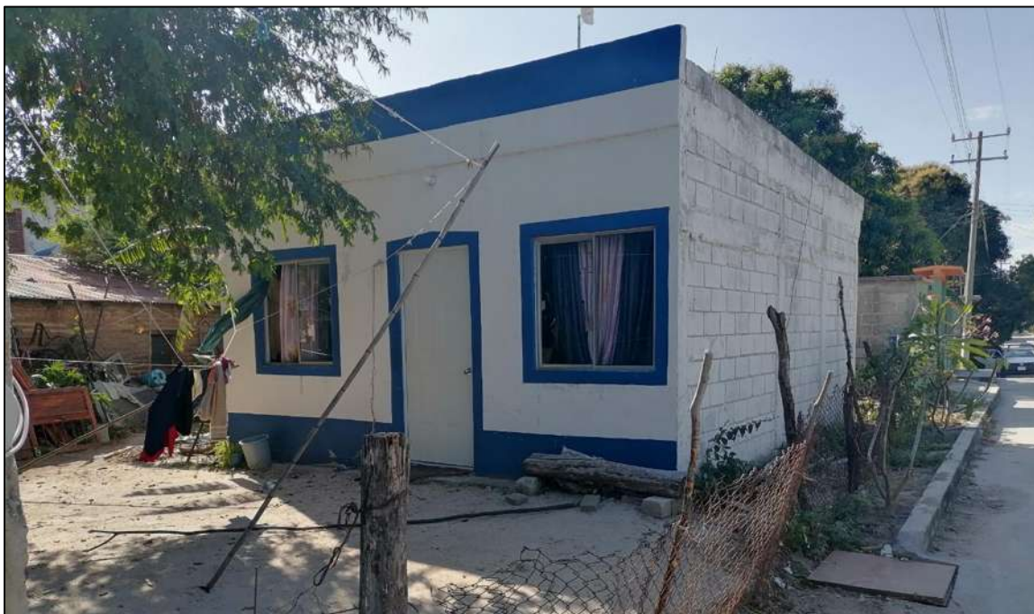
Figura 4-2. Vivienda realizada por una grande constructora en Santiago Laollaga. Fuente: fotografía del autor, 2023.
