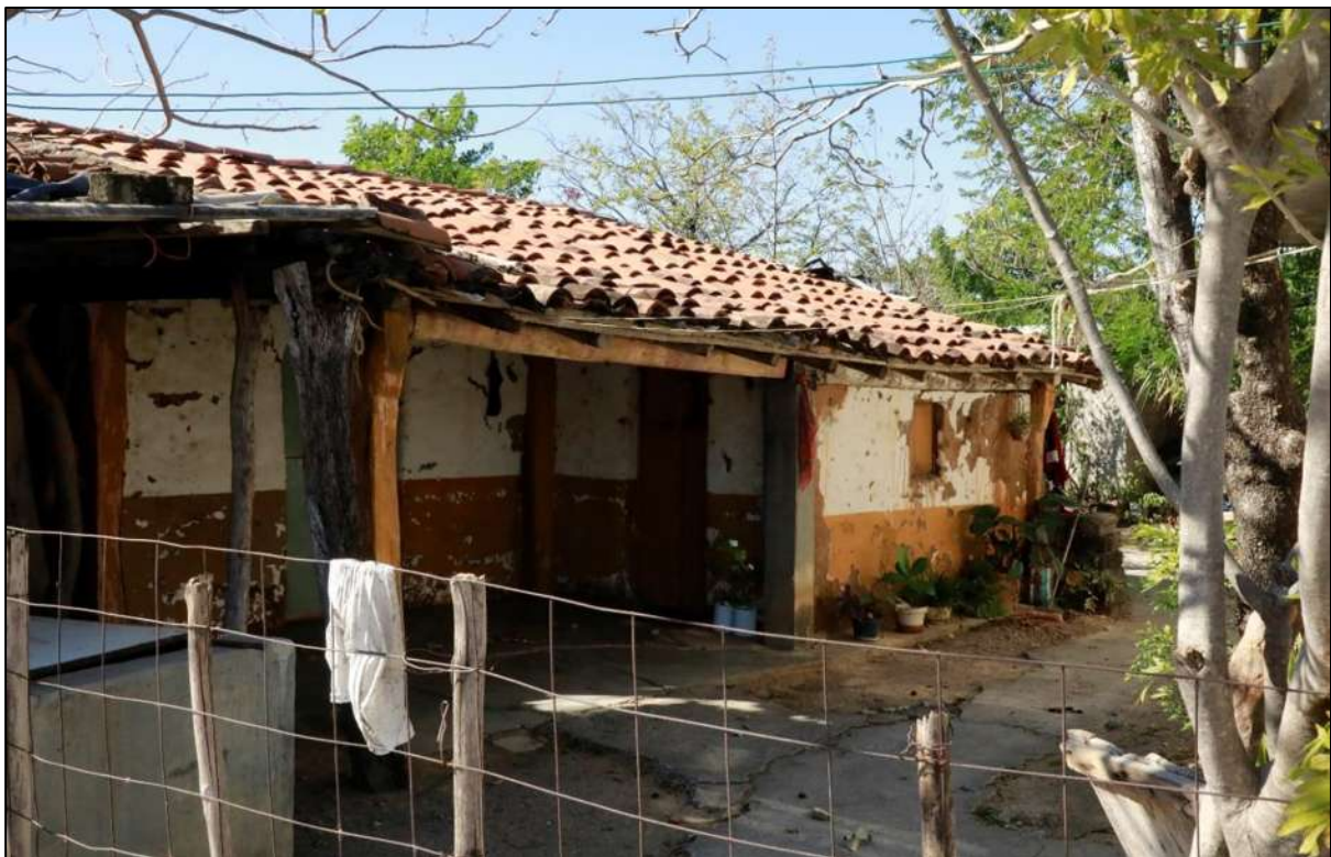
Figura 5-24. Vivienda de bajareque (etapa 1. 01LAB-V06) vista desde la calle. Fuente: fotografía del autor, 2022.
