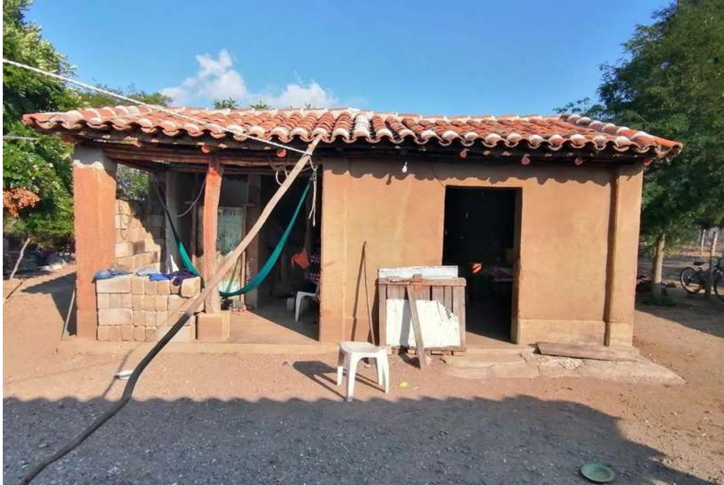
Figura 5-33. Cocina de bajareque cerén. Etapa 4, vivienda 01LAB-V09. Fuente: fotografía del autor, 2022.
