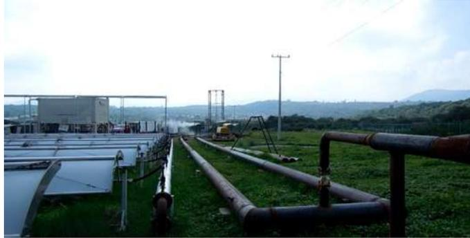
**Figura 2.4:** Tubería de reinyección de agua en el pozo Z-3, y al fondo el sistema de bombeo *airlift* funcionando.
