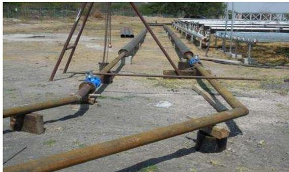
**Figura 2.6:** Tubería de extracción de salmuera geotérmica en el pozo Z-3
