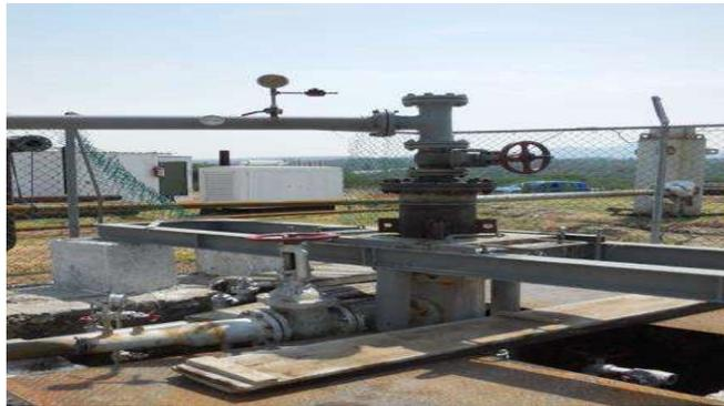
**Figura 2.5:** Tubería de elevación del sistema de bombeo *airlift* y el sistema de sujeción en la parte superior del pozo Z-3
