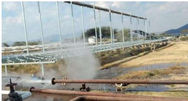
**Figura 2.11: Limpieza y Purga del sistema de extracción de la salmuera.**
