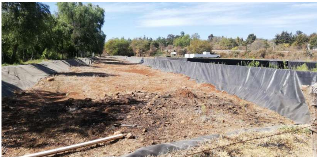
Figura 2.12.- Planta tratadora de aguas residuales en Santiago Undameo. Fuente: Elaboración propia.
