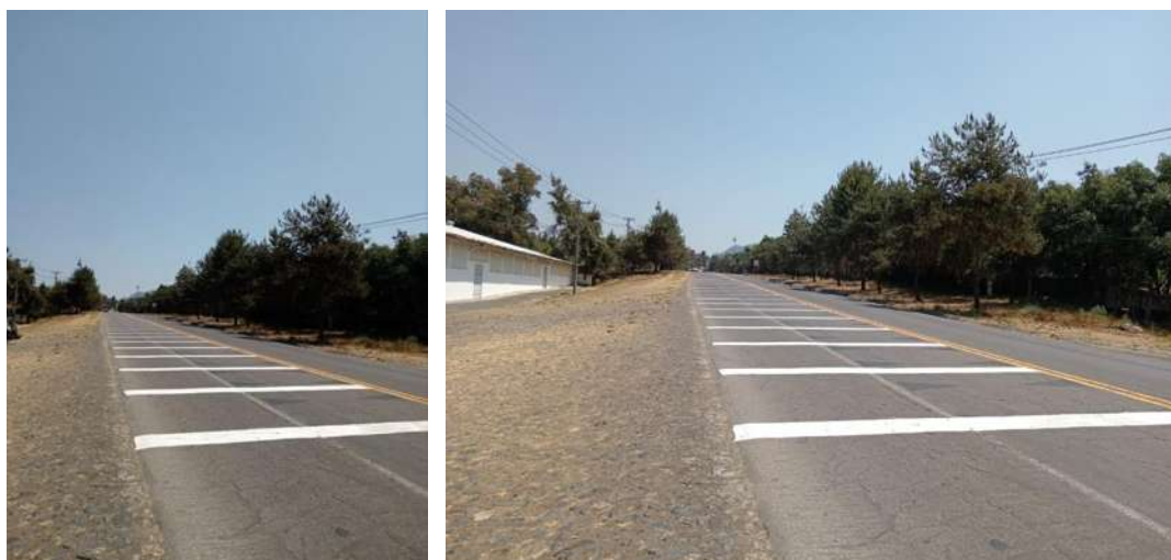
Figura 3-16. Carretera MEX-037 “Carapan – Playa Azul”, tramo “Carapan – Uruapan” con la marca vial “Rayas con Espaciamiento Logarítmico”.
