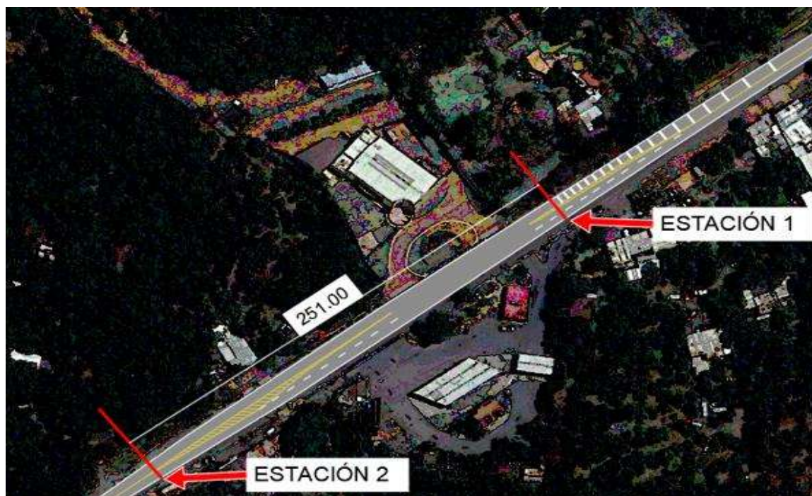
Figura 3-14. Carretera MEX-014 “Pátzcuaro – Uruapan”, km 58+600, marca vial “Rayas con Espaciamiento Logarítmico” colocada extremo aguas abajo a partir de la estación 1.
