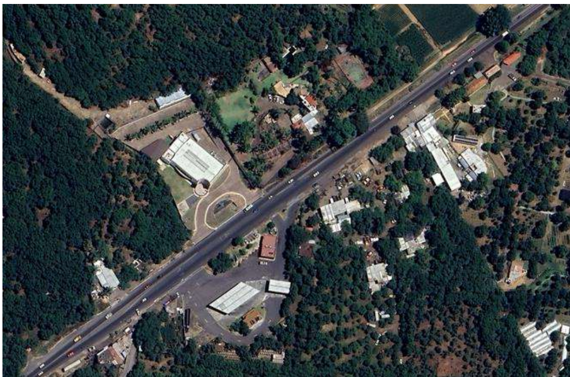
Figura 3-3. Carretera MEX-014 “Pátzcuaro – Uruapan”, km 58+600
