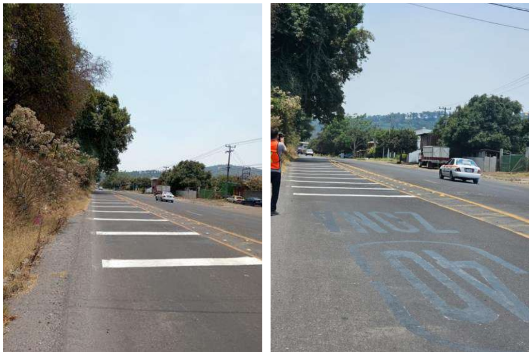
Figura 3-17. Carretera MEX-014 “Pátzcuaro – Uruapan” con la marca vial “Rayas con Espaciamiento Logarítmico”
