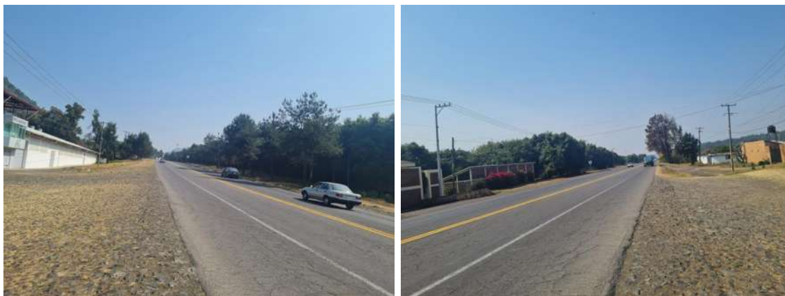
Figura 3-2. Carretera MEX-037 "Carapan - Playa Azul", tramo "Carapan - Uruapan" condición sin marca.
