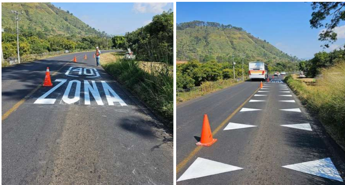
Figura 3-12. Carretera estatal “Uruapan – El Copetiro” con la marca vial “Dientes de Dragón”
