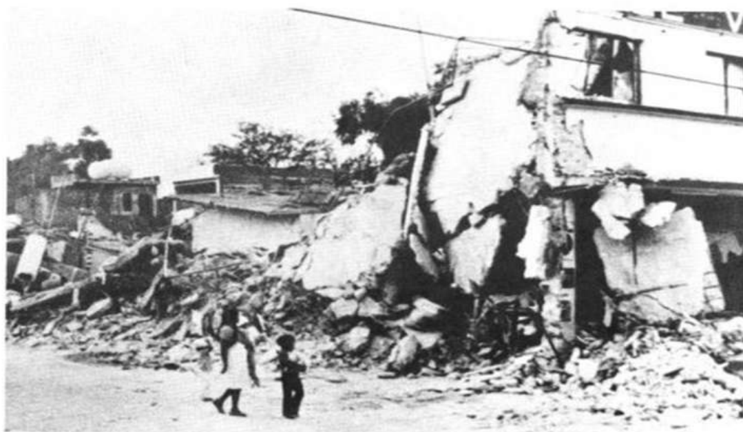
Figura 2. Fotografía de los daños en Huajuapán de León ante el sismo de 1980 (Tomada de CENAPRED, 2019).
