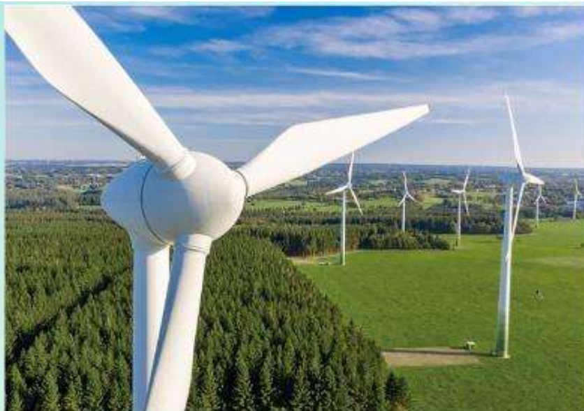
Figura 2. Turbina eólica (AESVAL, 2022).
