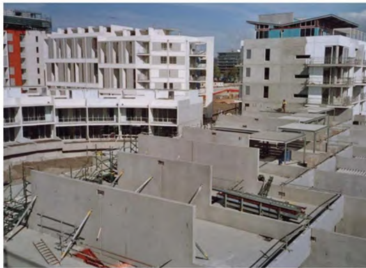
Figura 1.3 Muros prefabricados para uso residencial y comercial en Sídney, Australia (Modificada de Elliott y Hamid, 2017).
