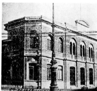
Nicolás Mariscal, Escuela Horacio Mann, Ciudad de México, 1905 Fuente: Manuel F. Álvarez, Los edificios de instrucción pública en México: el estado de avances realizados en los establecimientos oficiales y particulares hasta 1909 , Ed. Económica, México, 1910
