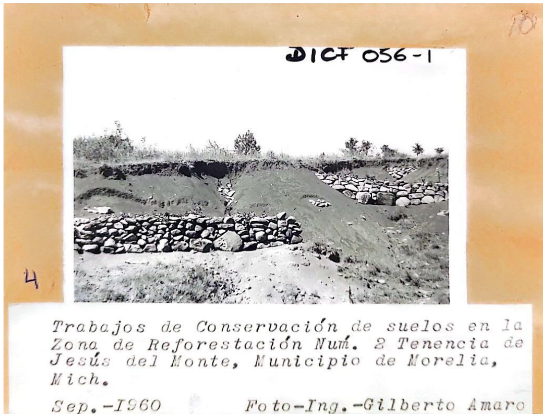
Imagen 12: Gaviones / presas de piedra.
