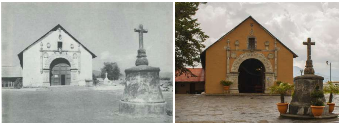
Fig. 43 Comparativa de fotografías con una diferencia temporal de 40 años, donde se observa que el cambio en la techumbre sigue presente. La estructura original, con probabilidad de tejamanil, no se distingue en ambas fotografías, en cambio se observa un material ligero, de apariencia homogénea, que podría corresponder a lámina galvanizada tipo teja. Autor: Josefina Muriel - Ana Cecilia Martínez Cruz.
