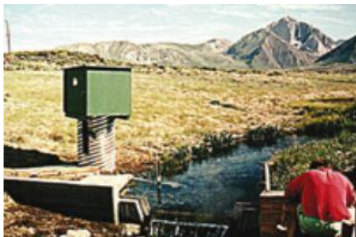
Figura 9 Control artificial, vertedor de cresta ancha de concreto (WMO, 2010)
