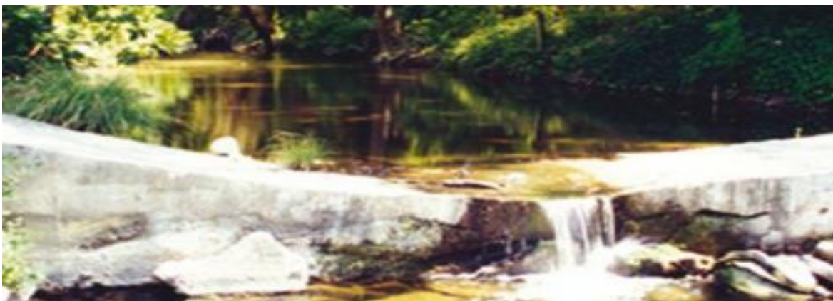
Figura 9 Control artificial, vertedor de cresta ancha de concreto (WMO, 2010)
