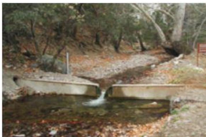
Figura 10 vertedero rectangular suprimido (WMO, 2010)
