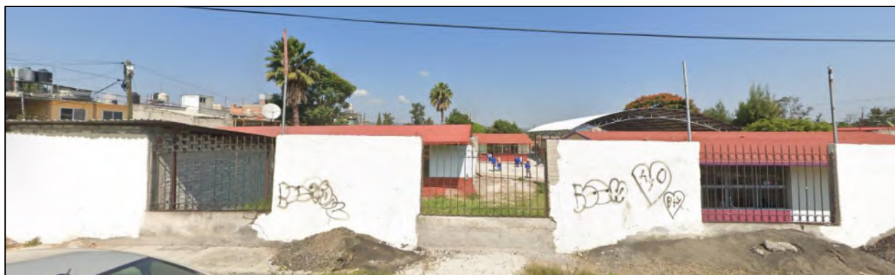
Figura 40. Escuela primaria Emancipación Proletaria, imagen tomada de Google Earth, octubre de 2024; donde se observa que ya no está el aula que fue demolida por daño estructural.
