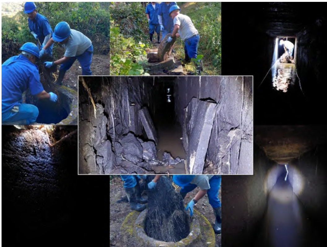
Figura 25.- Limpieza y condiciones internas del pozo 9 al 20.
