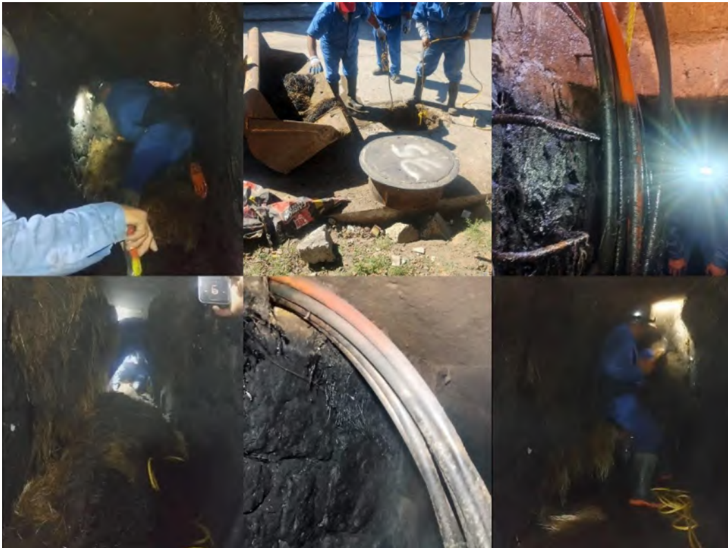
Figura 27.- Limpieza y condiciones internas del pozo 27 al 32 y pozo 35
