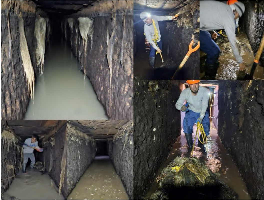
Figura 28.- Limpieza y condiciones internas del pozo 46 al 48.
