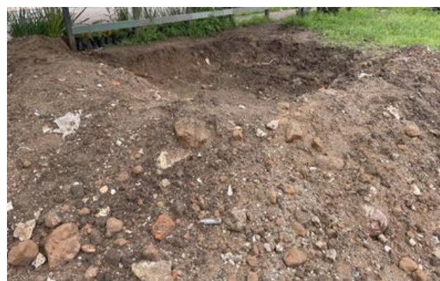
Ilustración 99. Identificación de estado actual del suelo . Propia de la autora.
