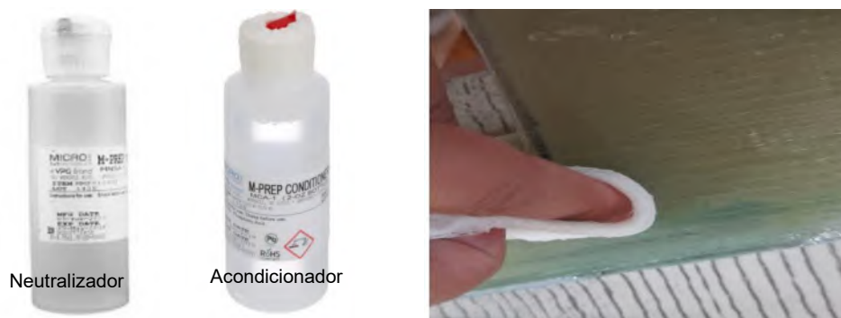
Figura 5.3. Preparación de la superficie.
