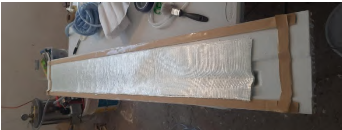
Figura 4.22. Colocación de las capas de fibra de vidrio.
