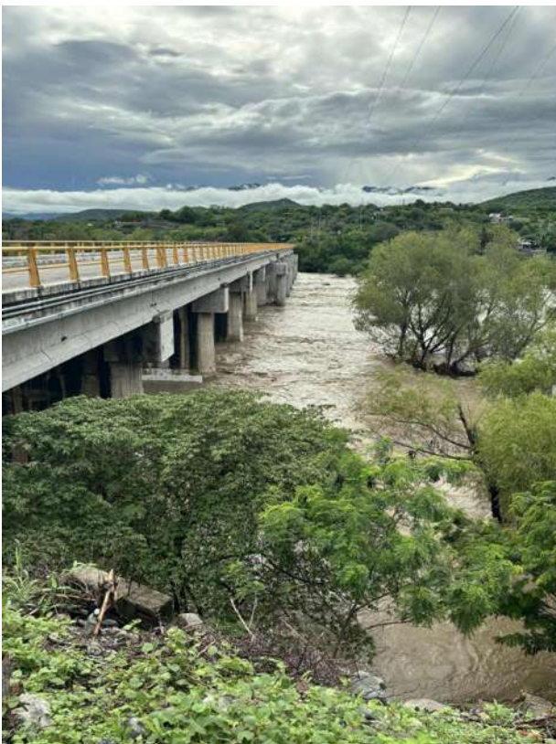
Fotografía 11: Vista del río tequisistlán, llegando a su máxima capacidad, esto sucede cuando existe una lluvia continua.
