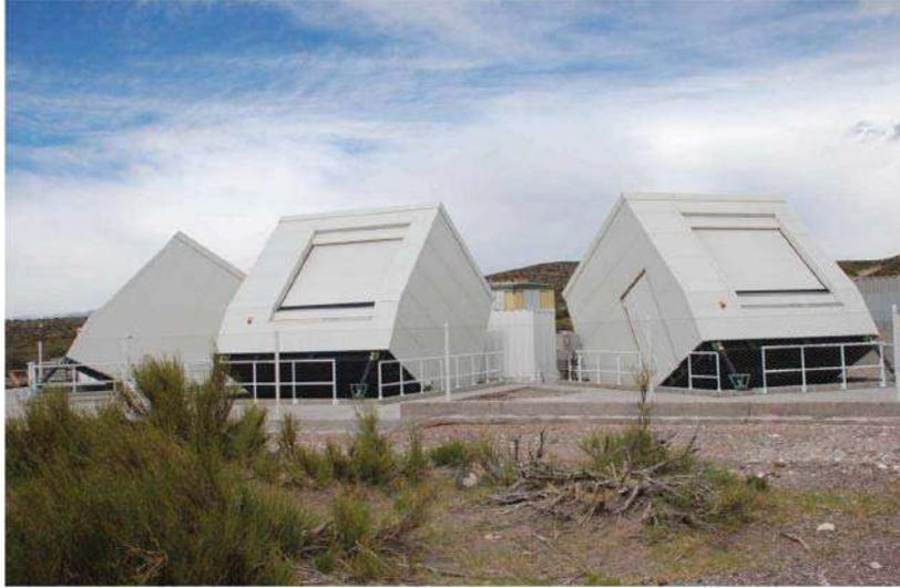
Figura 1.13: Fotografía de HEAT en el modo inclinado con persianas cerradas.
