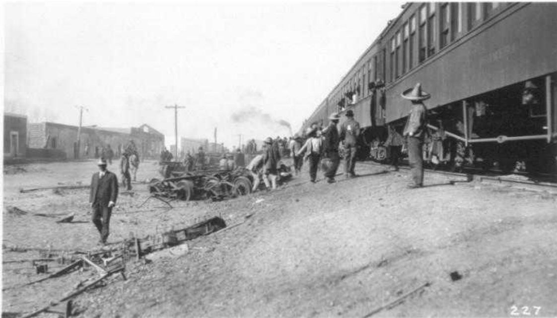
Reparando los trenes antes de partir a la batalla (ICHICULT).
