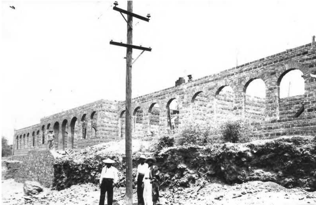
5. Fotógrafo desconocido, sin título, (hombres construyen la escuela primaria General, Casimiro Leco López), Cherán, Michoacán, México, Colección, Adalberto Muñoz Estrada.
