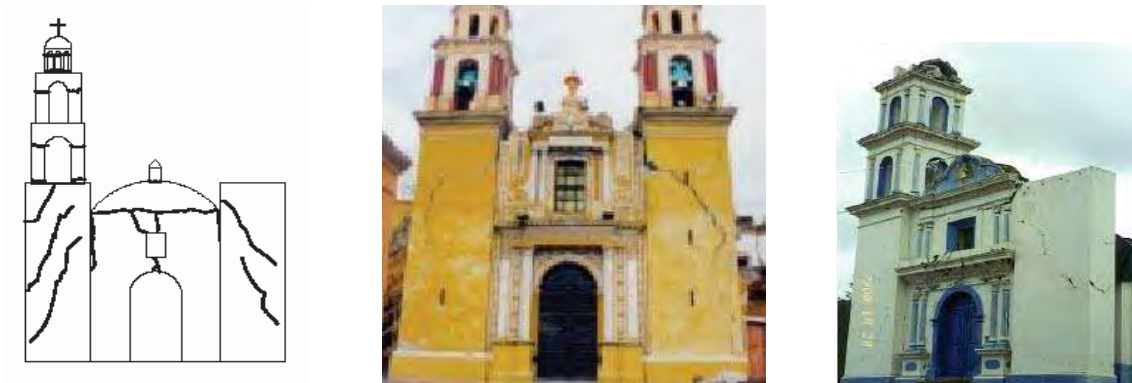
Fig. 17 Mecanismo de falla por cortante
