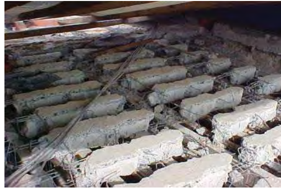
Foto 5 Losa reticular sobre sistema de viguería de madera Palacio Clavijero, Morelia Mich.
