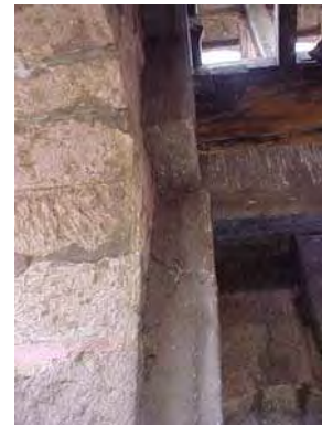
Foto 5 Losa reticular sobre sistema de viguería de madera Palacio Clavijero, Morelia Mich.
