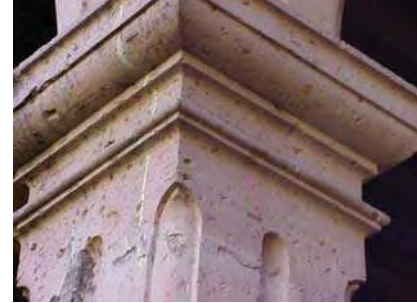
Foto 10 Esbeltez y presencia de fisura en columna de mampostería
