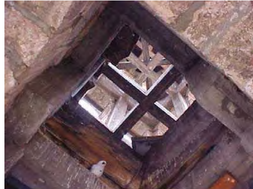
Foto 7 Traves y columnas de concreto reforzado en interior de torre campanario Templo de Capuchinas, Morelia Mich.
