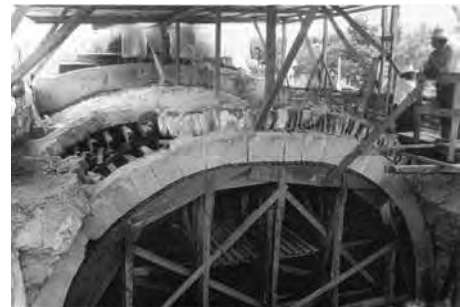
Foto 2 Rehabilitación de Arco y Bóveda
