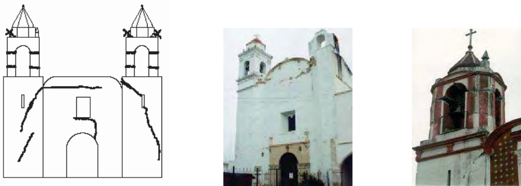
Fig. 16 Mecanismo de falla fuera de plano ante el efecto sísmico
