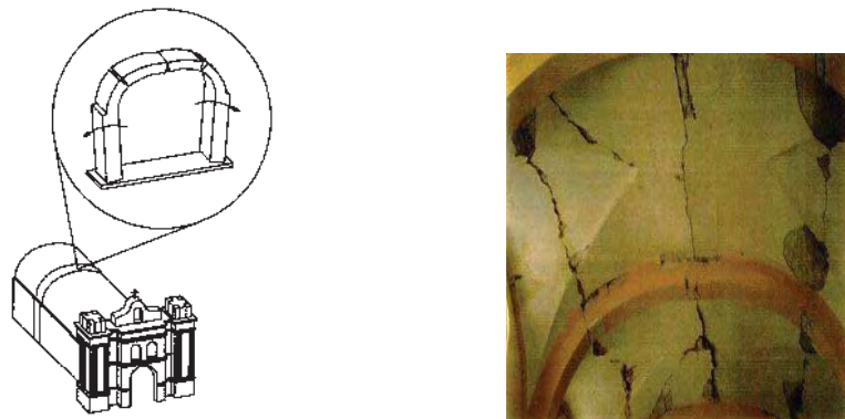
Fig. 20 Falla de bóveda por abertura de sus apoyos
