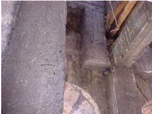
Foto 7 Traves y columnas de concreto reforzado en interior de torre campanario Templo de Capuchinas, Morelia Mich.
