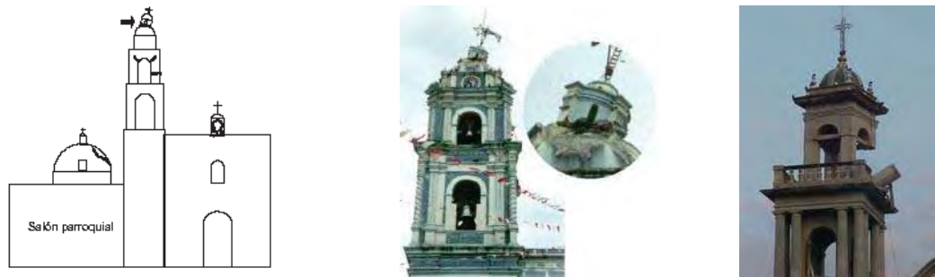
Fig. 21 Falla por esbeltez y flexibilidad en la torre campanario y cupulín
