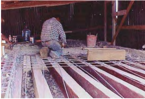
Foto 4 Losa de concreto reforzado sobre vigas de madera Palacio Clavijero, Morelia Mich.
