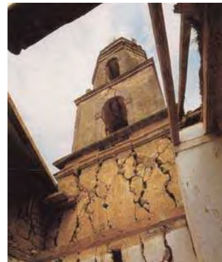
Foto 9 Falla por cortante en tambor y cuerpo de torre campanario por efecto sísmico
