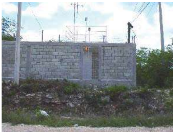
Figura 49. Estación de medición existente en la ZTU 7, ubicada en terrenos de la planta de generación de energía eléctrica Mérida III, a la cual pertenece, en los límites de la ciudad, en donde predominan las condiciones no urbanas.
