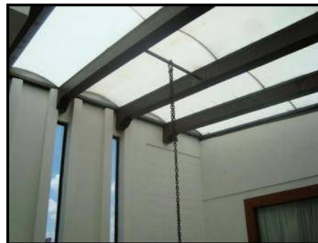
Figura 49. Lucernario. (E. Paredes, 2009).
