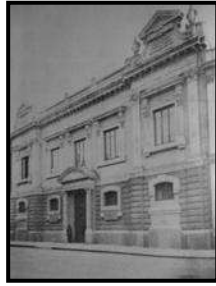
Figura 5. Fachada del edificio de oficinas de la Secretaría de Relaciones Exteriores 35 .
