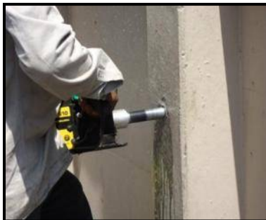
Figura 24. Equipo utilizado para extracción de muestras de concreto. (E. Paredes, 2011).
