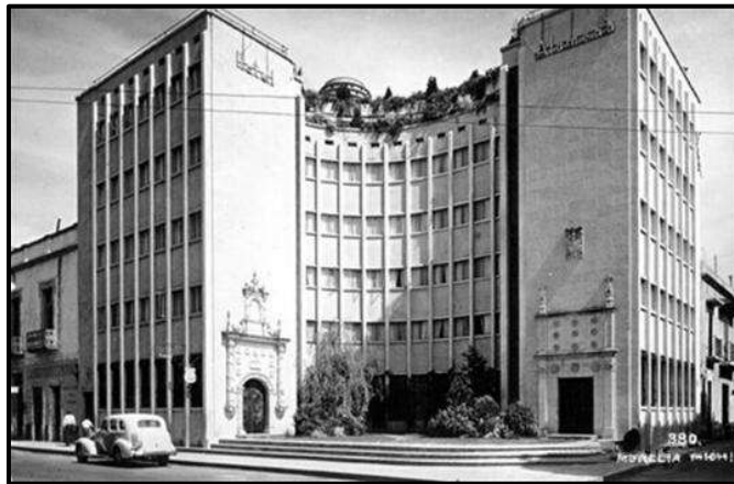
Figura 39. Hotel Alameda, en la década de los 40's 218 .
