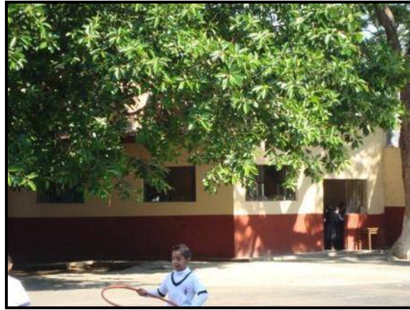
Figura 79. Adiciones recientes en la esquina noroeste del predio. (E. Paredes, 2010).
