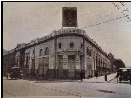
Figura 4. Primera construcción de concreto reforzado en México. Esquina de Artes y París, Cd. de México 31 .
