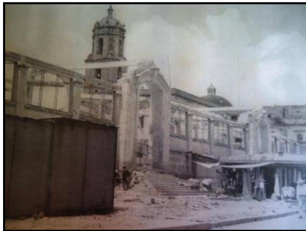
Figura 10. Demolición del Mercado Valladolid 54 .
