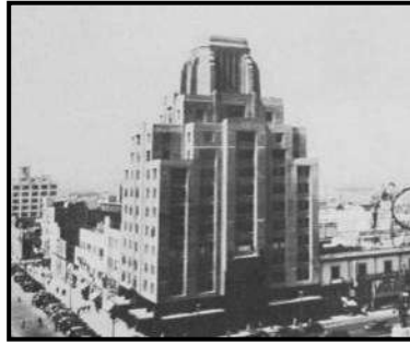
Figura 7. Edificio La Nacional en la década de los 40's 42 .
