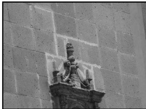
Figura 42. Reparaciones efectuadas al exterior del edificio. (E. Paredes, 2009).
