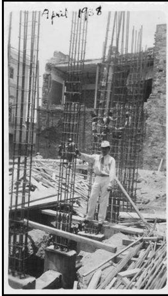
Figura 38. Construcción del hotel Alameda, abril 1938 217 .
