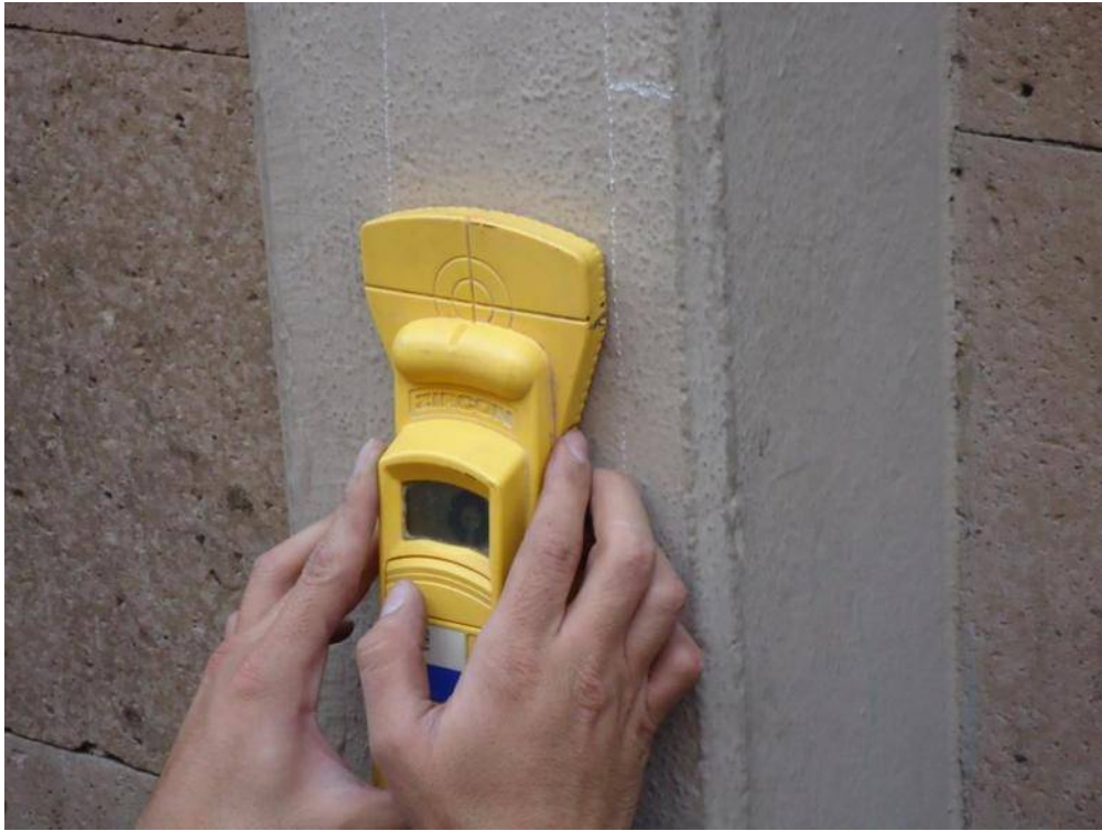
Detección del acero de refuerzo en columnas del hotel Alameda (E. Paredes, 2011).
