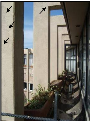
Figura 103. Columnas del quinto piso del hotel Alameda, fachada sur. (E. Paredes, 2010).
