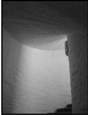
a) Muros de carga y losa de la escalera de caracol.
