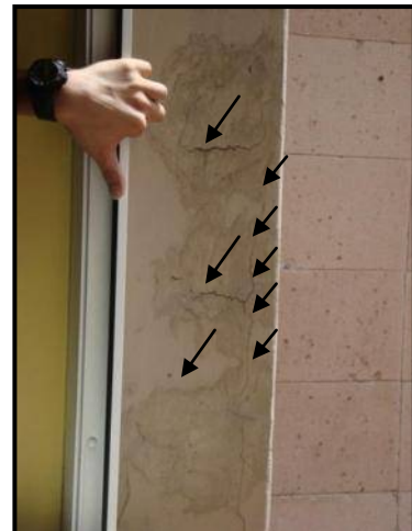
Figura 105. Columnas del segundo piso del hotel Alameda fachada este, resanadas. (E. Paredes, 2010).
