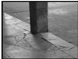
Figura 75. Daños ocasionados por hundimientos diferenciales en el ala norte de la escuela. (E. Paredes, 2010).
