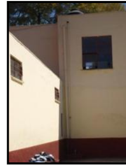
Figura 70. Bajadas de agua ubicadas en la parte exterior de los muros que desembocan en una coladera. (E. Paredes, 2010).
