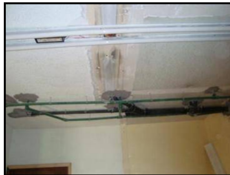
Figura 90. Registro fotográfico de las transformaciones efectuadas al interior del edificio Sandoval. (E. Paredes, 2009-2010).
