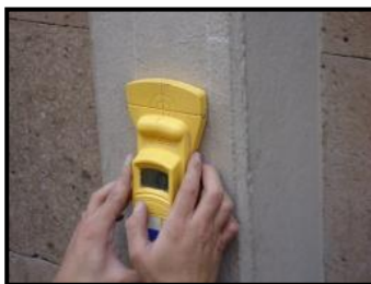
1. Trazado de la ubicación del refuerzo de las columnas con ayuda del metalliscanner
