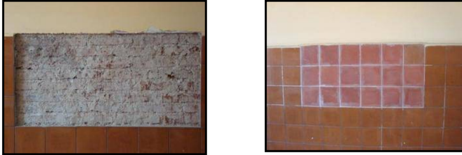
Figura 72. Pared con recubrimiento de mosaico antes y después de su reparación. (E. Paredes, 2009-2010).
