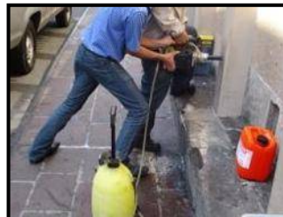
2. Extracción de especímenes de concreto en la estructura del Alameda
