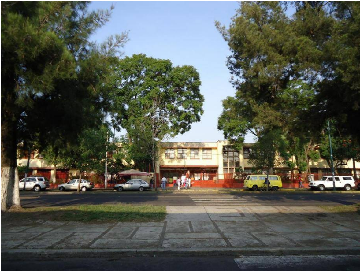
Centro Escolar Independencia (E. Paredes, 2011).
