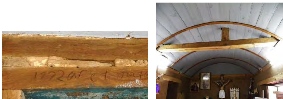
Imagen 36. Modificación de la cubierta de la sacristía (1722) y cuarto anexo del templo de Nuestra Señora de la Asunción Fotografías: autora.
