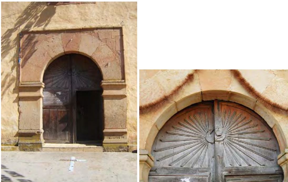
Imagen 46. Jambas, dovelas y tallas presentes en el portón principal del templo Fotografías: autora.
