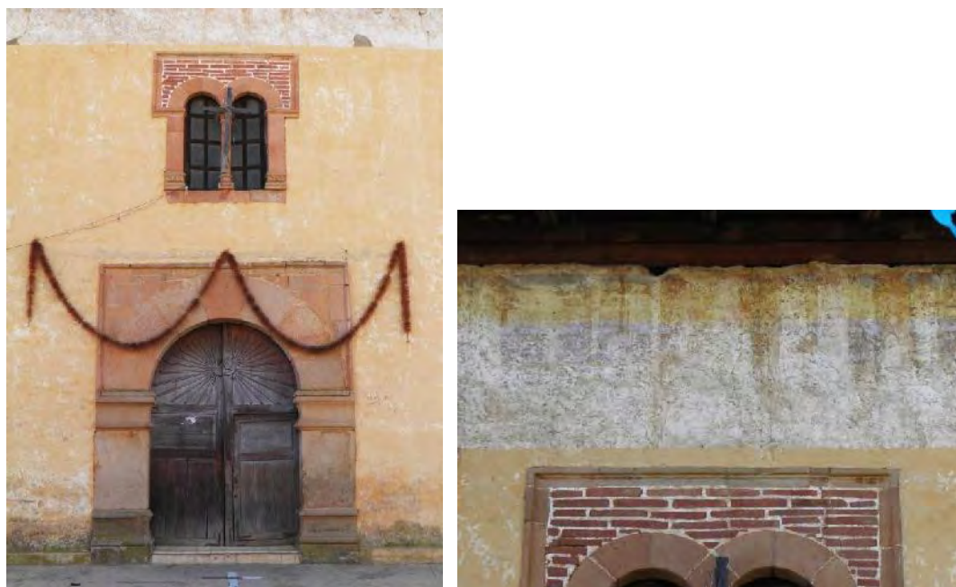
Imagen 47. Ventana coral del templo de Santa María Huiramangaro y cenefa ubicada en la parte superior colindante con la cubierta Fotografías: autora.
