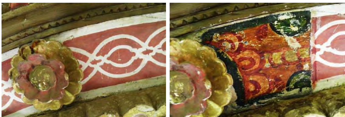
Imagen 78. Cala de limpieza ejecutada en el perímetro del arco central de la arcada triunfal. Representación del cordón franciscano Fotografías: autora
