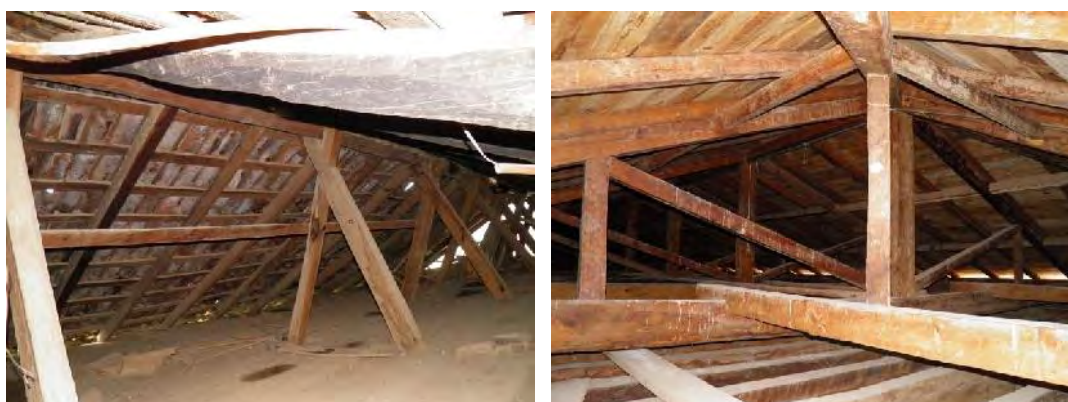
Imagen 41. Estructura de la cubierta de la sacristía y del templo de Nuestra Señora de la Asunción; siglo XX. Fotografías: Autora
