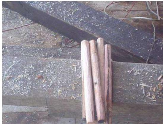
Figura 14. Clavocotes para armado de cubierta, Zacán, Michoacán.
