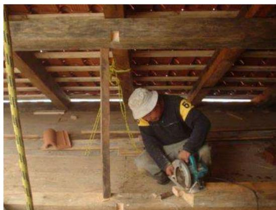
Figura 10. Corte de madera con sierra para ensambles, Zacan, Michoacán
