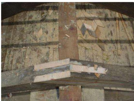
Figura 9. Sistema de ensambles en vigas de madera, Zacan, Michoacán
