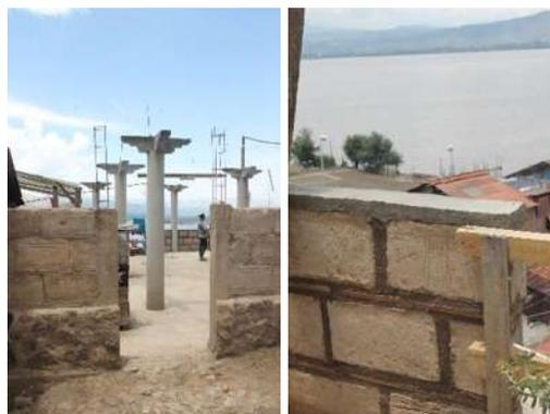
Figura 42. Construcción con adobe integrando concreto en la estructura, Janitzio, Michoacán.
