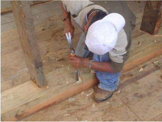
Figura 11. Sistema de ensambles en vigas de madera, Zacán, Michoacán.
