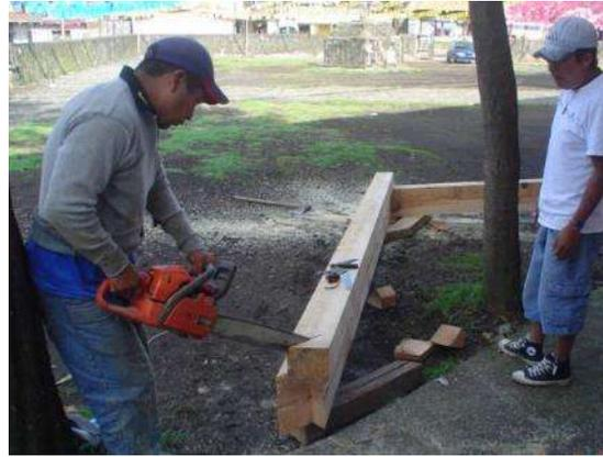
Figura 12. Corte de madera con motosierra para ensambles, Zacán, Michoacán.
