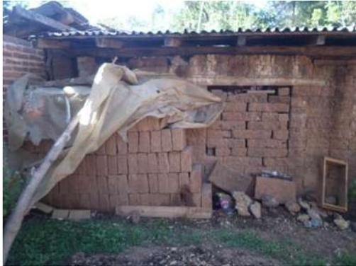
Figura 26. Apilado de adobes después del secado cubiertos con plástico, Tzurumútaro, Michoacán.
