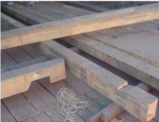
Figura 13. Ensamblados en madera para armado de cubierta, Zacán, Michoacán.
