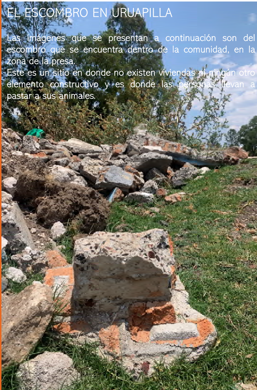
225_ Gómez Miguel. (2020). Escombro en Uruapilla.
