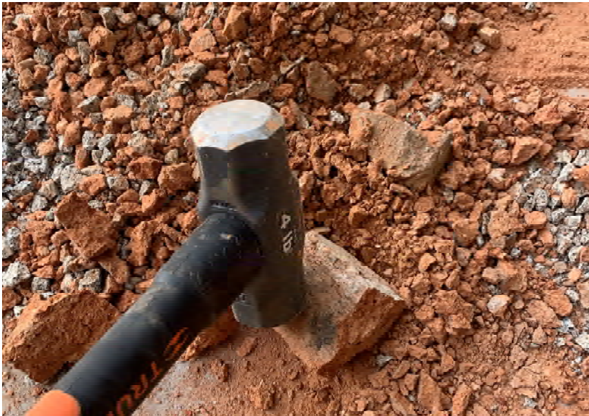
79_ Gómez Miguel. (2020). Trituración de escombros.
