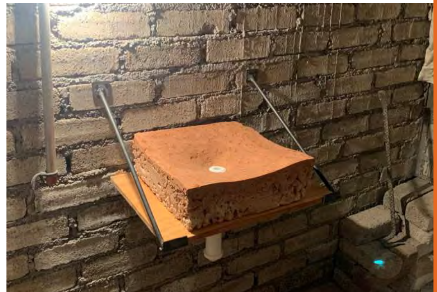
280_ Gómez Miguel. (2020). Montaje de Lavamanos
