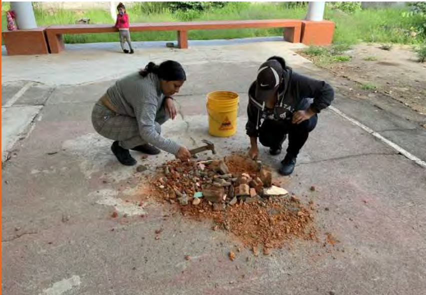
292_ Gómez Miguel. (2020). Trituración de escombro
