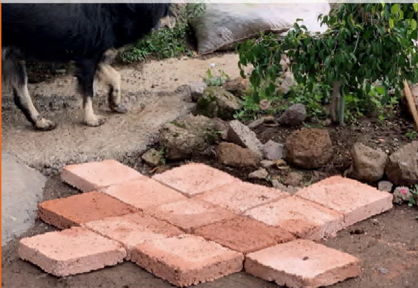
281_ Gómez Miguel. (2020). Montaje de adoquines
