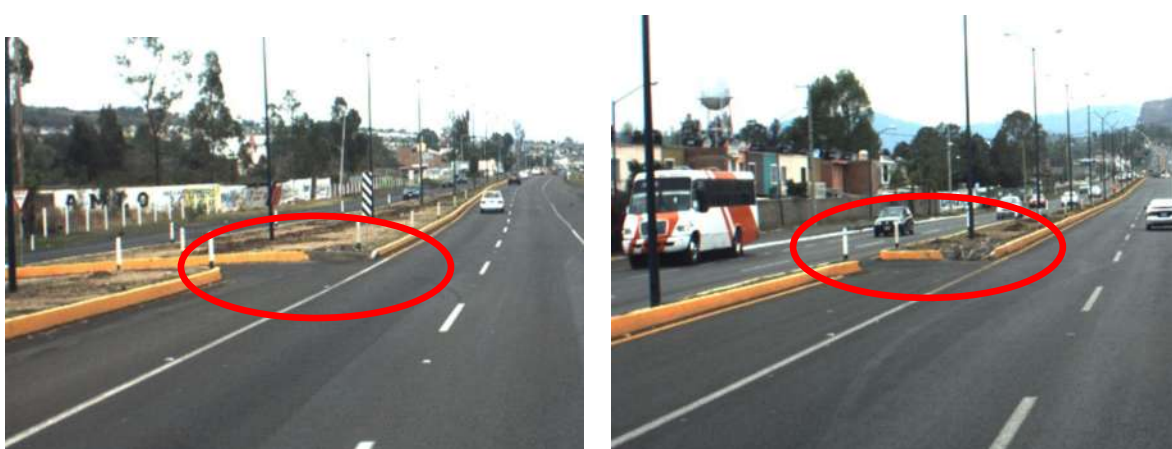
Fotos 5.36 y 5.37. Guarniciones en retornos que funcionan como rampas.
