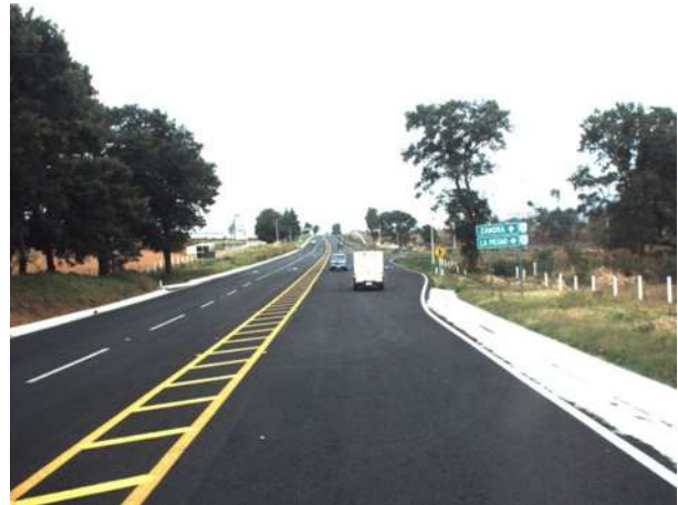
Fotos 5.20 y 5.21. Ejemplo de zonas en donde si contiene rayas canalizadoras (Raya M-5).
