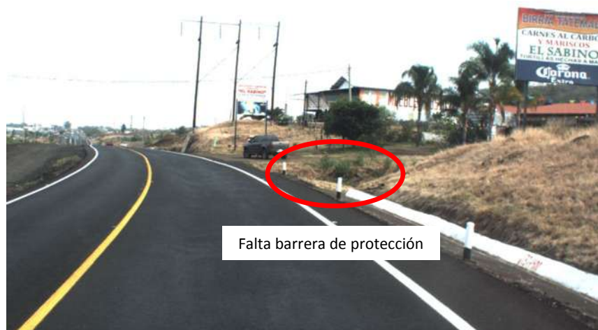
Foto 5.41. Acceso a restaurant en km 137+440
