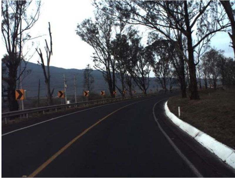
Foto 5.6 tramo donde existe barrera de protección (Marcado en morado en google earth)
