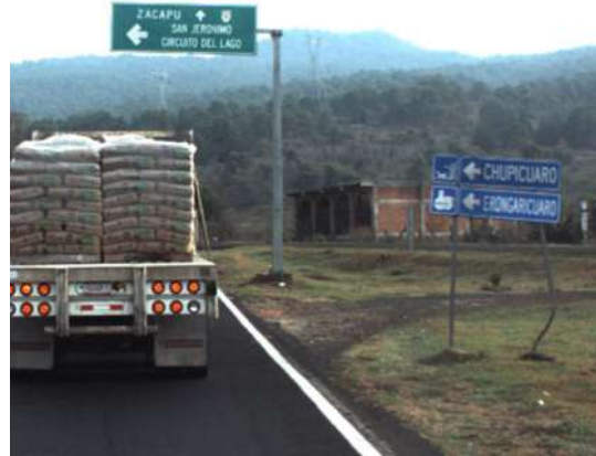
Fotos. 5.34 y 5.35. Señales de destino fuera de norma y dañadas.
