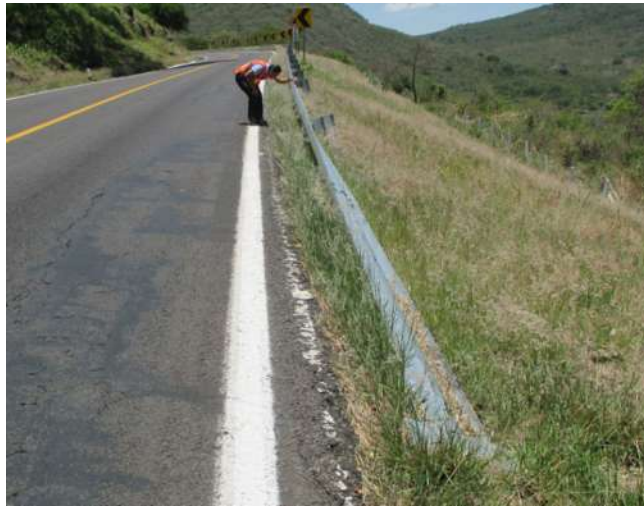
Foto 6.5 Barrera de protección aterrizada en su inicio.
