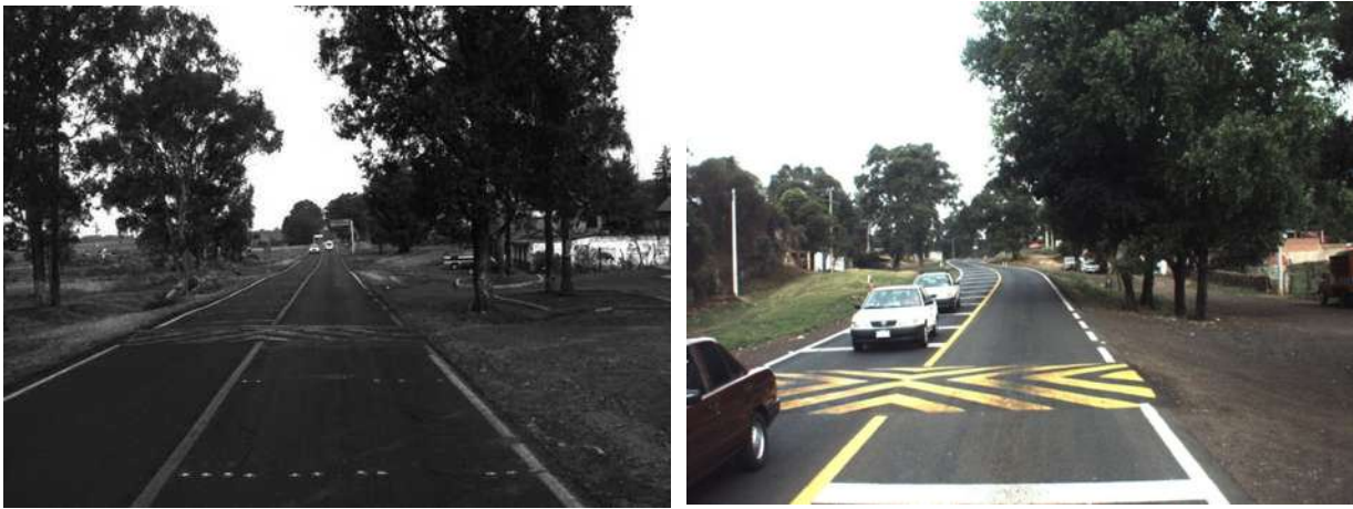
Fotos 5.22 y 5.23. Líneas con espaciamiento logarítmico y reductor de velocidad.
