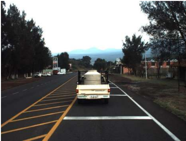
Fotos 5.20 y 5.21. Ejemplo de zonas en donde si contiene rayas canalizadoras (Raya M-5).
