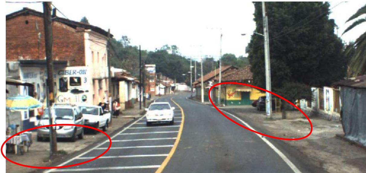
Foto 5.4. Postes cercanos a la orilla del camino, en zona urbana.
