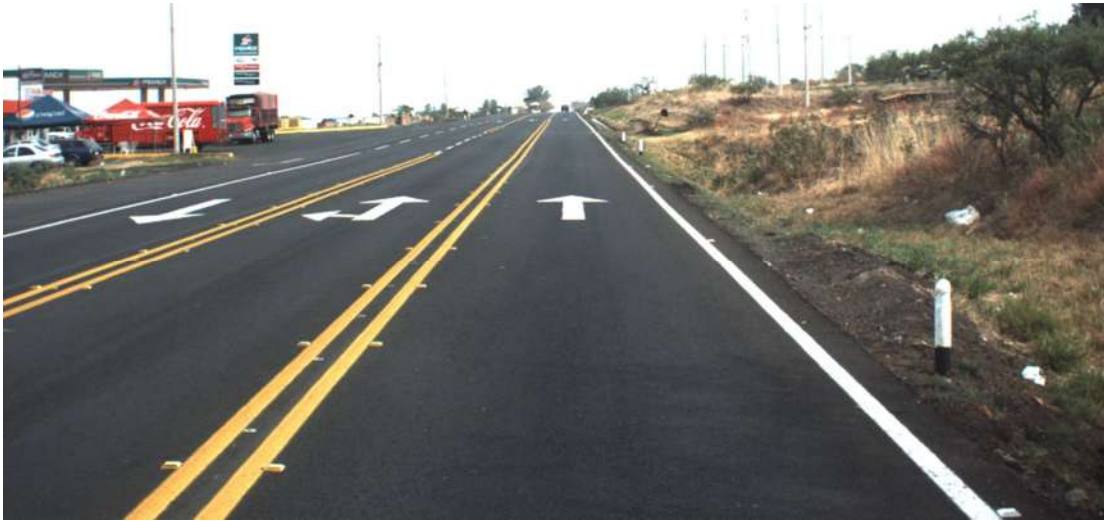
Foto 5.42. Acceso a estación de servicio ubicada en el km 138+540.
