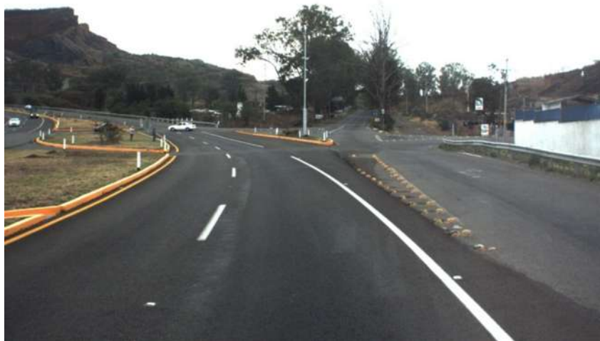
Foto 5.38. Intersección del km 13+000 (Sitio 2 de la tabla 5.17)
