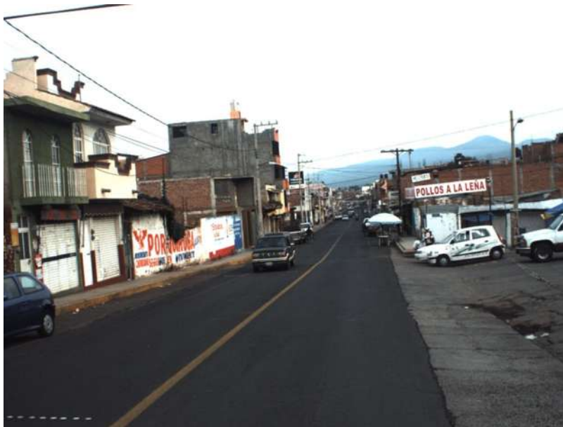
Foto 5.7. Tramo donde no se puede instalar barrera, propuesta por iRap (Sitio marcado en color rojo en google earth)
