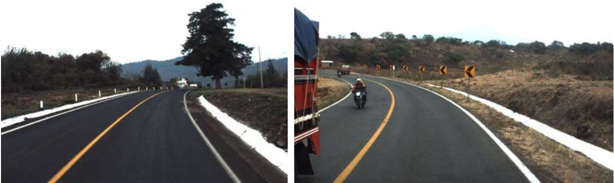
Fotos 5.24 y 5.25. Ejemplos de indicadores de alineamiento (OD-6) existentes y faltantes.
