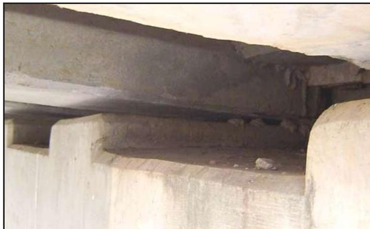
Figura 5.25 Perspectiva de apoyo extremo sobre placa de neopreno.
