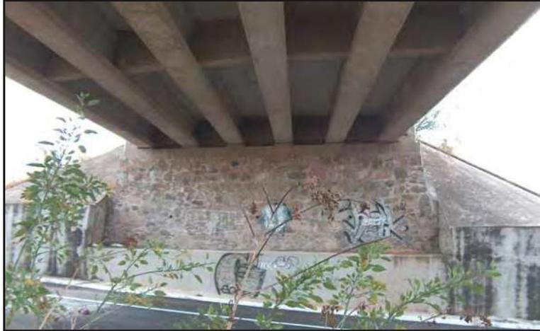
Figura 5.23 Vista del apoyo extremo, estribo.
