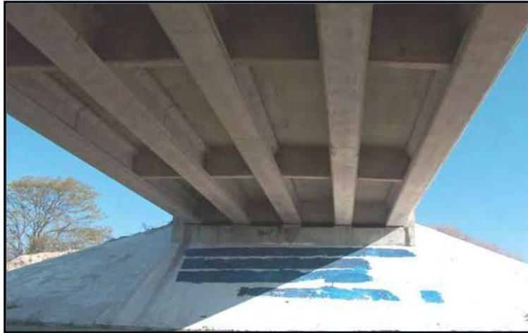
Figura 5.7 Vista inferior y del apoyo extremo del puente Maravatío k157.
