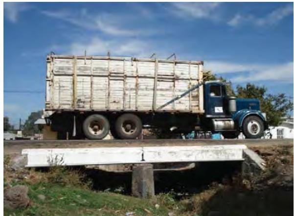
(r) Paso de un camión HS-15 sobre el puente
