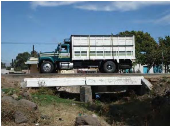
(q) Paso de un camión H20 sobre el puente
