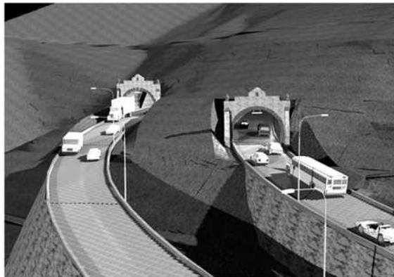
**FIG. 3-1 PORTALES QUE CONECTAN LA VIALIDAD PANORÁMICA ECOLÓGICA CON EL TÚNEL VIAL EN EL ESCARPE DE FALLA “LA PALOMA” SOBRE EL CUERPO INESTABLE CONOCIDO COMO SEDUE (PROYECTO EJECUTIVO, 2006)**
