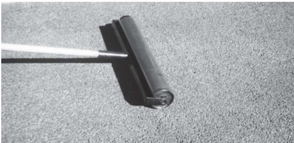
Fig. 2.2 Compactación de concreto permeable con rodillo pequeño (ACI 522R-06, 2006).
