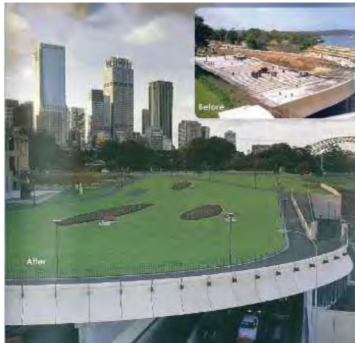
Fig. 1.5.- Cubiertas verdes con el sistema Atlantis®. (Atlantis®, 2006)
