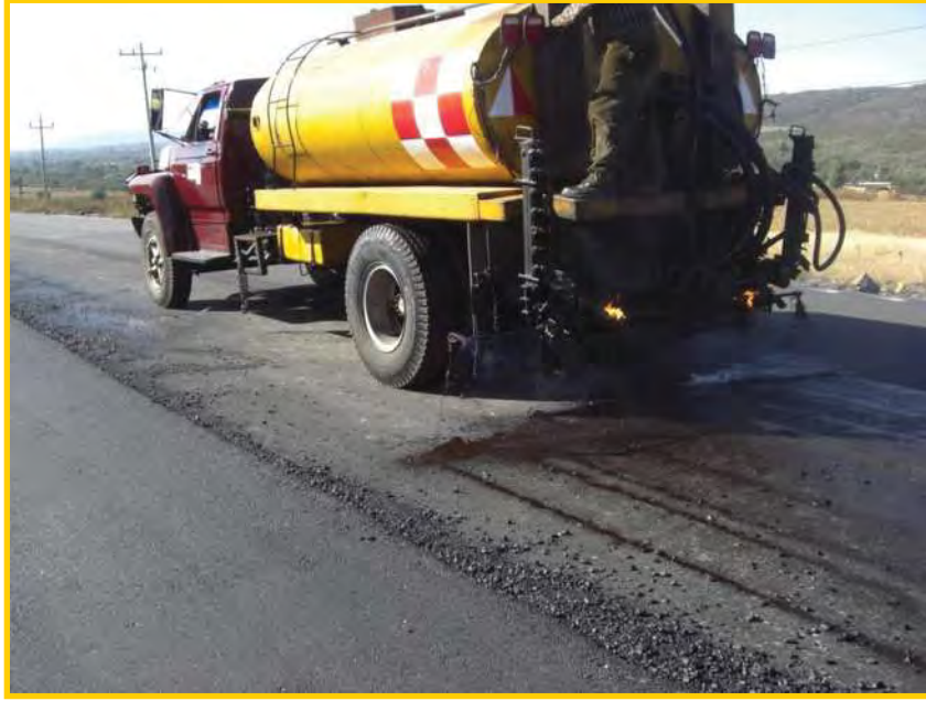
Fig. 6.28: Riego de liga no cumple con el cubrimiento uniforme.
