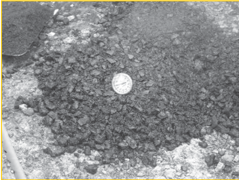
Fig. 6.26: Revisión de la temperatura en mezcla densa (175°C)
