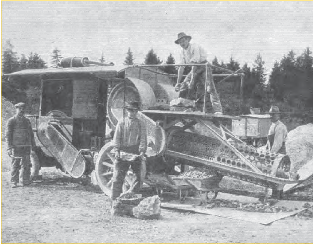
Fig. 4.11: Trituradora Automóvil de 12 HP, utilizada principalmente en Europa aproximadamente para el año de 1920
