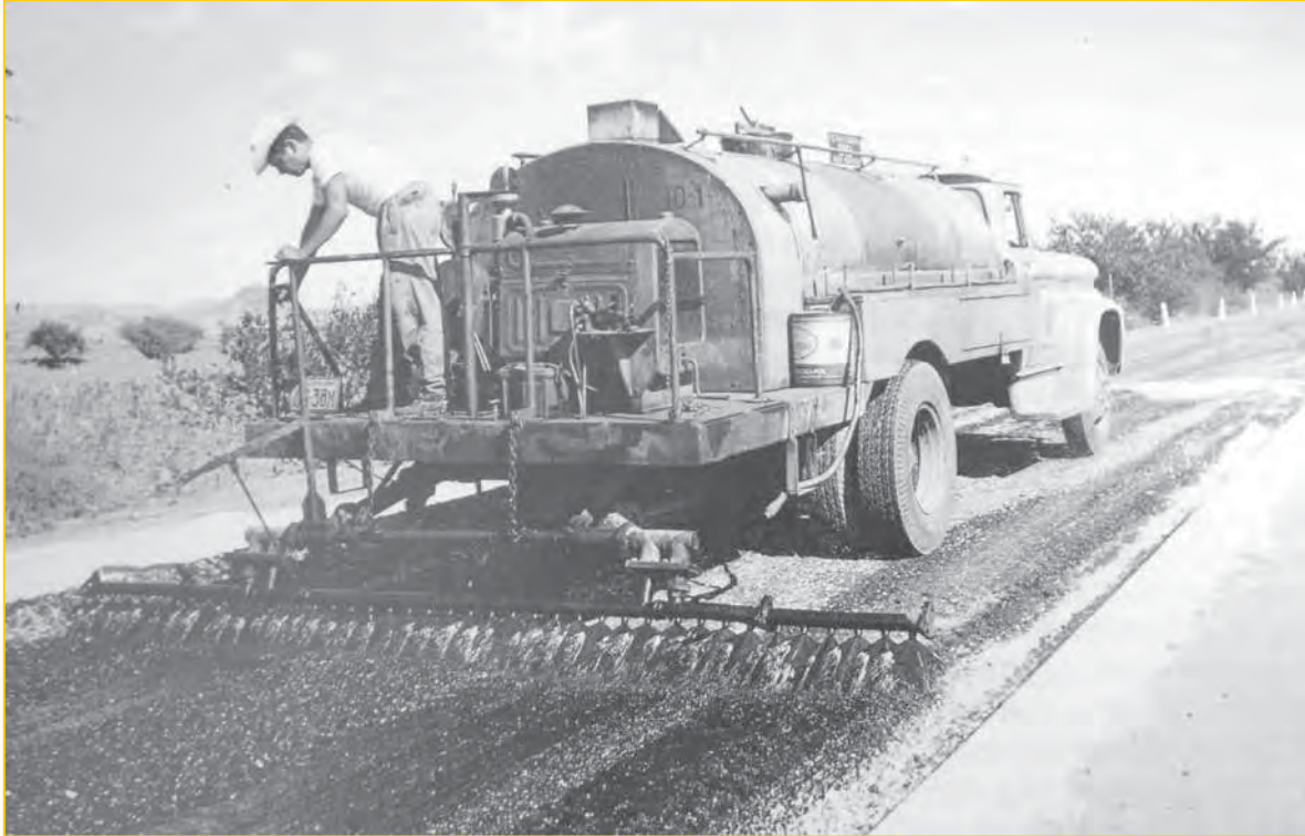
Fig. 4.19: Riego de asfalto en la construcción de la autopista México - Cuernavaca. Fuente: Historia de los caminos de México, tomo 3; siglo XX, Banco Nacional de Obras y Servicios Públicos S.N.C.
