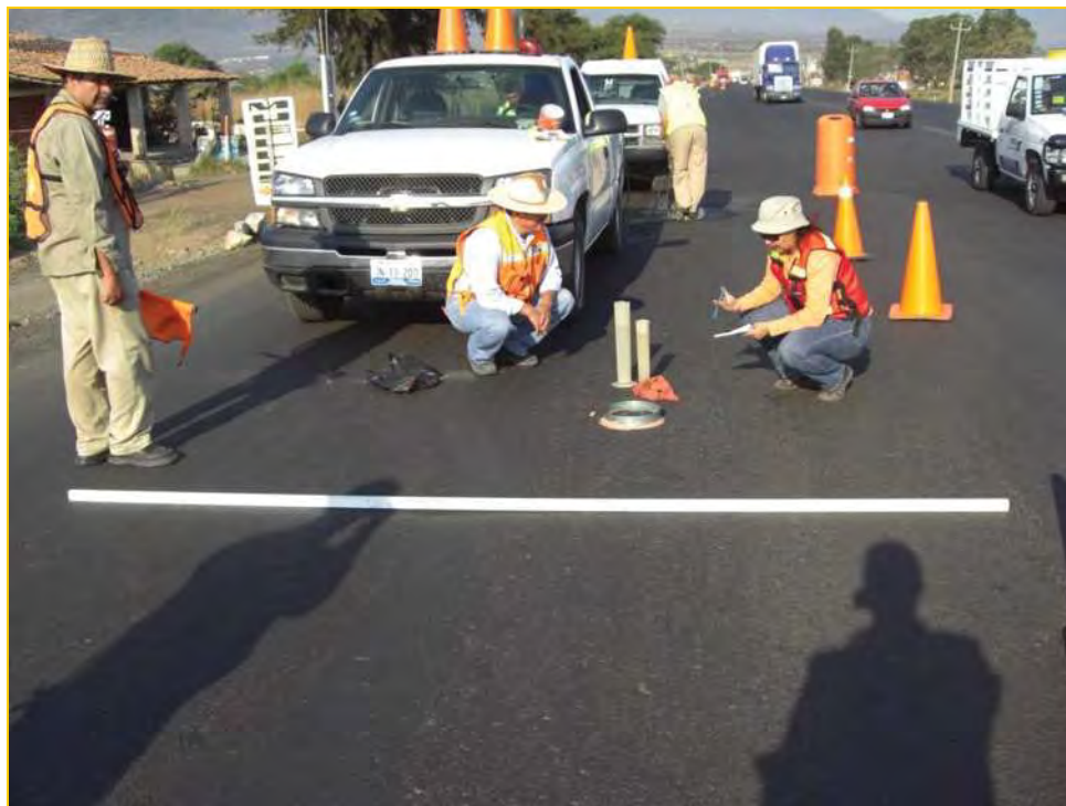
Fig. 6.85: Brigada trabajando en extracción de núcleos, permeabilidad y deformación.
