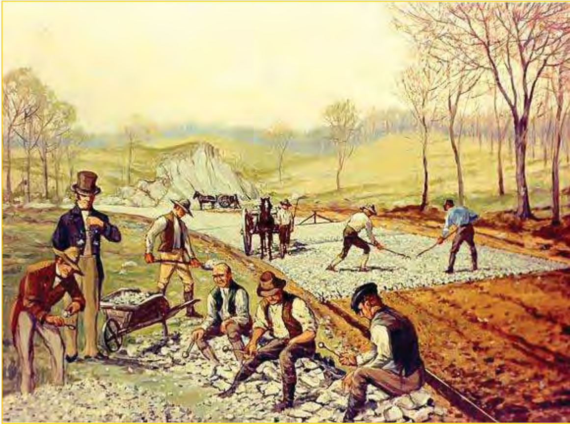
Fig. 4.10: Primer pavimento americano de macadam en 1823, la pintura de Carl Rakeman indica el proceso constructivo que se empleó.
