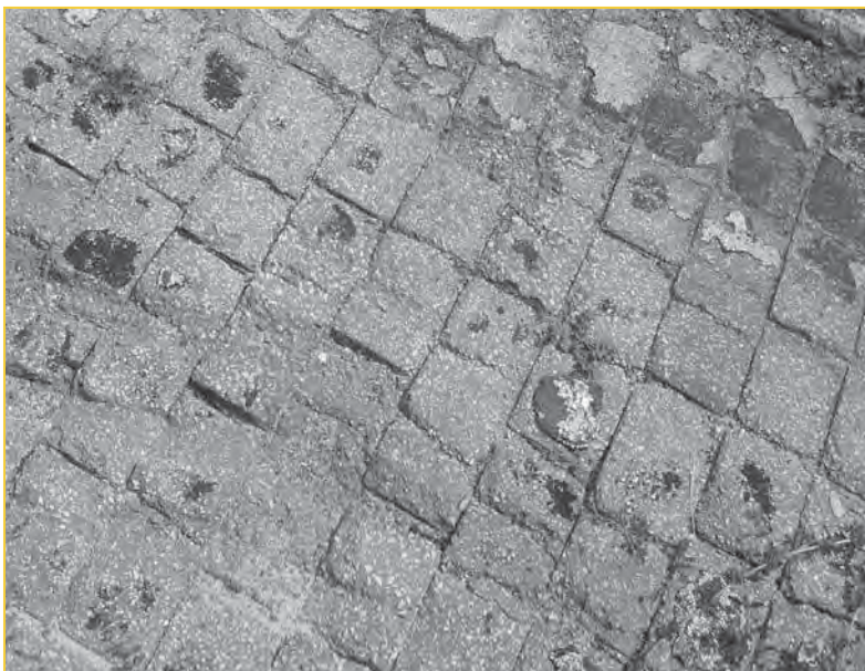
Fig. 4.7: Pavimento con bloques comprimidos de concreto asfáltico.
