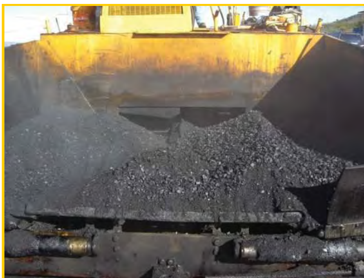
Fig. 6.32: Material en la tolva receptora de la pavimentadora muy clasificado.
