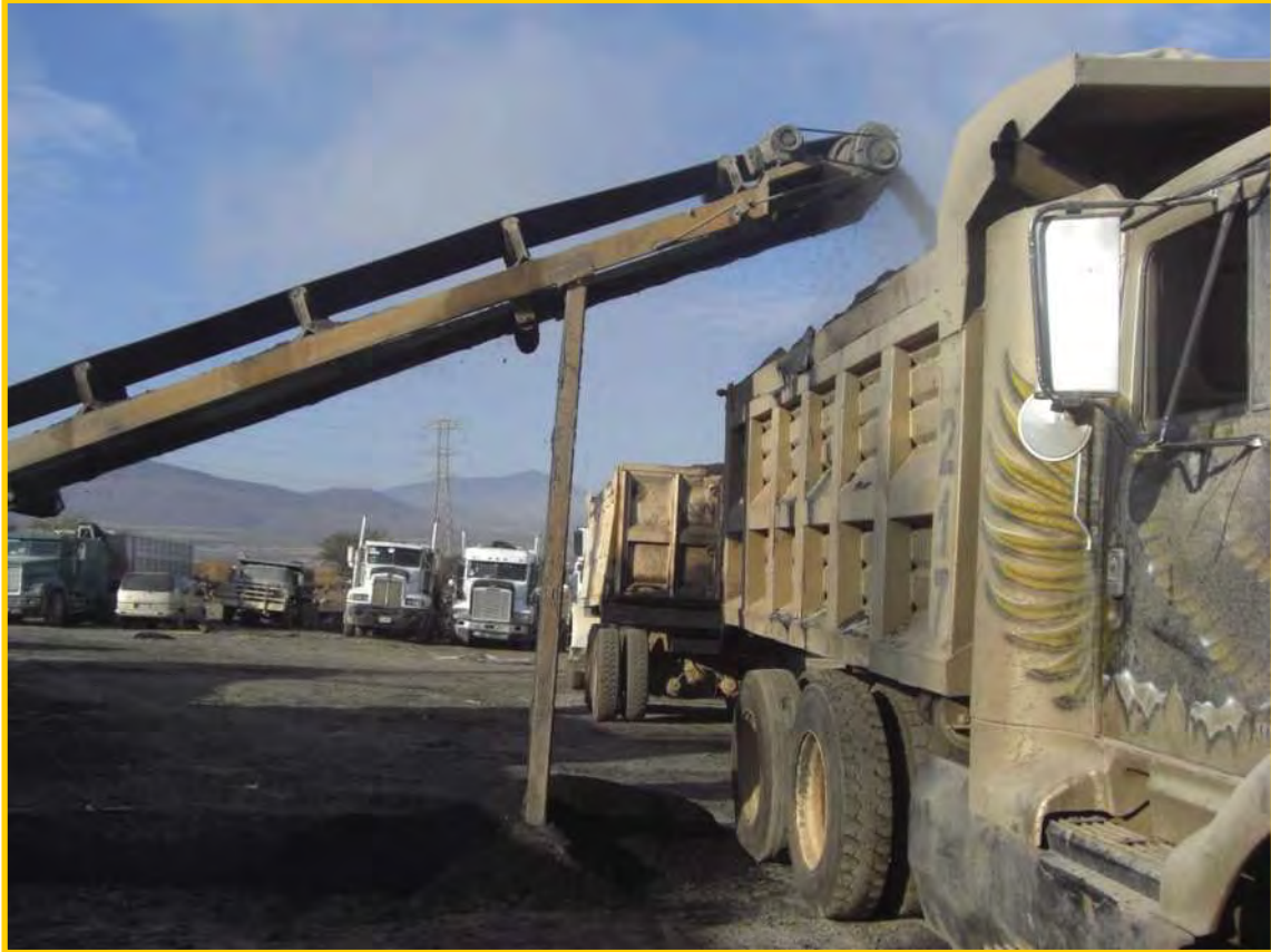
Fig. 6.23: Banda transportadora con asfalto adherido y sin dispositivo de carga que provoca una clasificación del material.
