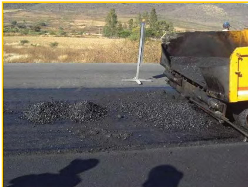
Fig. 6.33: Montículos de material de desperdicio son colocados por delante de la pavimentadora para ser tendidos.
