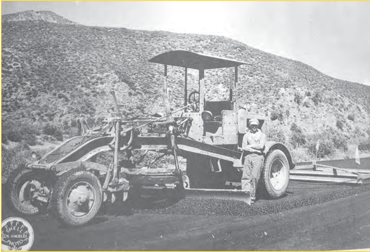
Fig. 4.15: Motoconformadora tendiendo mezcla asfáltica, además equipada en su parte trasera con una especie de terminadora superficial utilizada en los años treinta. Fuente: Historia de los caminos de México, tomo 3; siglo XX, Banco Nacional de Obras y Servicios Públicos S.N.C.
