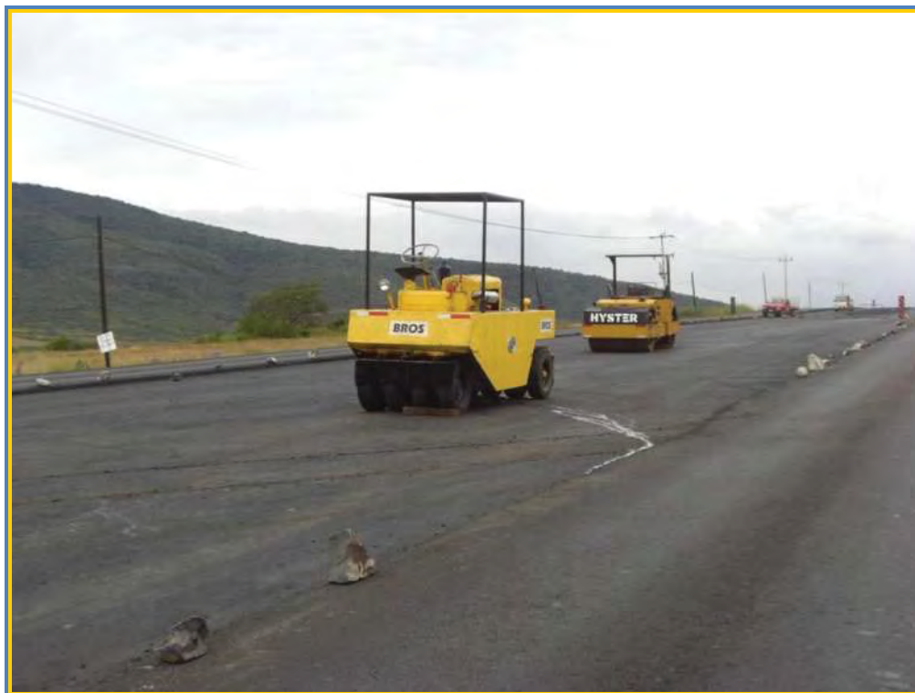
Fig. 6.36: Equipo de compactación
