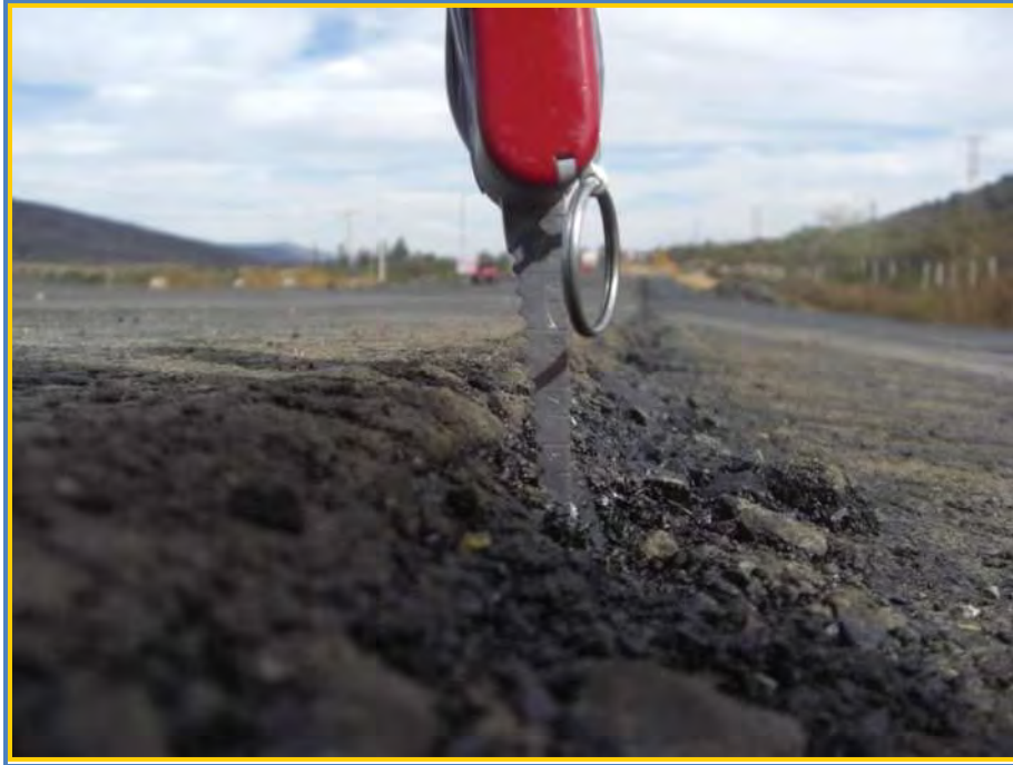
Fig. 6.17: Espesor de 2ª capa de base asfáltica de 4.5cm en el km 14+320 lado derecho.
