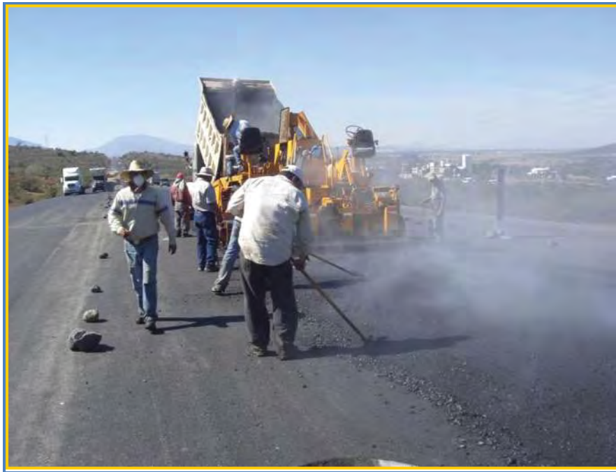
Fig. 6.30: Tendido y rastrillado de mezcla densa.
