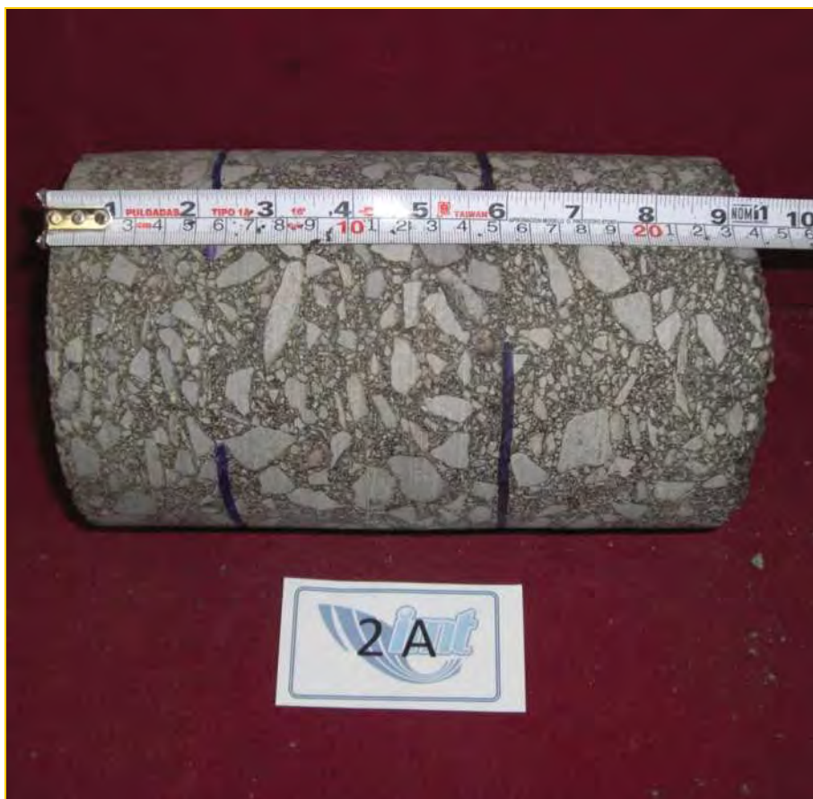
Fig. 6.86: Núcleo de la estación 13+200 con espesor mezcla densa de 5.5cm y dos capas de base asfáltica.
