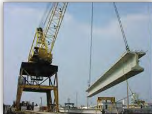
Figura 2.2. 28. a) Almacenamiento de las losas prefabricadas con concreto autocompactable para su uso en la construcción del puente de Nebraska Skyline.
