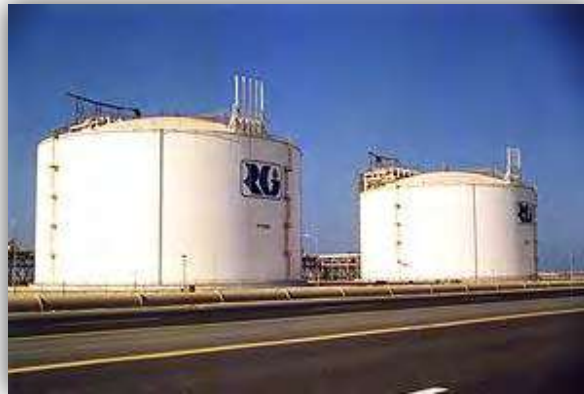
Figura 2.2. 27. Estanque pretensado para Gas licuado de Osaka Gas Company en Japón, ( http://inciarco.com/foros//showthread.php?p=22358&page=2 fecha de consulta 09/08/2011).
