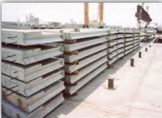
Figura 2.2. 28. a) Almacenamiento de las losas prefabricadas con concreto autocompactable para su uso en la construcción del puente de Nebraska Skyline.
