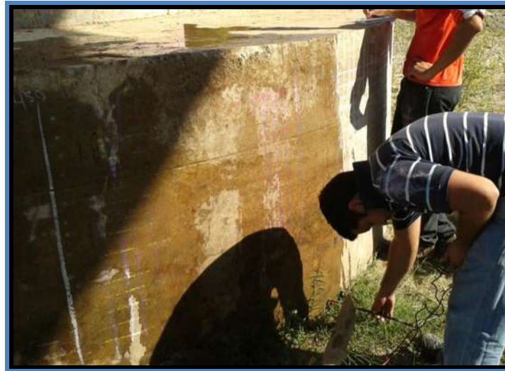
Foto VI.16 Medición de Potenciales del Puente “El Cayaco”, Lázaro Cárdenas. (18/JUN/2011).
