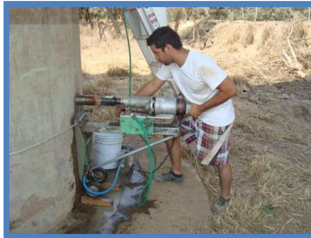
Foto VI.1 Extracción de núcleos, del Puente “El Cayaco” Lázaro Cárdenas, Michoacán. (04/JUN/2011).
