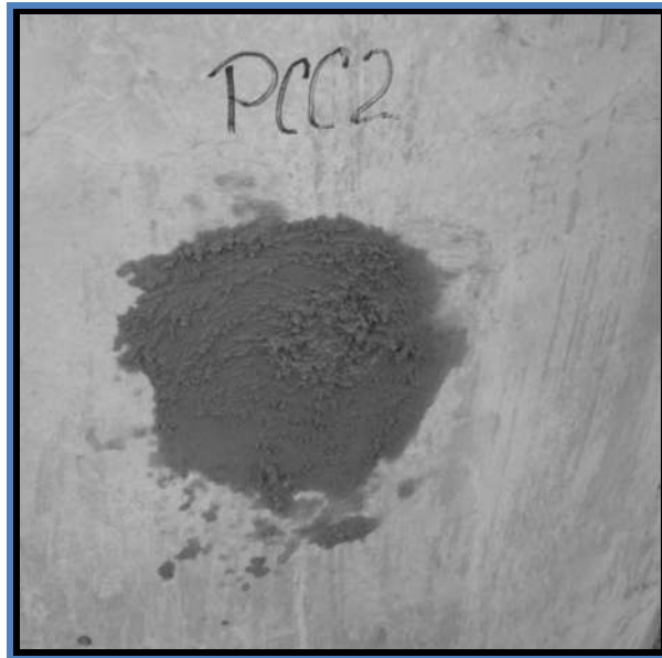
Foto VI.11 Relleno con mortero por la extracción del núcleo. (04/JUN/2011).
