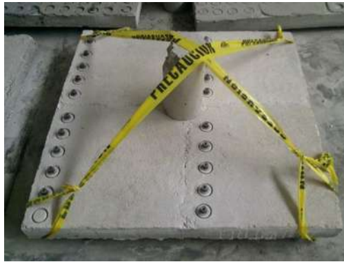
Figura 47. Colocación de recubrimiento en losa.
