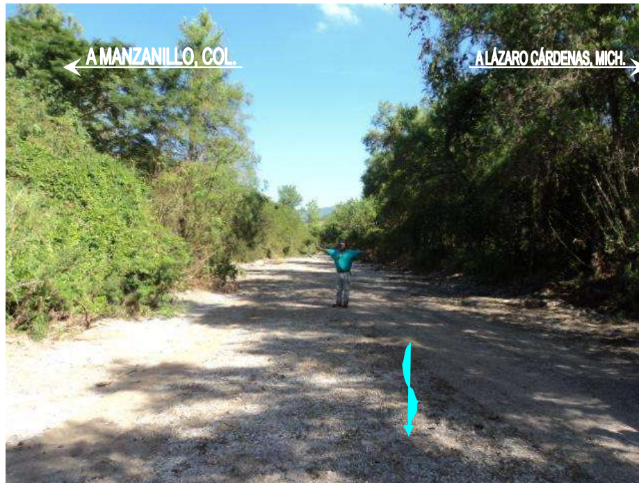
Imagen 57. Vista general de la zona de cruce donde se construye el Puente Las Peñas (nuevo); fotografía tomada a partir de 40 m aguas abajo.
