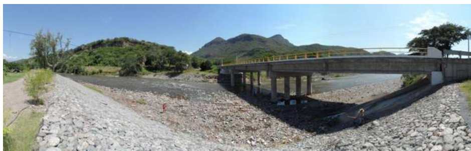
Imagen 11. Vista Panorámica hacia Zitácuaro del Puente Tuzantla.
