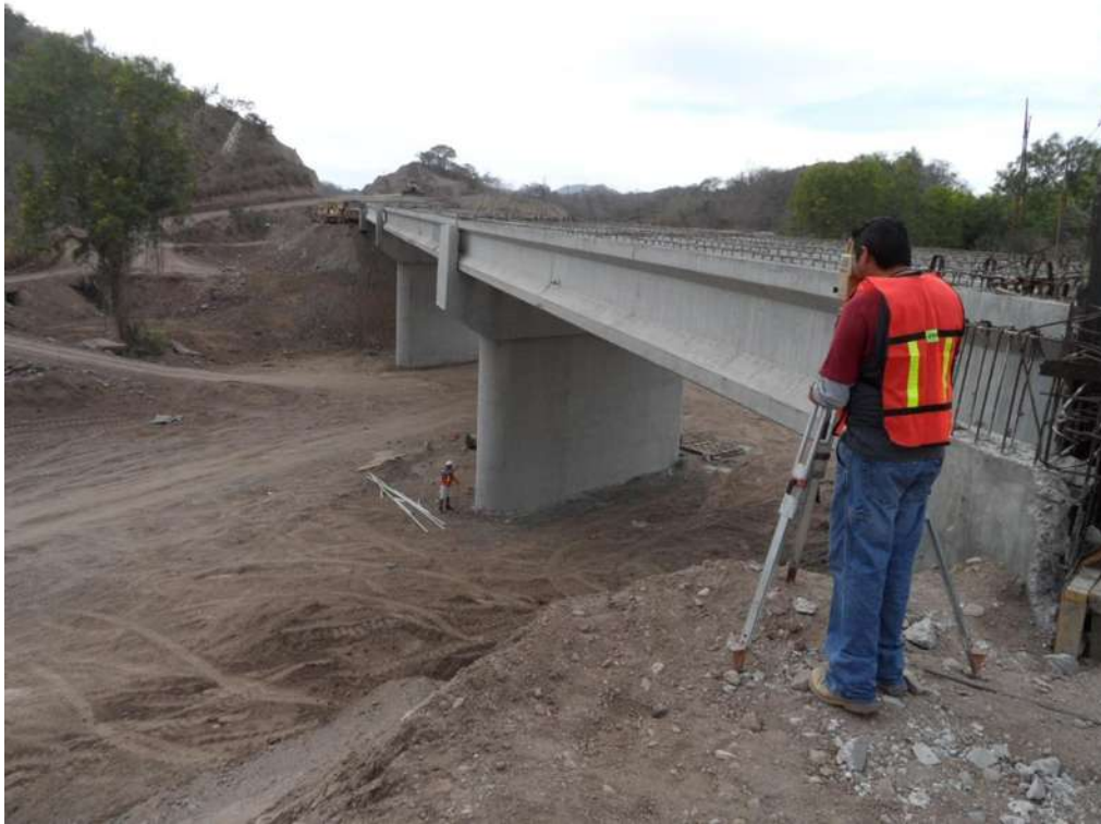
Imagen 62. Imagen de la salida del puente Las Peñas.
