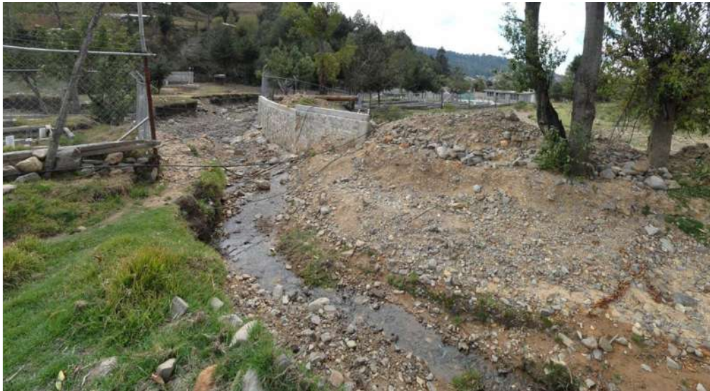
Imagen 40. Panorama aguas debajo de la losa nueva, donde se aprecia la delimitación del cauce con el centro piscícola de la población de San Luis en el municipio de Ocampo, Mich.
