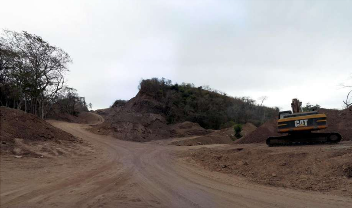
Imagen 80. Vista aguas abajo del acceso al puente El Rangel.
