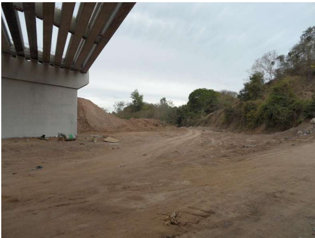
Imagen 67. Vista aguas abajo del puente Las Peñas.
