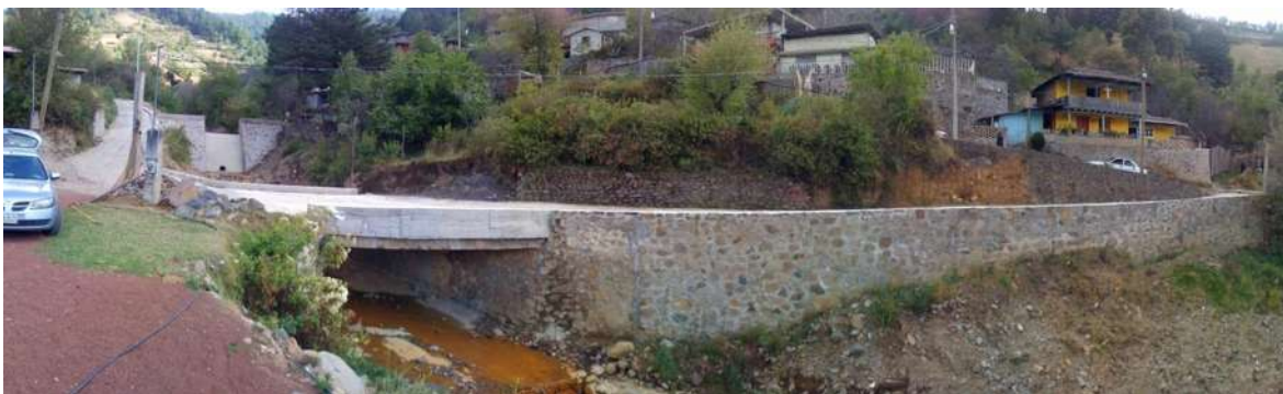
Imagen 22. Vista de la Losa aguas arriba, donde se puede apreciar el muro de contención colocado para direccionar el cauce y soportar la vialidad.
