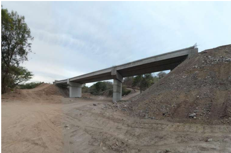
Imagen 65. Panoramas de la entrada del puente Las Peñas donde se aprecian los terraplenes de acceso, estribos y pilas.
