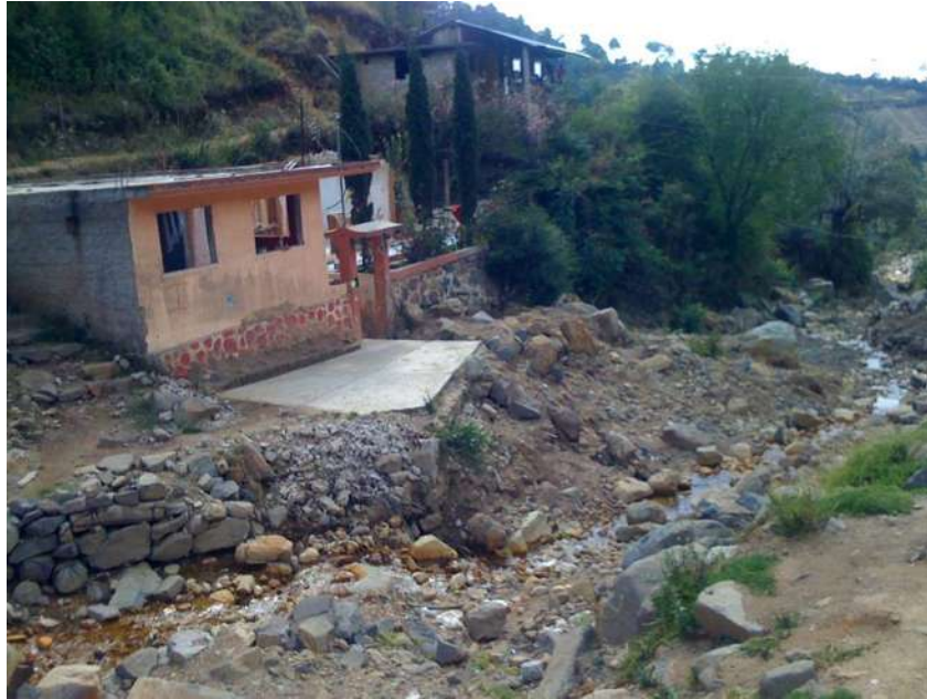
Imagen 30. Vista aguas abajo, se muestra el cauce y una construcción afectada.
