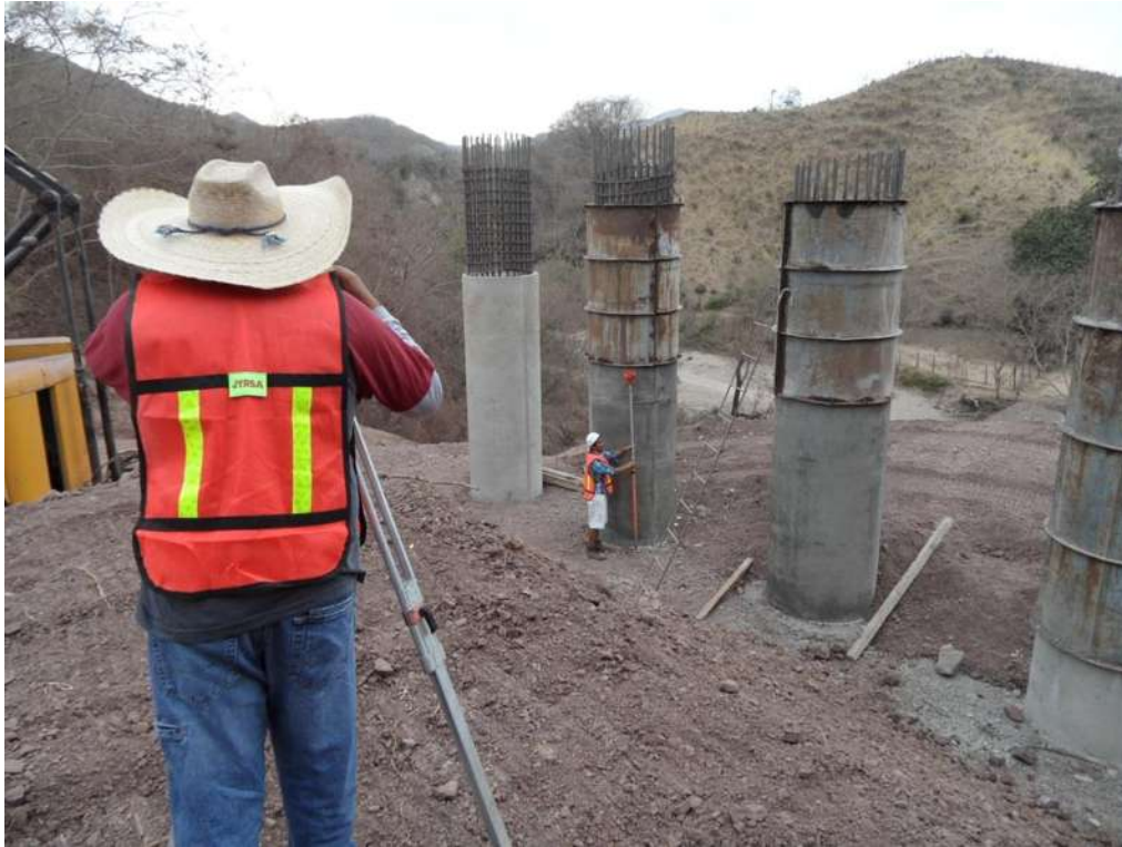
Imagen 78. Vista de las pilas del puente El Rangel.
