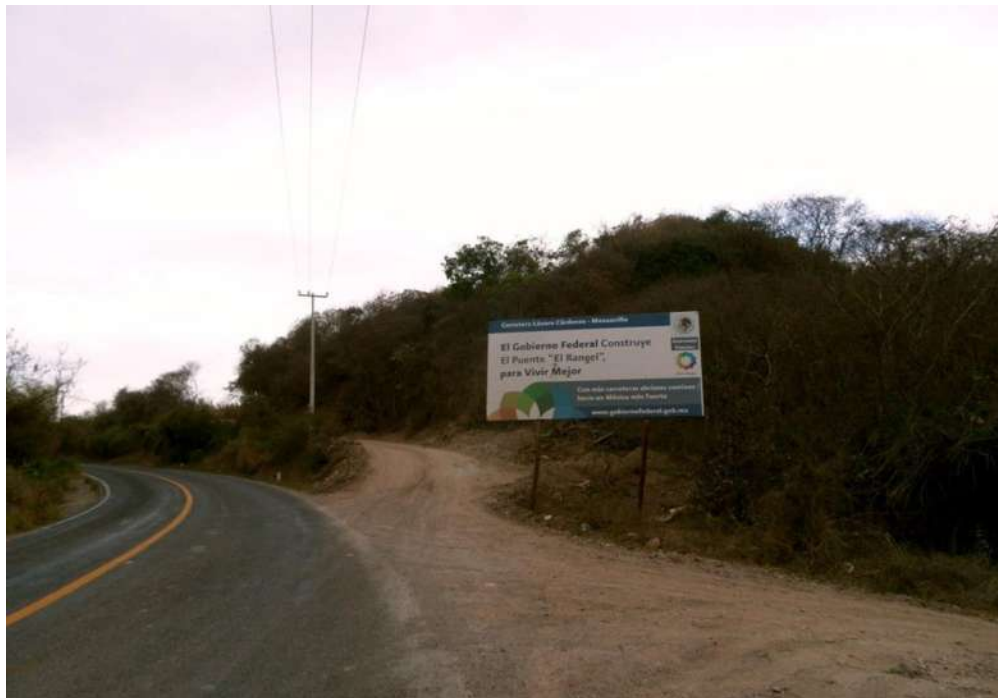
Imagen 75. Vista del acceso provisional al puente El Rangel (nuevo).
