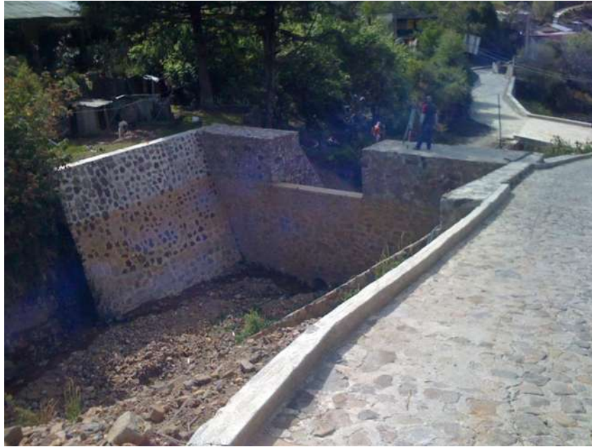
Imagen 25. Vista aguas de la Presa Rompe Picos.
