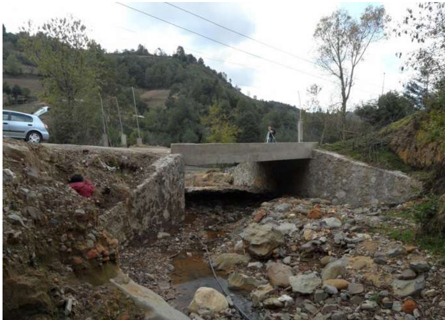
Imagen 38. Panorama aguas abajo donde se aprecia la entrada de la nueva losa y el tipo de material sedimentado a la entrada.
