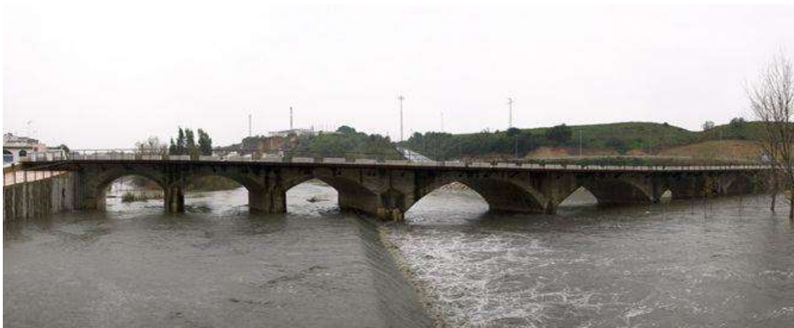
Imagen 5. Obra de drenaje con área hidráulica saturada.
