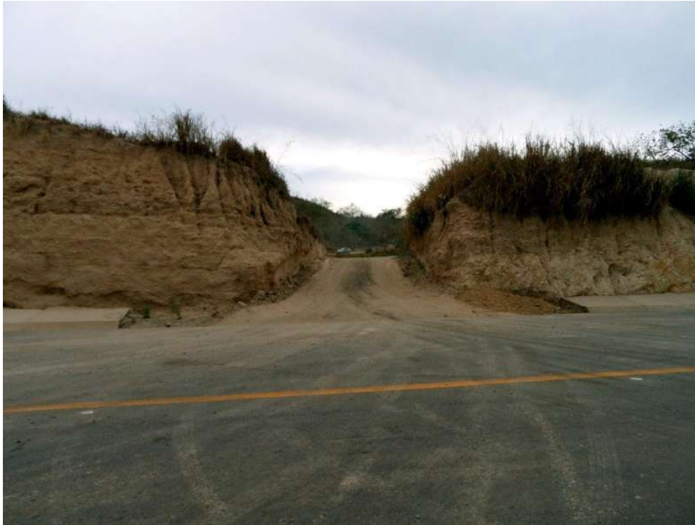
Imagen 76. Vista del entronque del acceso provisional con el tramo nuevo.
