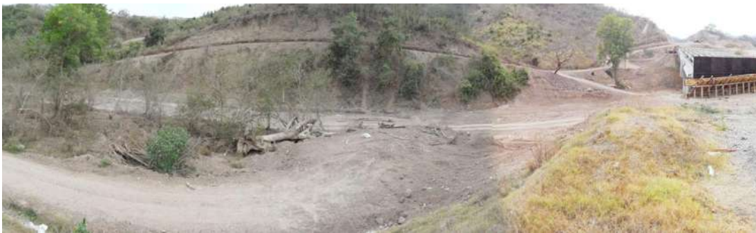
Imagen 63. Panorama aguas abajo donde se aprecia la salida del puente Las Peñas.
