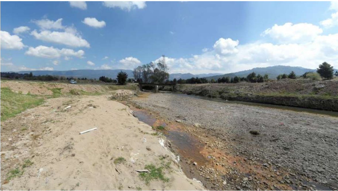
Imagen 52. Panorama aguas arriba de la salida del puente reparado.
