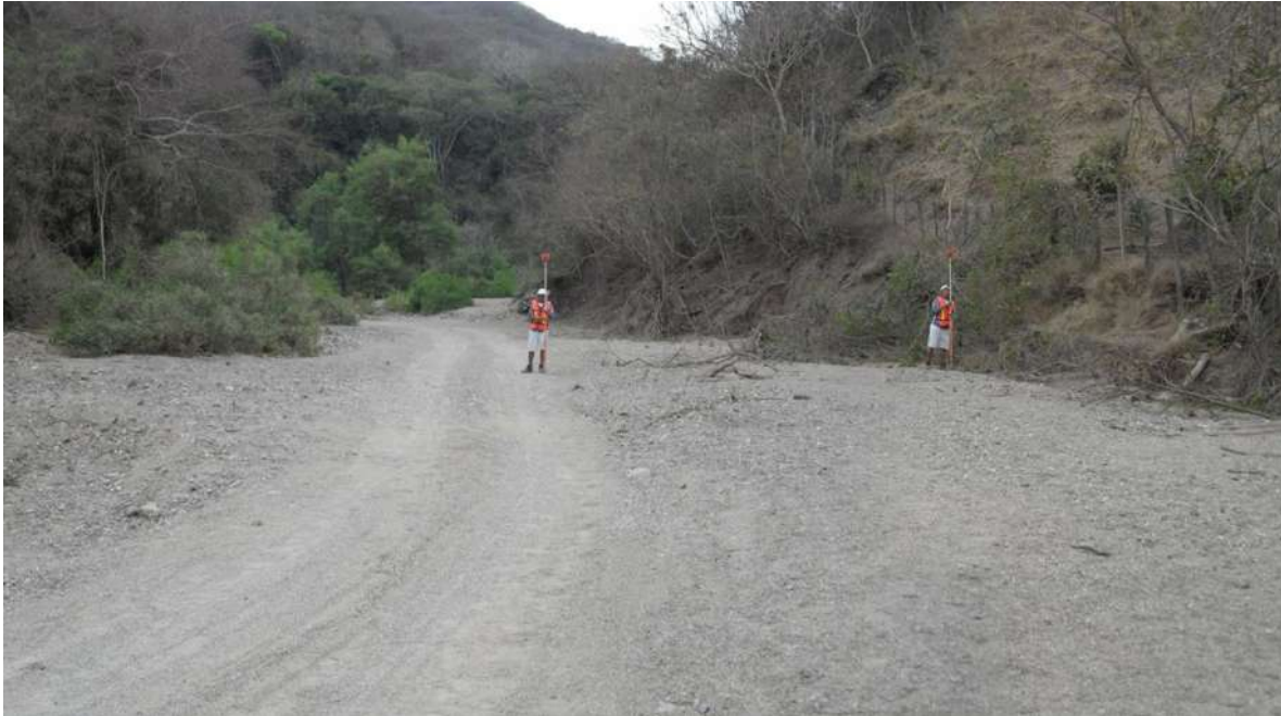
Imagen 82. Panorama aguas arriba del puente El Rangel (nuevo).
