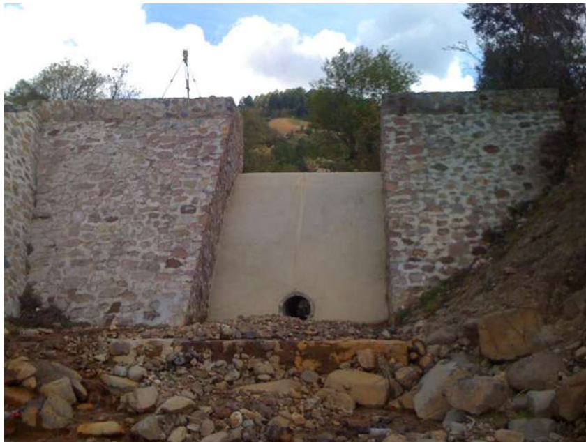
Imagen 24. Presa Rompe Picos aguas arriba de la Obra, con tubería de concreto de 60 cms de diámetro.
