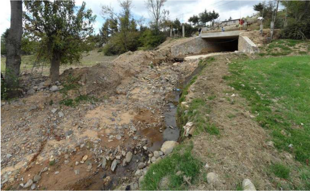
Imagen 39. Panorama aguas arriba de la salida de la losa nueva.
