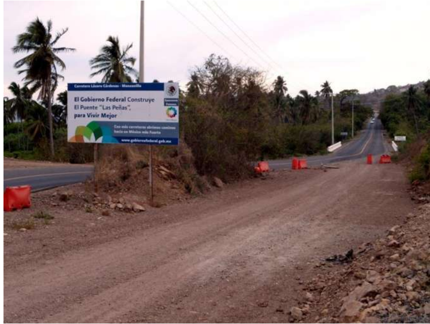
Imagen 60. Vista del puente Las Peñas original.
