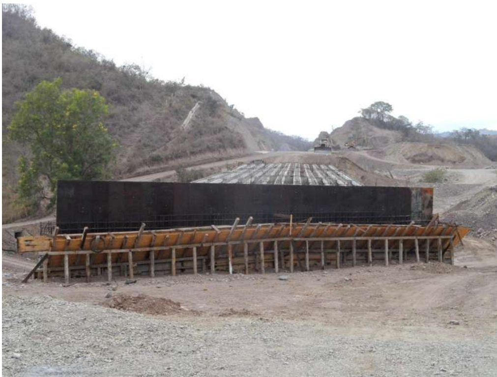
Imagen 69. Vista del puente Las Peñas (nuevo) en proceso de construcción.
