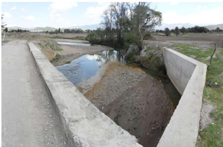
Imagen 48. Panorama aguas arriba del puente, donde se aprecia el muro de contención colocado para direccionar el cauce a la entrada de la obra.
