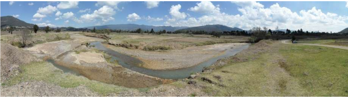
Imagen 56. Panorama aguas arriba del puente, donde se aprecia el meandro del cauce antes de la obra de drenaje.
