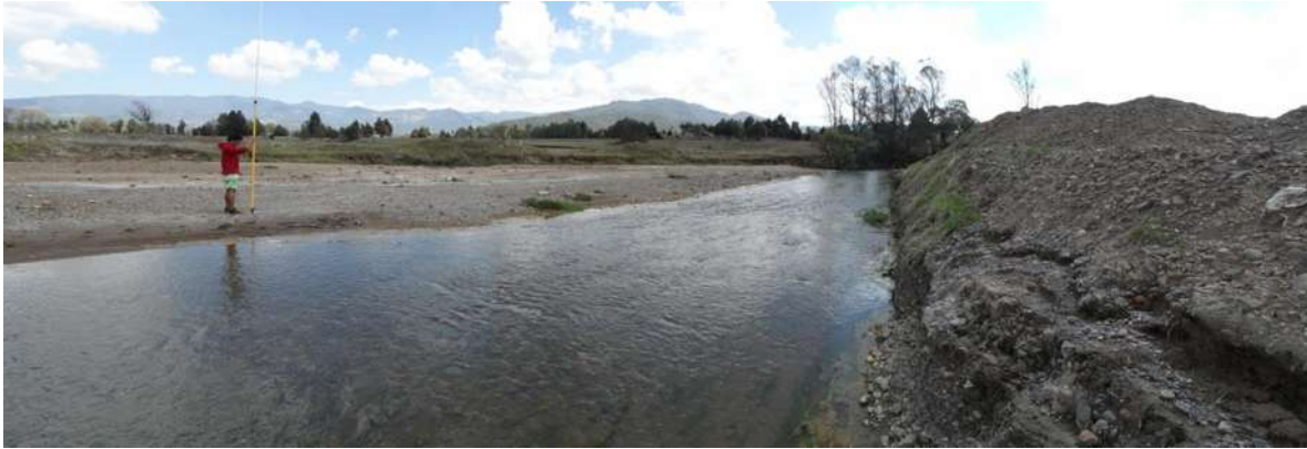
Imagen 53. Panorama aguas abajo del puente, donde se aprecia el material transportado y depositado que fue desalojado y colocado en la margen izquierda del cauce.
