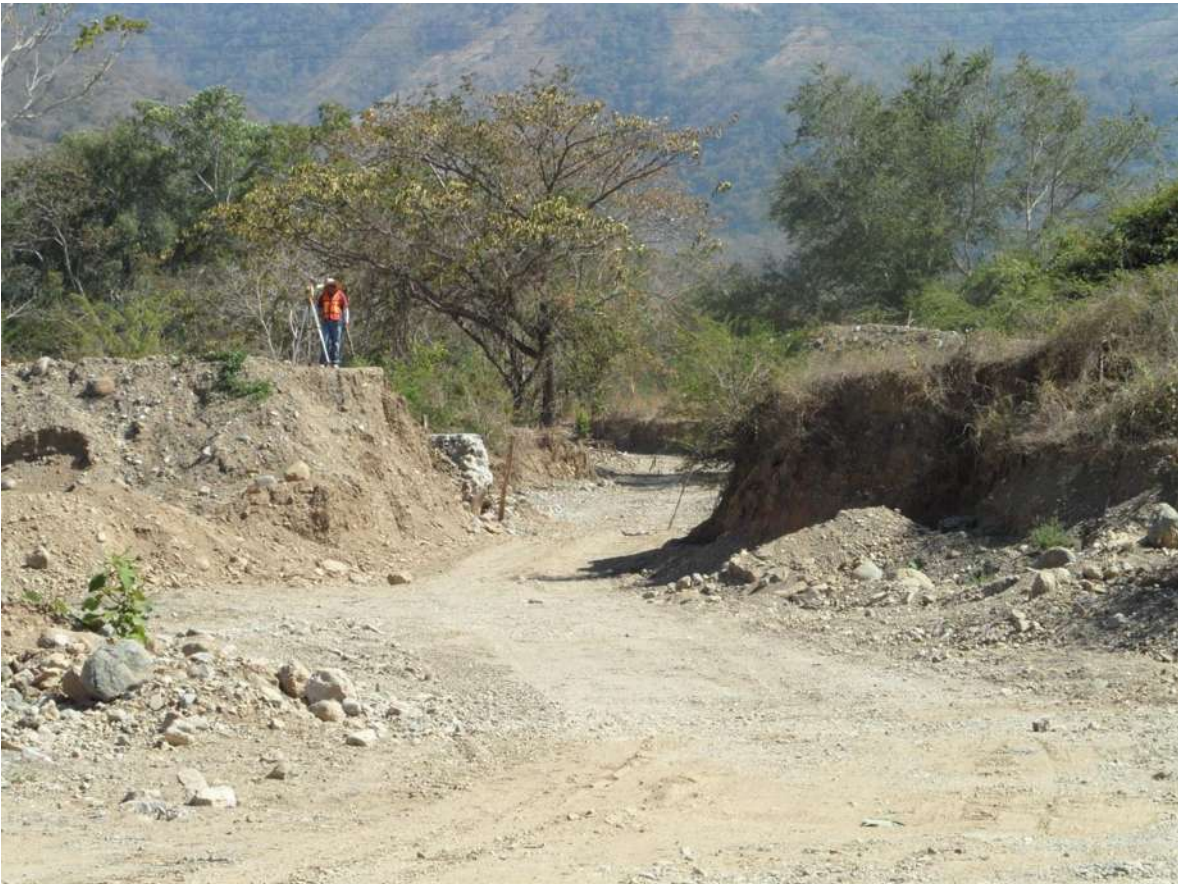
Imagen 92. Salida del Puente Palos Marías.
