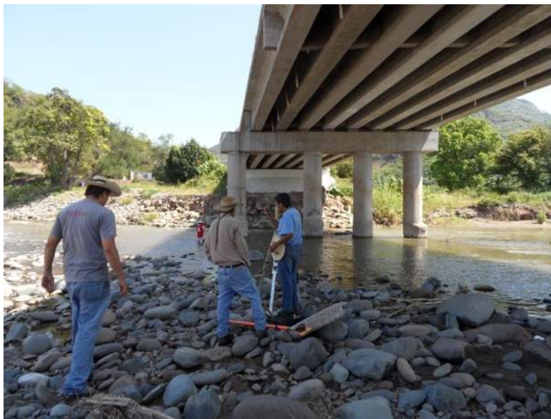
Imagen 16. Vista de la brigada bajo el Puente Tuzantla.
