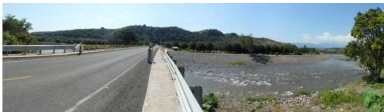
Imagen 10. Vista Panorámica sobre el Puente Tuzantla.
