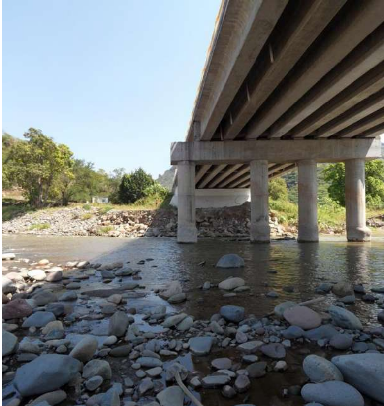
Imagen 12. Vista Panorámica bajo el Puente Tuzantla.
