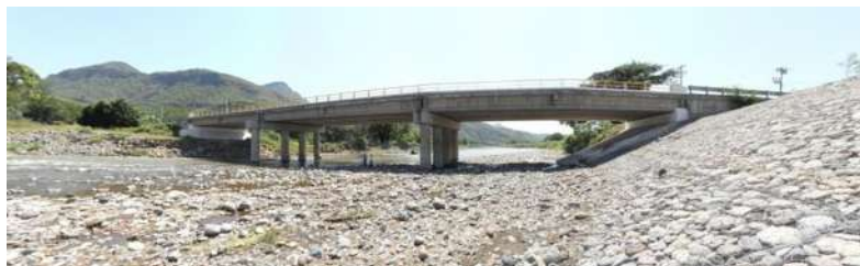
Imagen 14. Vista Panorámica Puente Tuzantla.
