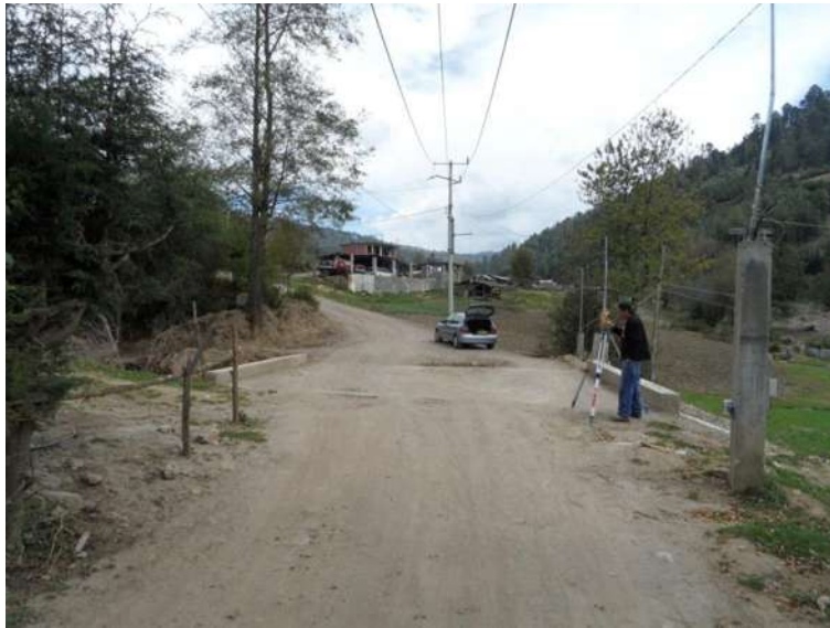
Imagen 35. Vista de la Losa Reconstruida.
