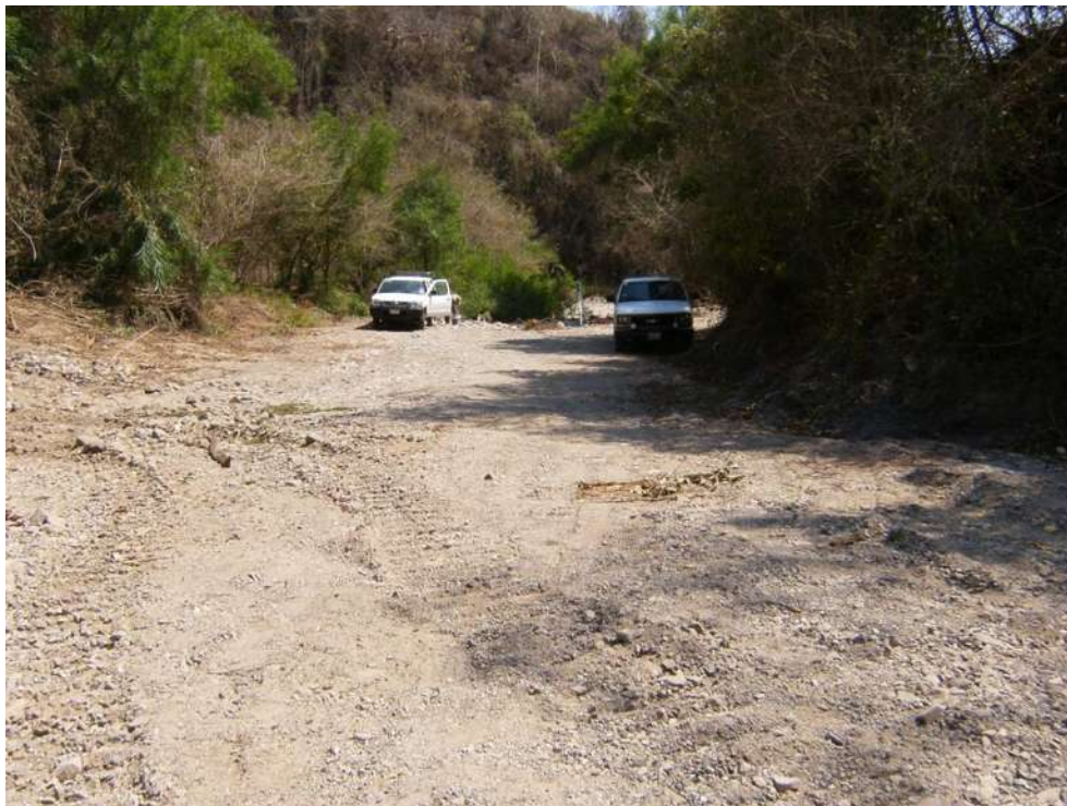
Imagen 71. Km. 35+650 Vista hacia Aguas Abajo desde sitio de cruce.
