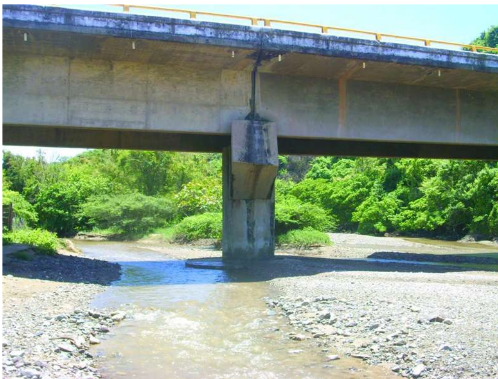
Imagen 73. Estructura del puente El Rangel (original).
