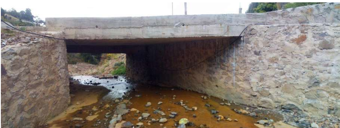
Imagen 21. Vista de la Losa aguas abajo.
