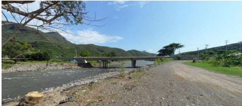
Imagen 8. Vista Panorámica aguas abajo del Puente Tuzantla.
