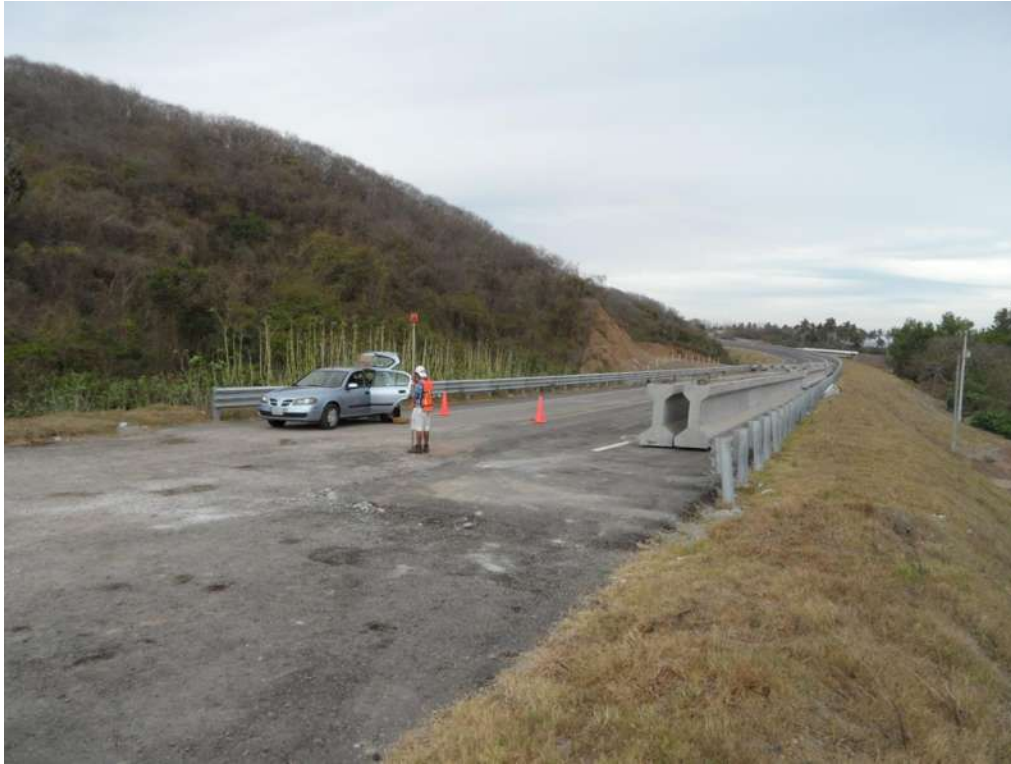
Imagen 68. Vista del acceso al puente Las Peñas (nuevo).
