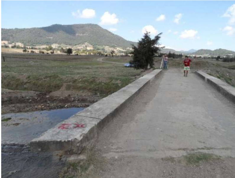
Imagen 47. Vista del puente reparado.
