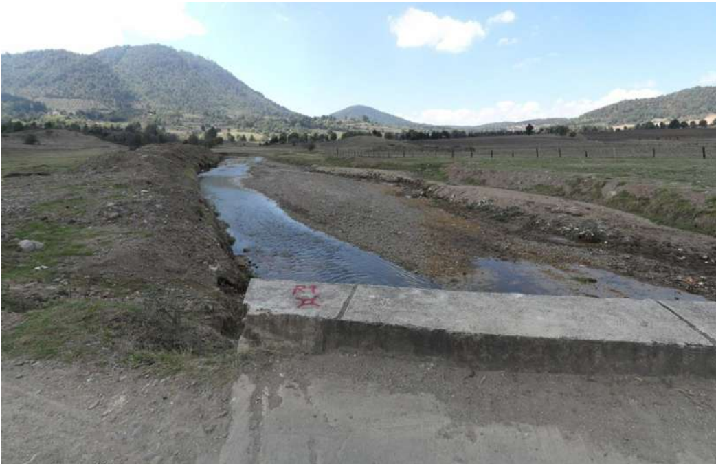
Imagen 50. Panorama aguas abajo donde se aprecia la ubicación del Thalweg y las márgenes del cauce con material depositado después de la creciete de febrero del 2010.
