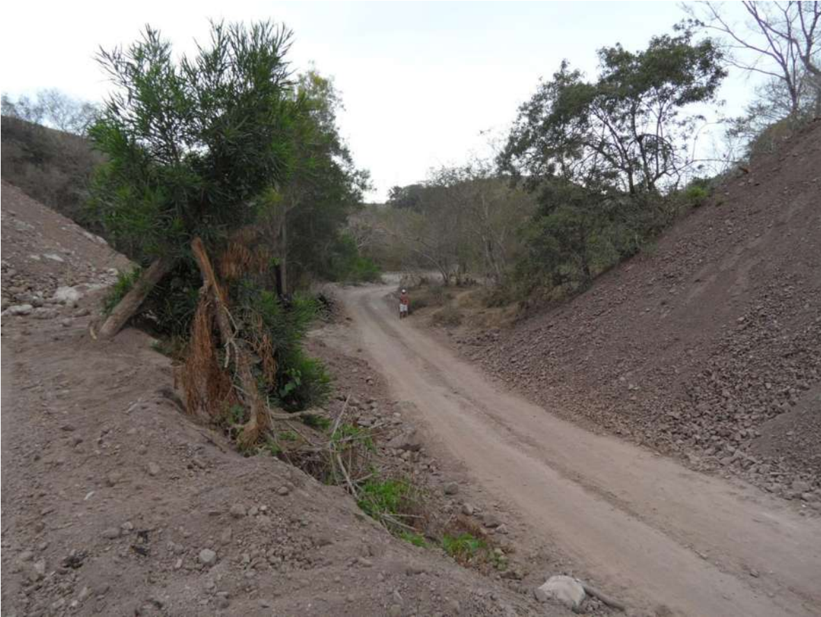
Imagen 84. Vista aguas abajo del puente El Rangel (nuevo).
