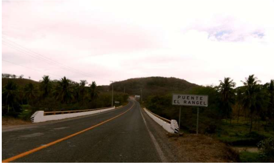
Imagen 74. Vista del puente El Rangel (original).
