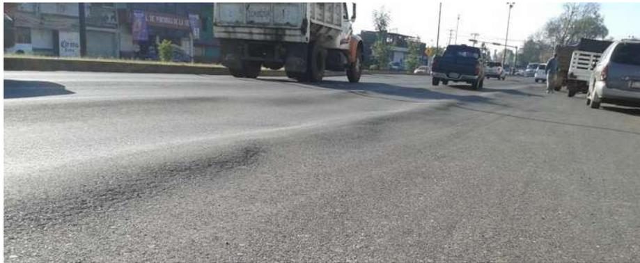
*Figura IV.- Superficie de rodamiento con deformación permanente.*
